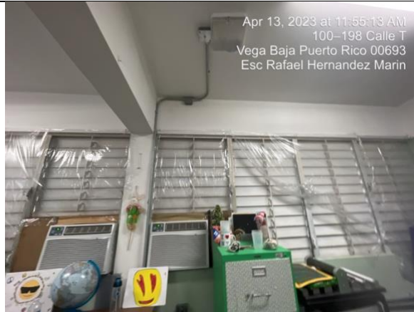
Salón 4to Sra Cruzado segundo nivel – Filtración, screen de ventana plasticos y 8 ventanas no abren.
