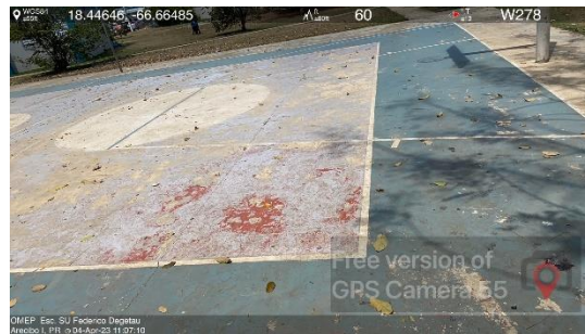
Ilustración 24. Pintura y marcado de Líneas en Cancha No.1
