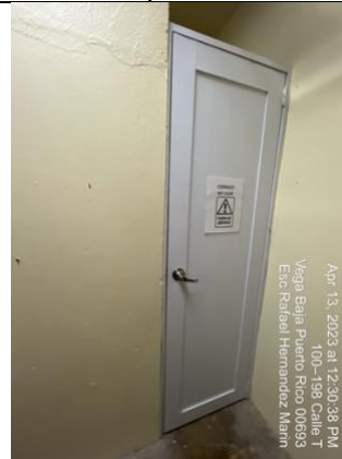
Salón Kinder Sra Otero baños – inodoro dañado
