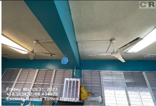
Ilustración 11. Reemplazo de Abanicos
