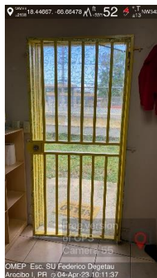
Ilustración 9. Reja de Puerta para instalar metal perforado (para que no metan la mano)
