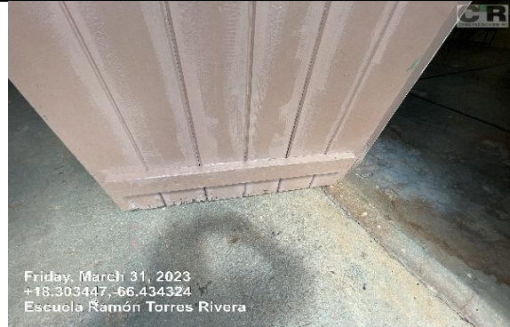
Ilustración 12. Reemplazo de puertas 7mo grado
