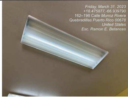
Ilustración 18. Luces de tubos 4ft LED
