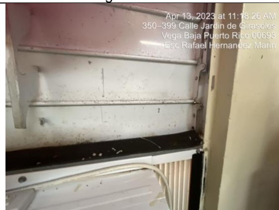
Salón psicología y terapia - instalación de 3 operadores de ventana
