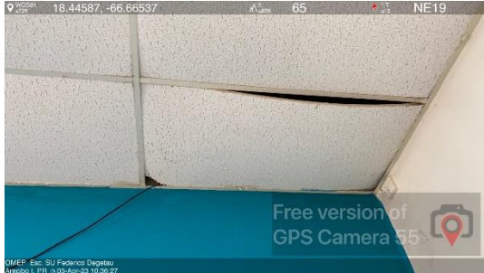
Ilustración 1. Plafones Acústicos para cambiar
