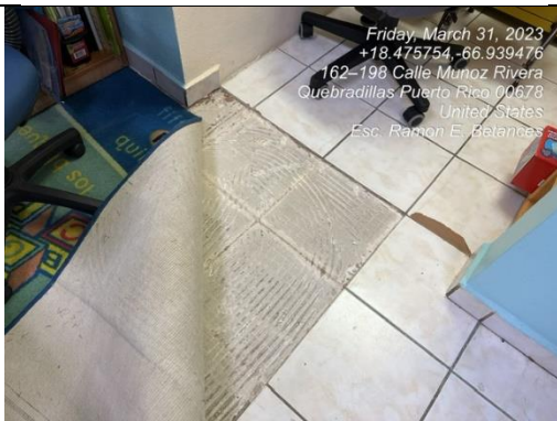
Ilustración 19. Losas despegadas
