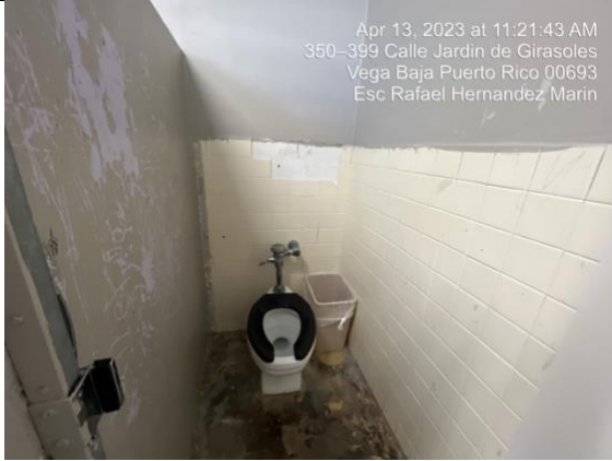
Baño niñas frente al comedor - reparación de lozas
