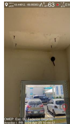
Ilustración 22. Unidades de Aire Acondicionado para Instalar en Salón de Sra. Rubí del Edif.H
