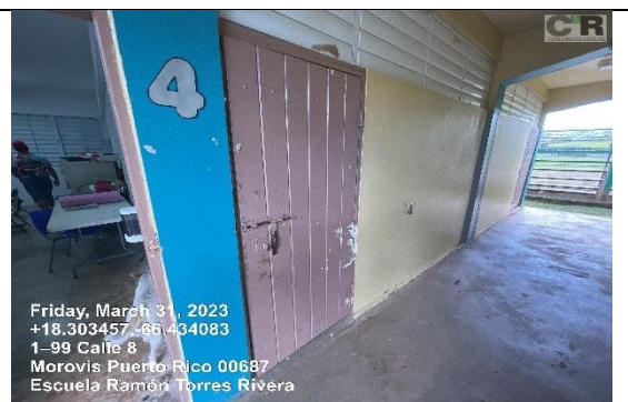
Ilustración 4. Reemplazo de puerta
