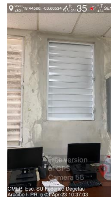
Ilustración 4. Screens de Ventanas para instalar
