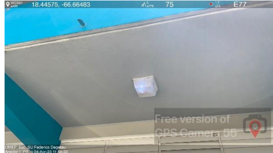
Ilustración 14. Reemplazo de Fococelda para Luminaria de Exterior
