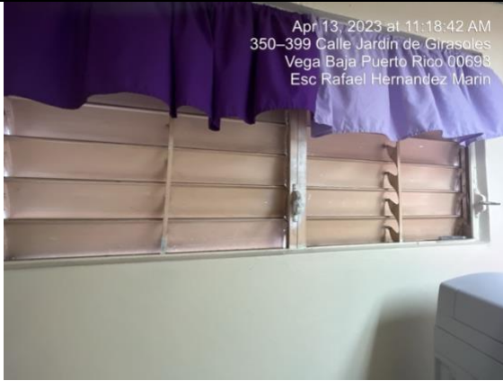
Salón psicología y terapia - reparación de ventanas que no abren
