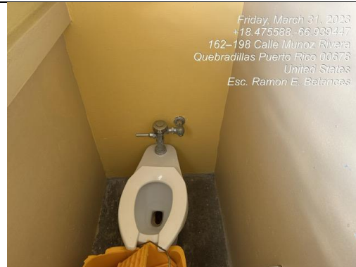
Ilustración 14. Válvula de presión
