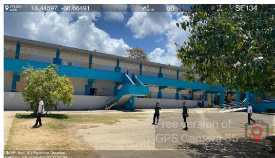
Ilustración 23. Lavado a Presión de Paredes y Plafones Exteriores, Pisos y Aceras
