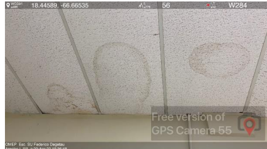
Ilustración 2. Plafones Acústicos para cambiar
