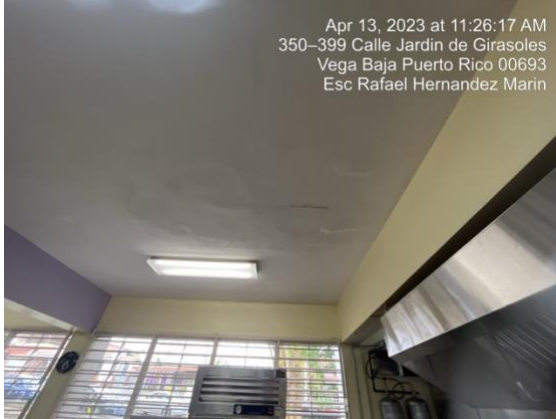
Comedor – Reparación de grietas en el techo.
