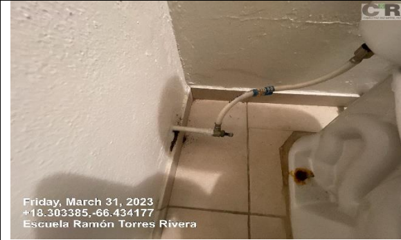
Ilustración 5. Reemplazo de Llave angular
