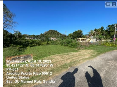
Ilustración 12. Reparación y/o construcción de verja
