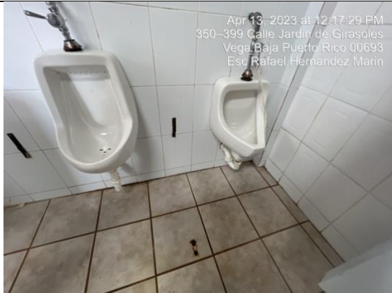
Baños lado de la biblioteca – urinal dañado, lavado de presion, primer, pintura interior
