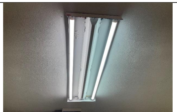
Ilustración 2. Reemplazo de luminaria (68)
