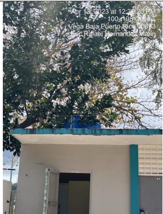
Cisternas – reparación de 2 cisternas
