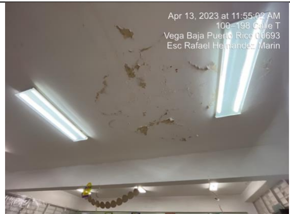
Salón 5to Santiago Segundo Nivel – Filtración y cover de alumbrado.
