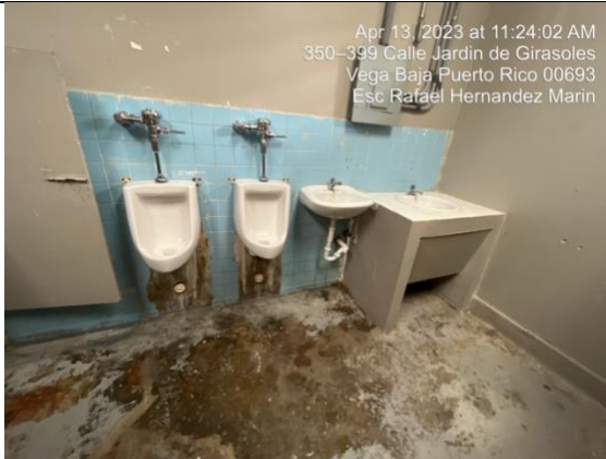
Baño niños frente al comedor - urinal dañado, lozas sueltas, llave de lavamano no cierra, lavado de presión y pulido
