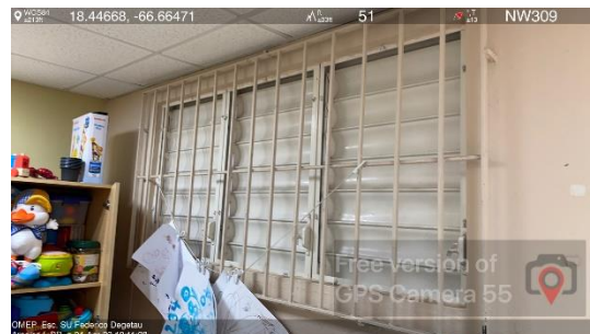
Ilustración 6. Screens de Ventanas para instalar
