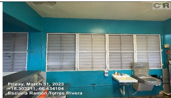
Ilustración 16. Reemplazo 'screens' y operadores
