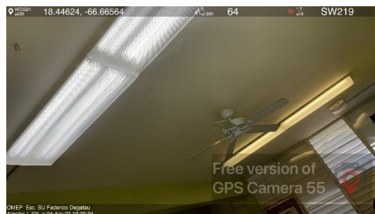
Ilustración 12. Luminaria 2'x4' para cambiar por LED de 4 tubos
