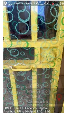
Ilustración 8. Screens de Puertas para instalar
