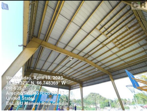
Ilustración 17. Reemplazo luminaria led
