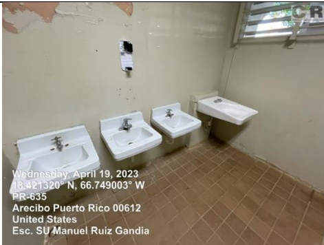
Ilustración 13. Reemplazo de lavamanos
