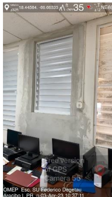
Ilustración 5. Screens de Ventanas para instalar
