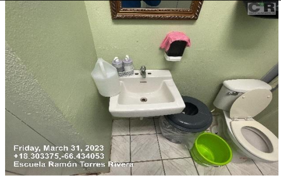
Ilustración 6. Reemplazo llave de lavamanos
