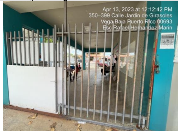
Portón – El portón está suelto. Peligro a la seguridad
