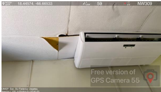
Ilustración 3. Plafones Acústicos para cambiar
