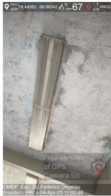
Ilustración 13. Luminaria 2'x4' para cambiar por LED de 4 tubos
