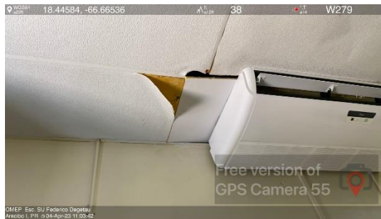
Ilustración 21. Mantenimiento de Unidades de Aire Acondicionado
