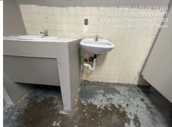
Baño niñas frente al comedor - reemplazo de plomería
