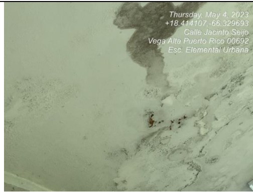
Ilustración 20. Pintura deteriorada
