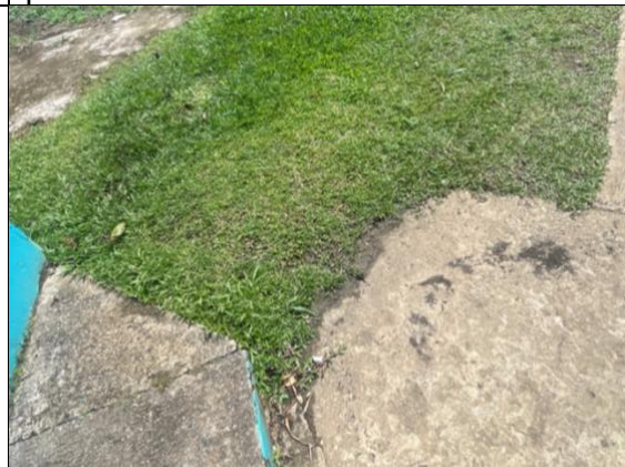
Tubería frente a baños – mantenimiento, presentan liqueo
