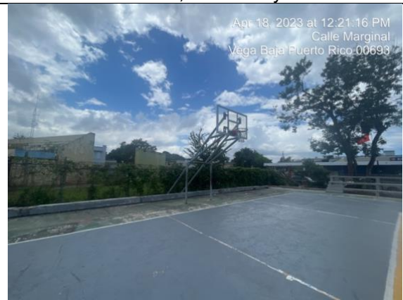
Cancha – Pintura y poda de arboles
