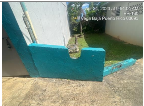
Barandal de cemento – Empañetado
