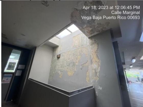
Pared frente a Salón E304 – lavado de presión, empañetado, primer y pintura
