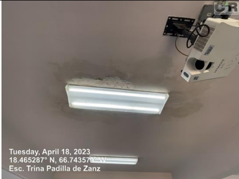
Ilustración 11. Reparación y empañetado de techo
