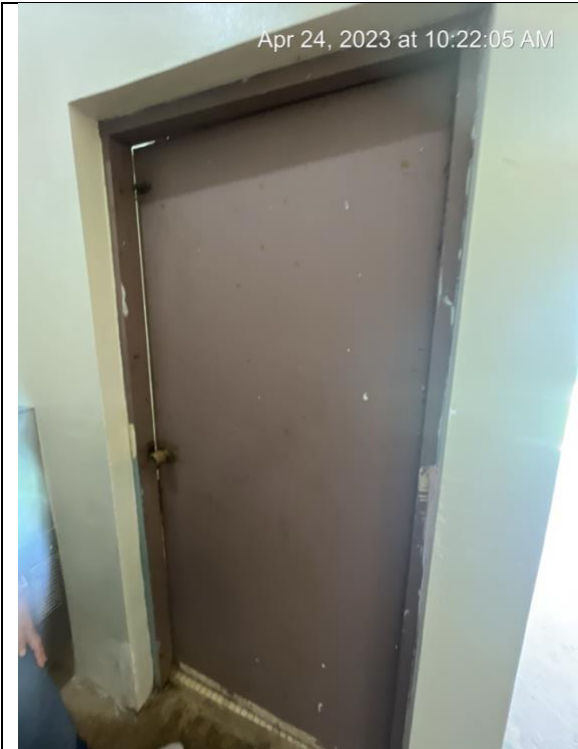
Salón Educación Especial 2 – remplazo de puerta de baño
