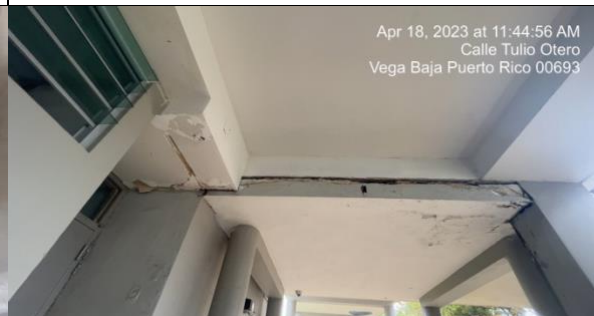
Junta de expansión frente al E101 – mantenimiento
