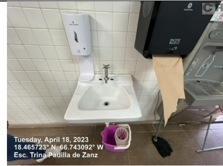
Ilustración 8 Reemplazo de mezcladora
