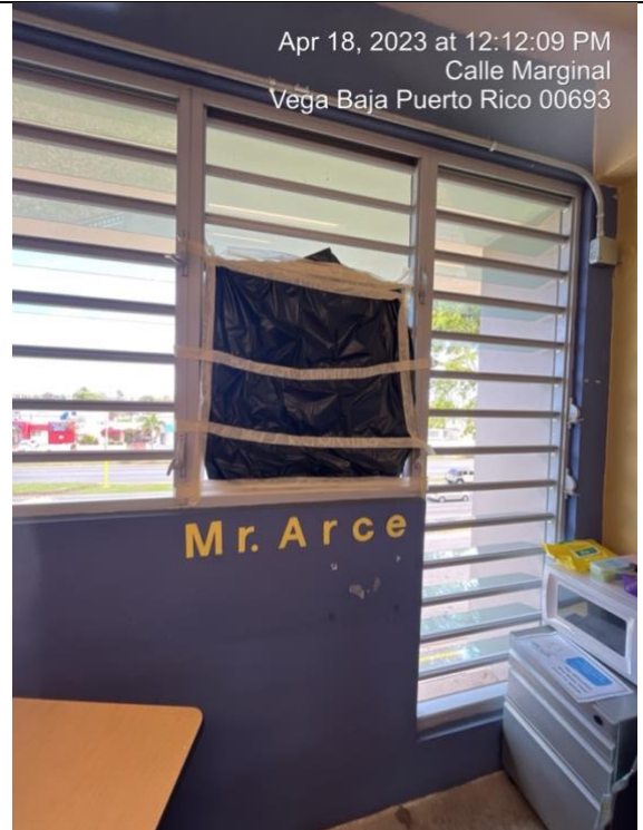
Salón Sra. Arce C306 – Reparación ventana de cristal 2
