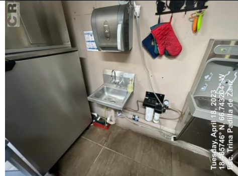
Ilustración 12. Reemplazo mezcladora fregadero
