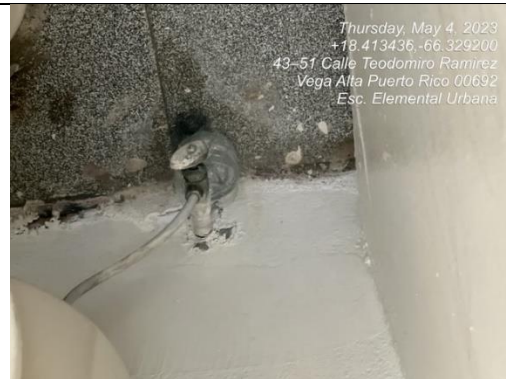
Ilustración 16. Fitting dañado
