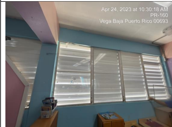
Salón Prekínder – 2 luminarias fundidas, 7 operadores de ventana, 12 screen plásticos de ventana, 3 screen de puerta
