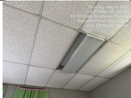
Ilustración 14. Lampara dañada
