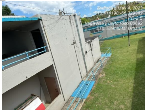
Ilustración 22. Pintura deteriorada
