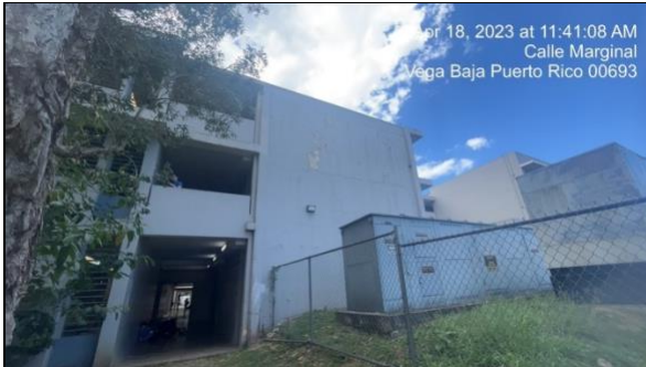
Pared aledaña a subestación – lavado de presión, reparación de grietas, primer y pintura
