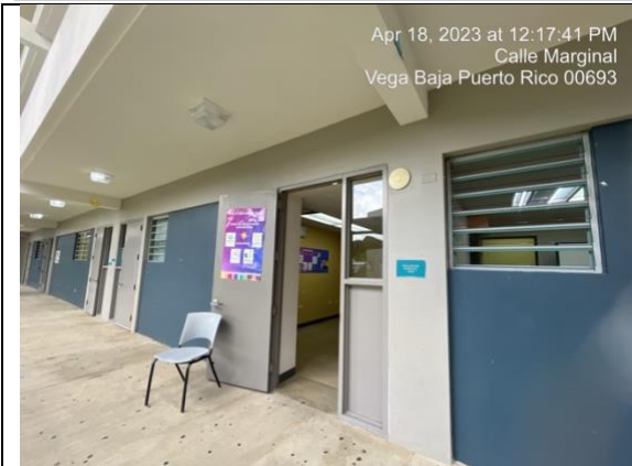
Salón C102 – aire dañado y foco del pasillo
