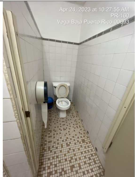
Salón de kínder baños – Reemplazo de 2 inodoros pequeños y las puertas divisoras de los baños no cierran
