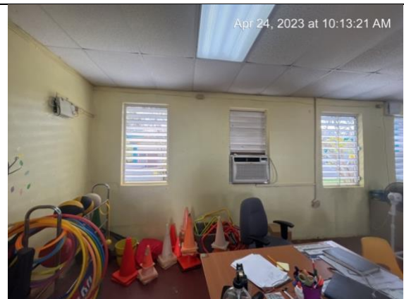
Salón Educación Física – 1 aire dañado, 8 screen de ventana, 2 screen puertas, 3 operadores de ventanas, problema eléctrico, 1 reja de aire parte exterior
