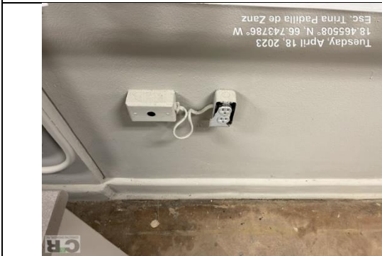
Ilustración 19. Reemplazo de receptáculo
