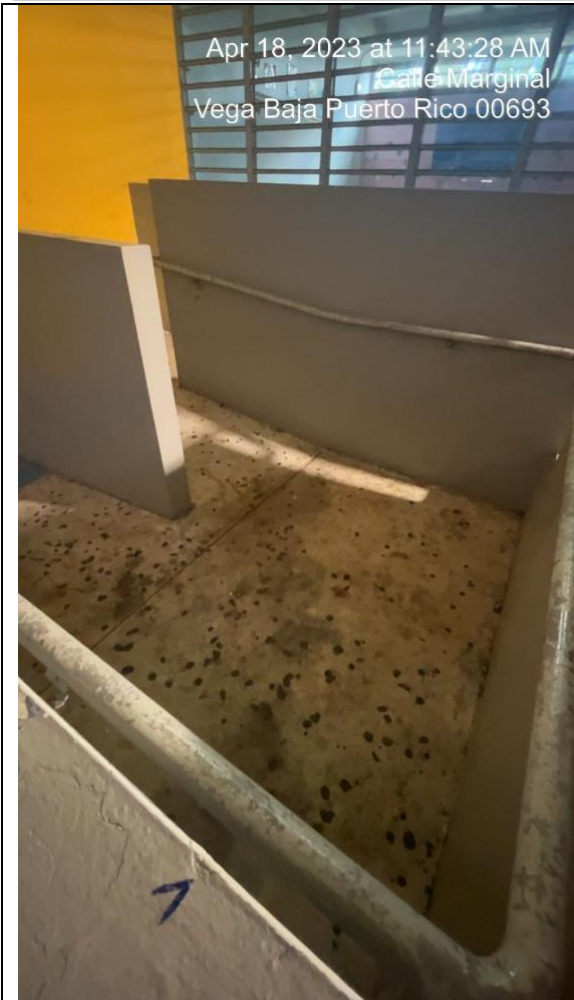
Rampa Educación Especial – lavado de presión, primer, pintura
