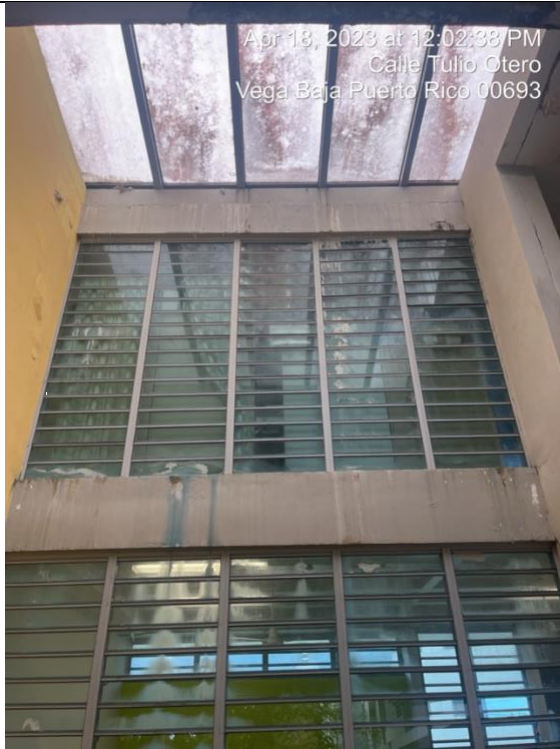
Salón Educación Especial – lavado de presión, primer y pintura
