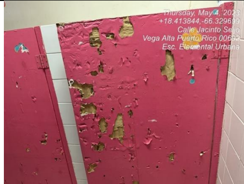
Ilustración 6. Puertas de partición con comején
