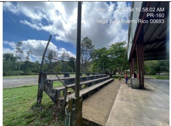
Gradas – lavado de presión, empañetado, techo, primer y pintura
