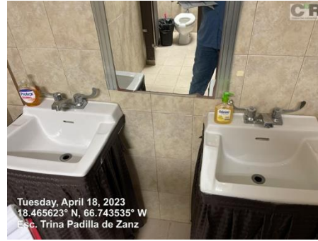
Ilustración 6. Reemplazo mezcladora
