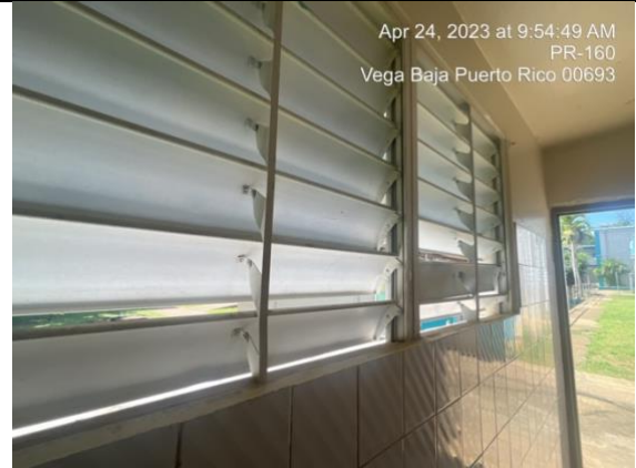
Baño de varones – operadores de ventana
