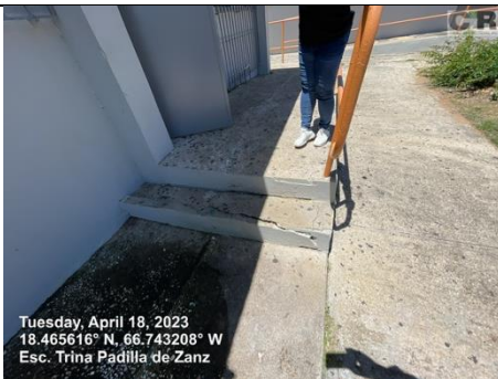
Ilustración 15. Reparación escalón comedor
