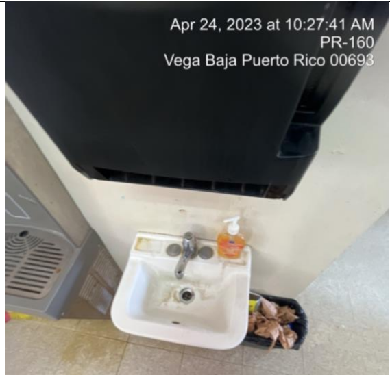
Salón de kínder – remplazo de lavamanos pequeño
