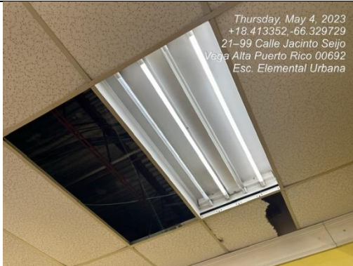
Ilustración 7. Luces fundidas y acusticos
