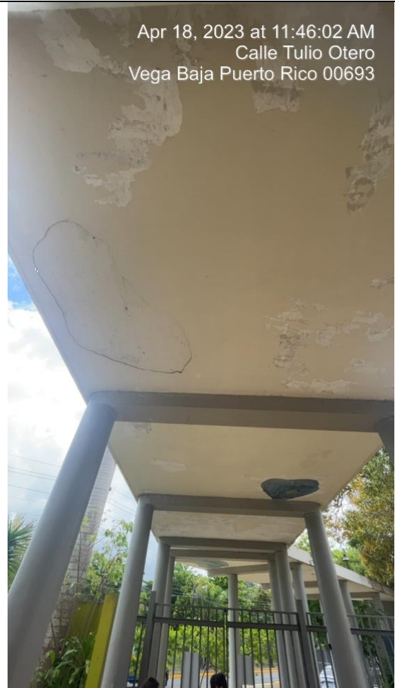
Entrada secundaria – lavado de presión, empañetado de techo, primer y pintura
