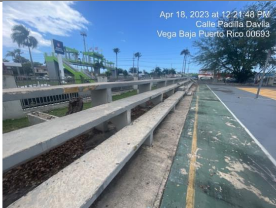
Gradas – lavado de presión, primer, pintura, barandal
