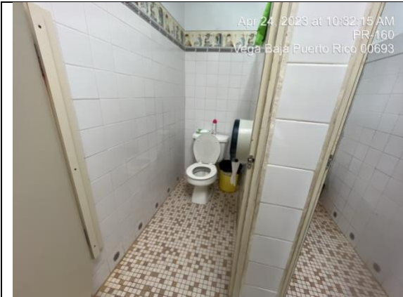
Salón Prekínder baño – remplazo de 2 inodoros pequeños
