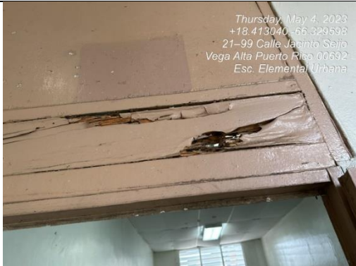
Ilustración 13. Puerta dañada
