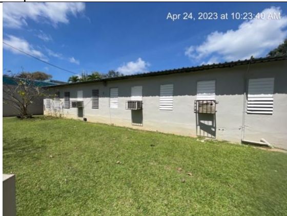
Parte posterior Educación Física – reparación de cajones de aire acondicionado
