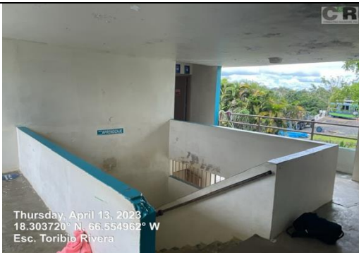
Ilustración 13. instalación de barandas
