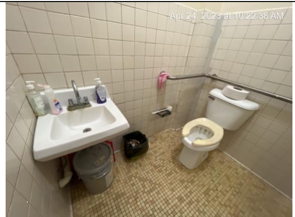
Salón Educación Especial 2 baño – remplazo de inodoro, 1 lavamanos
