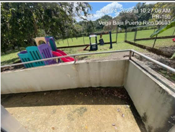
Rampa de kínder – lavado de presión, primer y pintura
