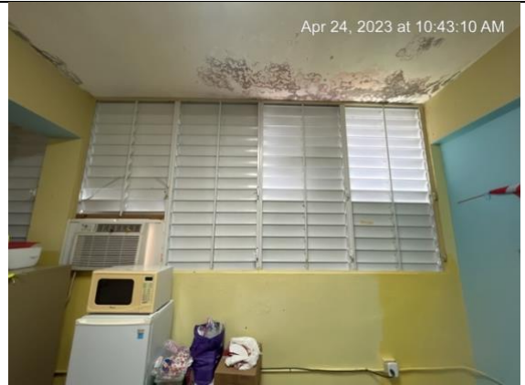
Salón Educación Especial – 6 screen de ventana plástico, 10 operadores de ventana, 1 aire acondicionado remplazo, 1 foco fundido, lavado de presión, primer, y pintura interior,
