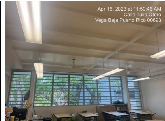
Salón E207 – Reparación de abanico y problema eléctrico
