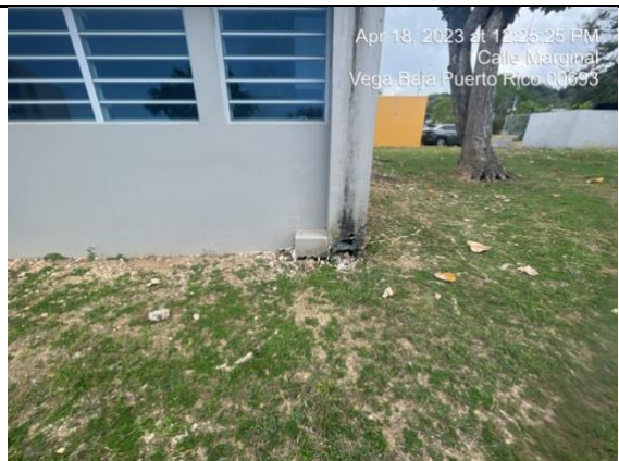
Salón D102 parte posterior – desague agrietado
