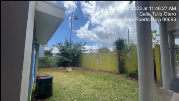
Pared frontal – lavado de presión, primer, pintura
