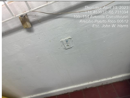
Ilustración 10. Tomacorrientes dañado
