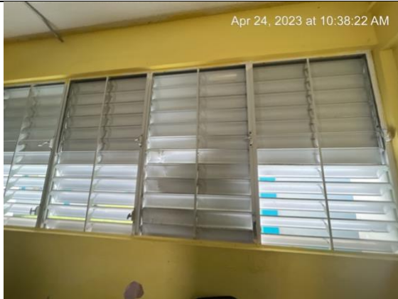
Salón Sra. Piñero – reemplazo de 1 ventana rota, 10 operadores de ventana
