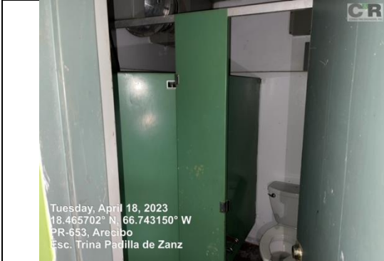
Ilustración 17. Reemplazo de inodoro
