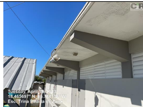
Ilustración 10. Reemplazo luminaria exterior
