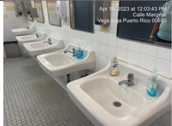
Baño de damas segundo nivel – Llaves de lavamanos sueltas y muchas se quedan abiertas. Las puertas divisoras de los baños no cierran
