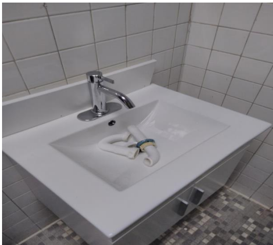
Foto 9. Instalar sifón de lavamanos.
