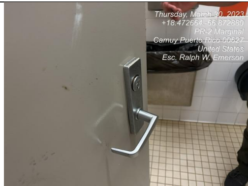
Ilustración 16. Cerradura rota
