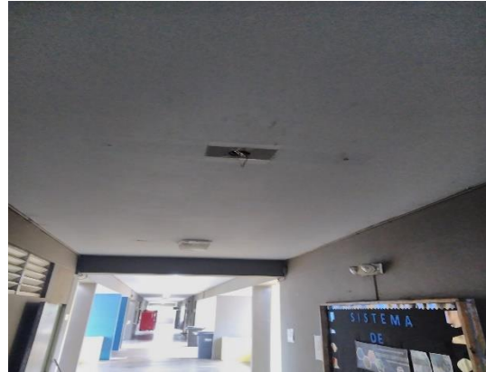
Foto 4. Proveer e instalar nueva lampara.
