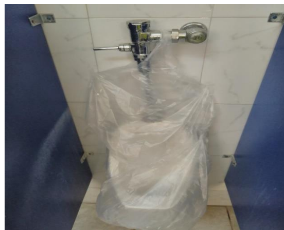
Foto 2. Reparar urinales dañados.
