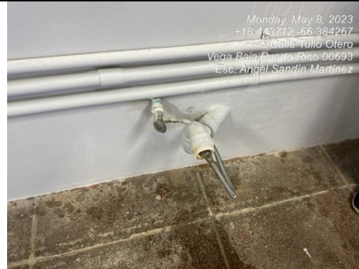
Ilustración 12. Llaves angulares dañadas
