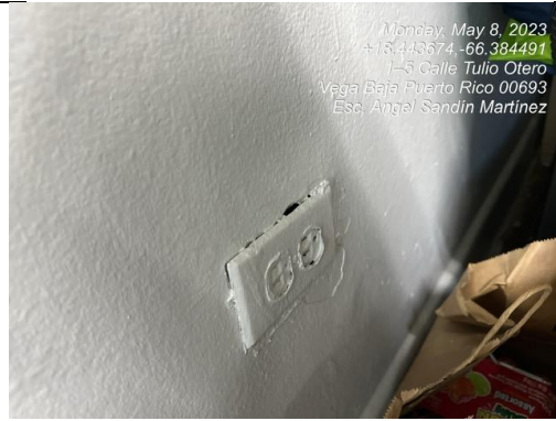
Ilustración 8. Tomacorrientes dañado
