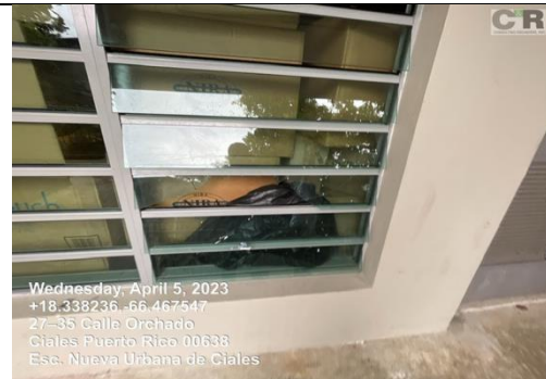
Ilustración 15. Reemplazo cristal de ventanas
