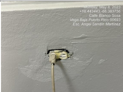
Ilustración 15. Receptáculo dañado
