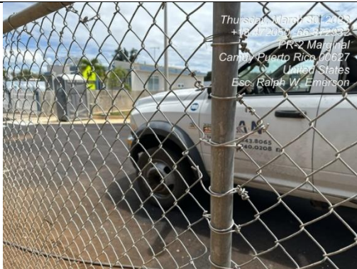
Ilustración 19. Reparación a verja de alambre eslabonado
