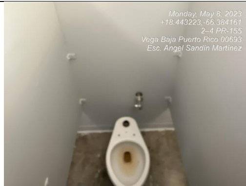
Ilustración 18. Tapa y válvula rotas
