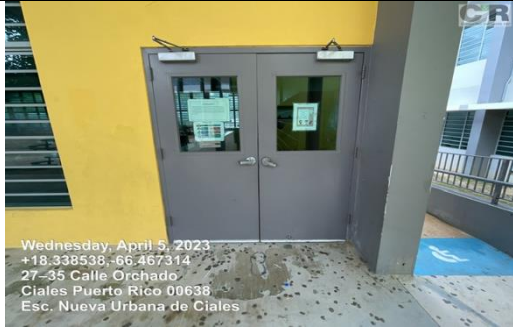
Ilustración 11. Reparación de puertas (cerradura)
