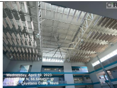
Ilustración 10. Remplazo abanico cancha
