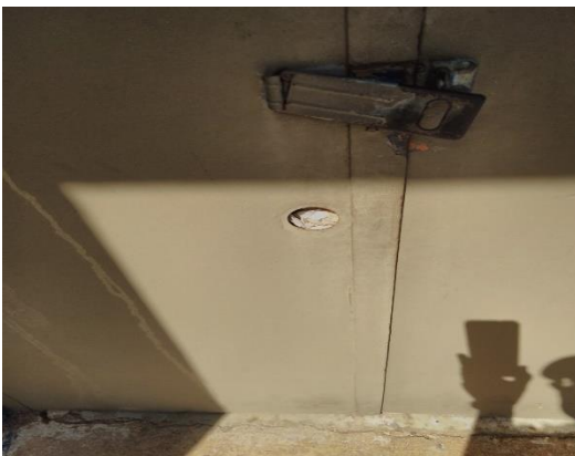
Foto 7. Reemplazar cerradura de puerta.
