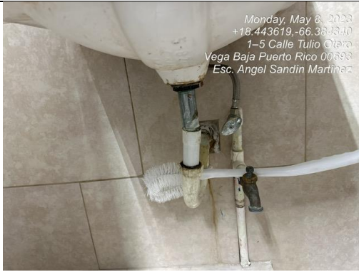
Ilustración 7. Sifón roto
