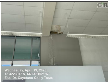
Ilustración 15. Reparación de plafón
