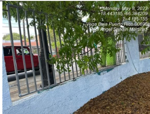
Ilustración 22. Reparación a verja
