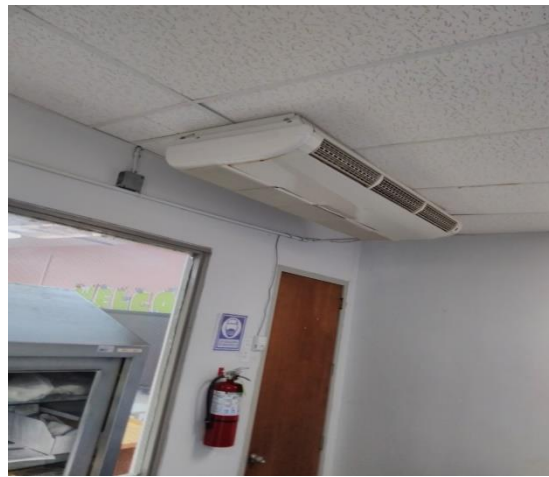
Foto 10. Reparar consola de A/C.
