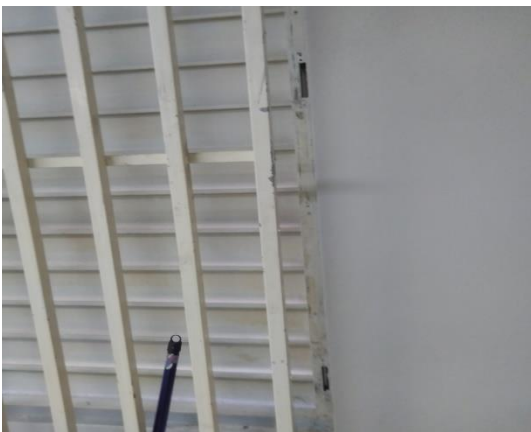
Foto 5. Suplir e instalar operadores de ventana.
