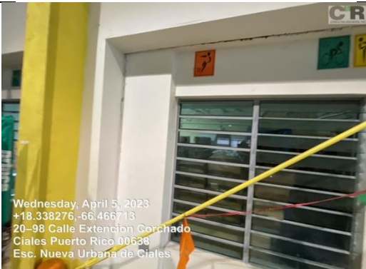
Ilustración 19. Reparación gritas columna y vigas
