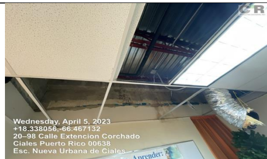
Ilustración 2. Reemplazo de Plafon
