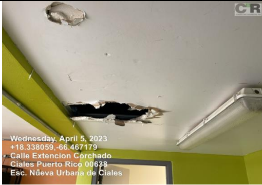
Ilustración 5. Reemplazo de Plafón
