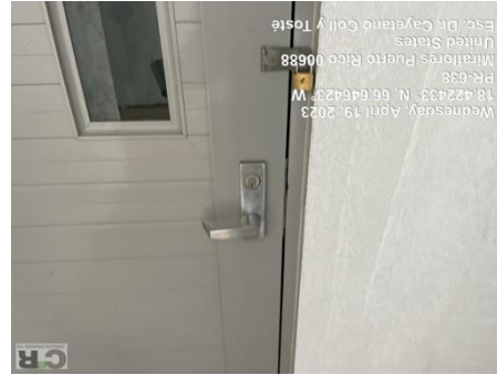
Ilustración 6. Reemplazo de cerradura
