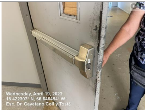
Ilustración 9. Reparación de puerta de metal
