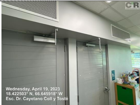
Ilustración 13. Reemplazo de cierra puertas
