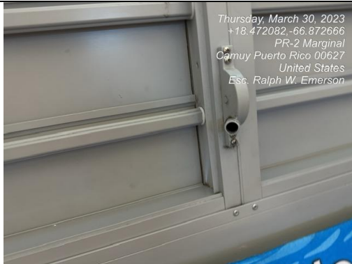
Ilustración 11. Operadores rotos
