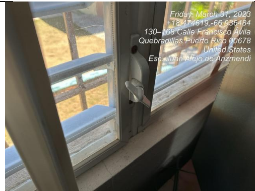
Ilustración 8. Operador dañado
