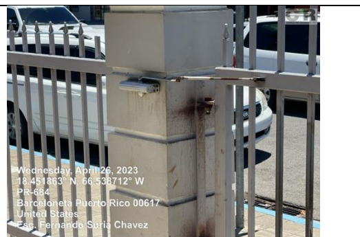
Ilustración 2. Reemplazo de (door opener)
