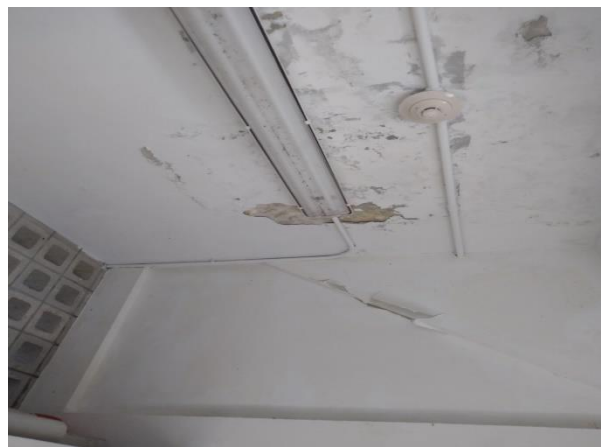
Foto 8. Reemplazar tubos fluorescentes.
