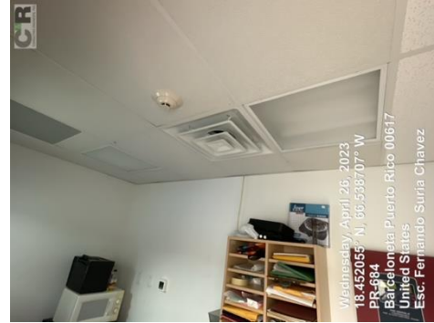
Ilustración 12. Remplazo Tubos led
