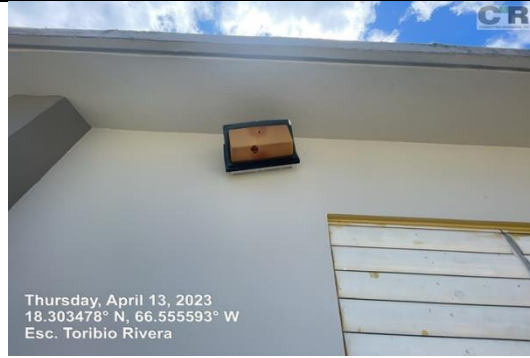
Ilustración 10. Reemplazo luminaria
