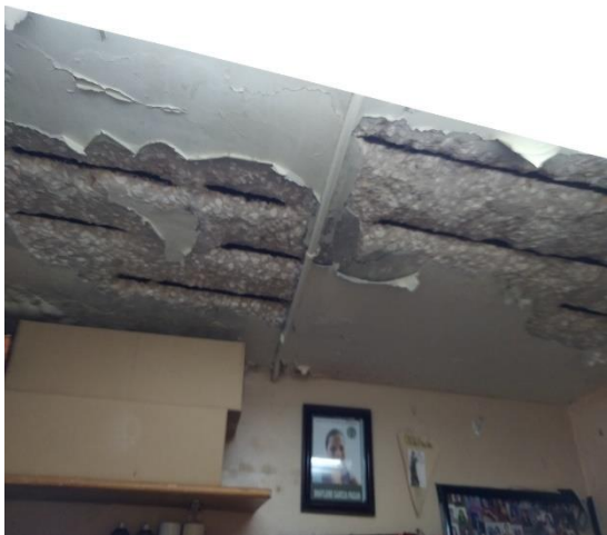
Foto 9. Reparar empañetado en almacen.
