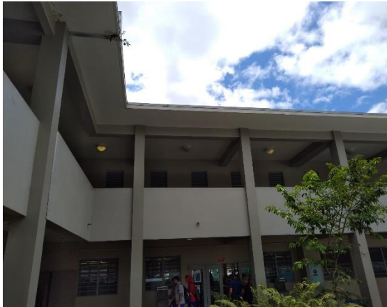
Foto 1. Lámparas de pasillo con bombillas fundidas.
