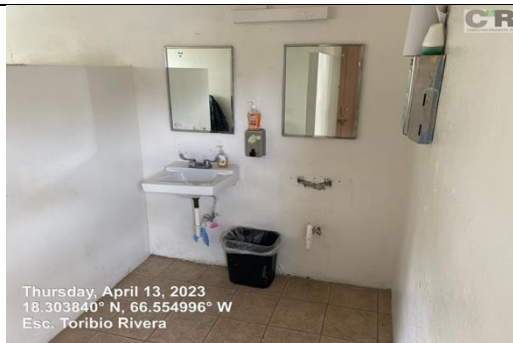
Ilustración 15. instalación lavamanos y mezcladora
