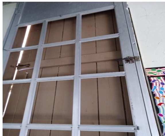
Foto 12. Proveer e instalar screen a puerta.
