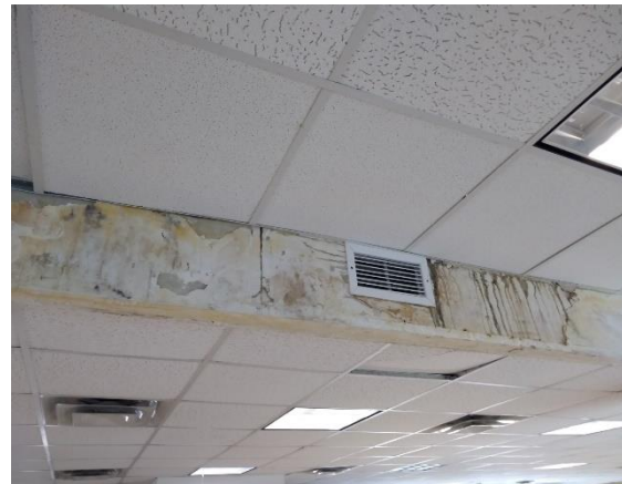
Foto 4. Reparación ducto de A/C en gypsum board.
