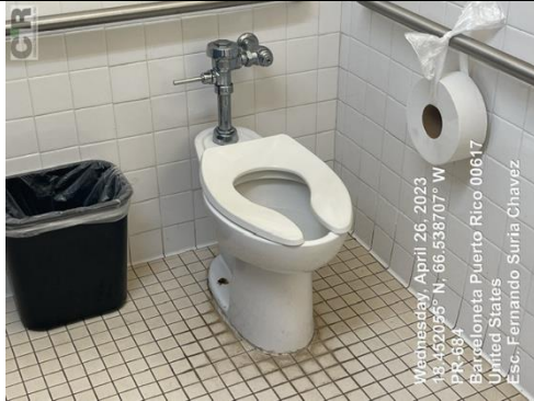
Ilustración 17. Reemplazo Tapa inodoro
