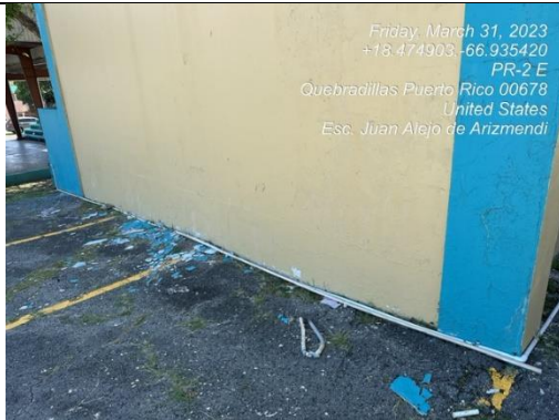
Ilustración 7. Solicitud de construcción de nicho en esta zona para tanques de gas propano.
