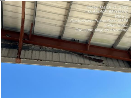
Ilustración 19. Reparación de techo en cancha
