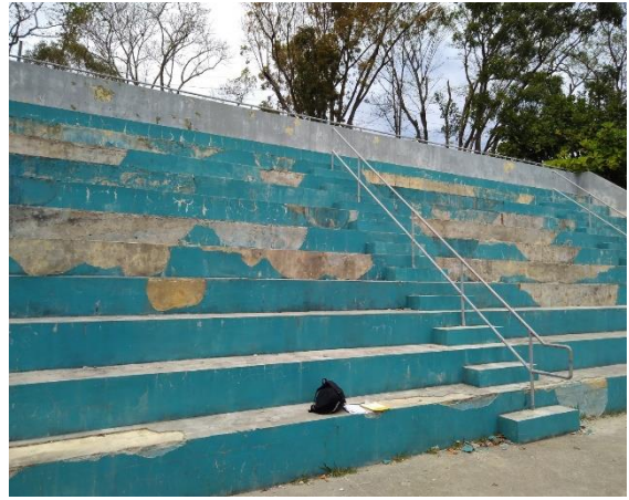
Foto 6. Reparación empañetado de gradas.
