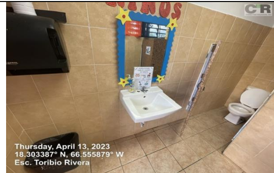
Ilustración 6. Reemplazo mezcladora
