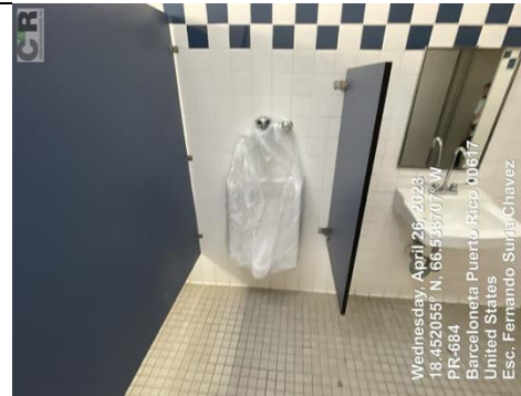
Ilustración 10. Reemplazo Urinal
