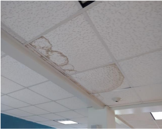
Foto 5. Reemplazo de plafón acústico.
