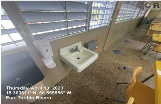
Ilustración 5. Reemplazo de lavamanos y mezcladora
