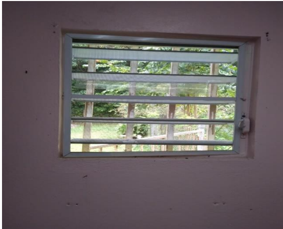
Foto 5. Suplir e instalar screens en ventana.
