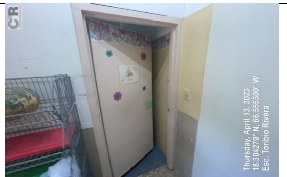
Ilustración 2. Reemplazo Puerta Baño Comedor
