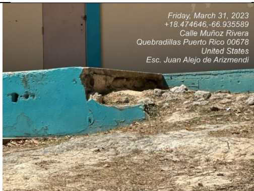
Ilustración 21. Reparación con concreto
