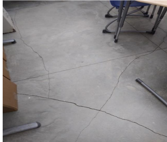
Foto 12. Sellar grietas en losa de piso.
