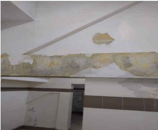
Foto 7. Reparar empañetado baños de gradas.
