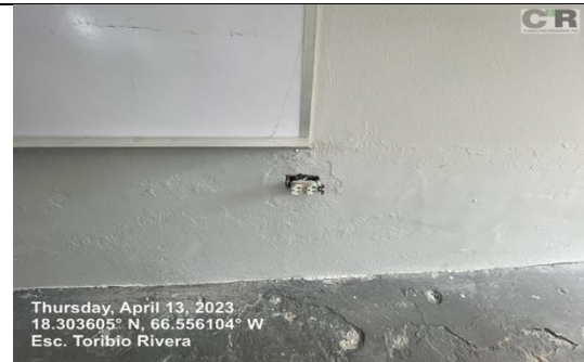
Ilustración 8 Reemplazo Receptaculo.
