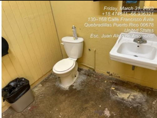
Ilustración 17. Pasamanos para baños
