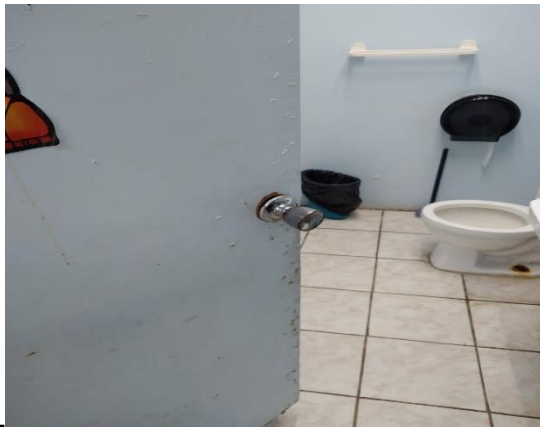
Foto 3. Reemplazar cerradura de puerta.
