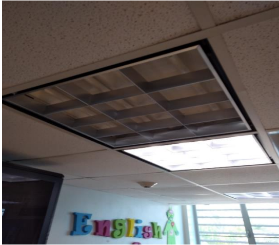
Foto 11. Reemplazar tubo fluorescente.
