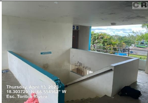
Ilustración 13. instalación de barandas
