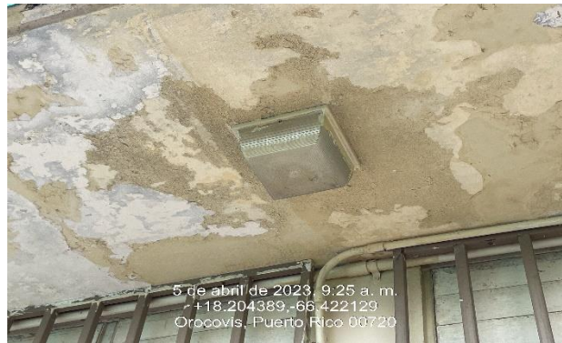
Ilustración 18: Reemplazo De Luminaria Exterior con fotocelda.
