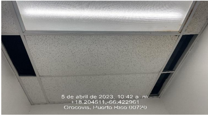
Ilustración 35: Reemplazo de Plafón Acústico.
