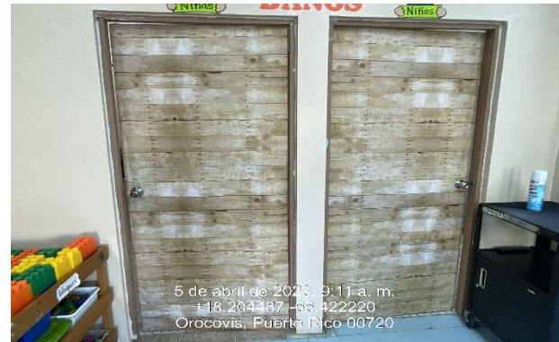
Ilustración 8: Reemplazo de puertas en madera y cerradura.
