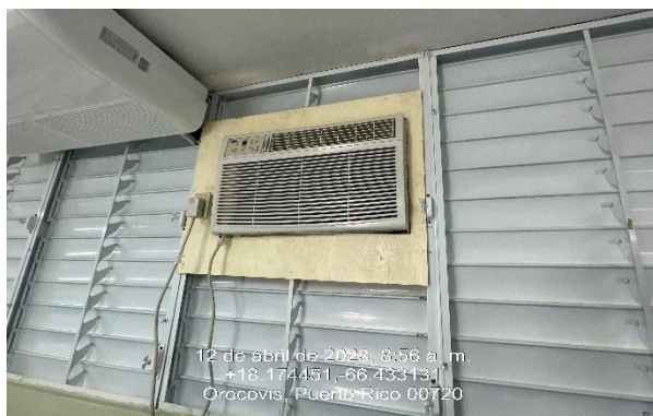
Ilustración 3. Reemplazo de ventana miami.
