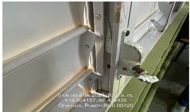
Ilustración 52: Reemplazo de operadores.
