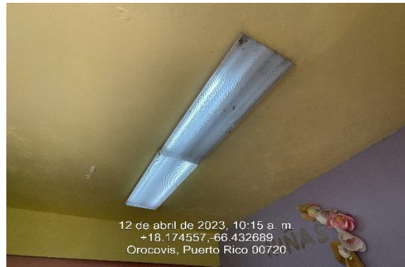
Ilustración 3823. Reemplazo De Tubo Fluorescente de 4 ft.
