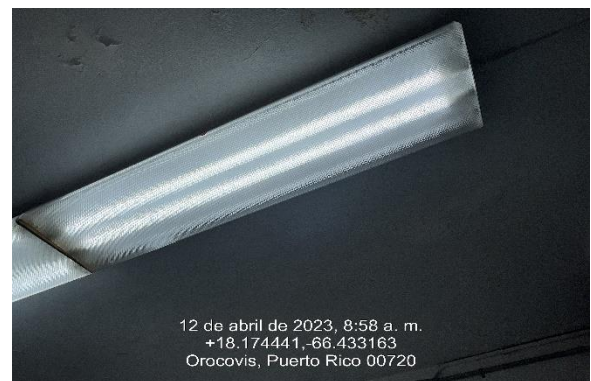
Ilustración 4. Reemplazo De Tubo Fluorescente de 4 ft.
