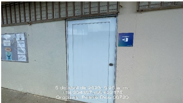
Ilustración 19: Reparación de puerta en metal.
