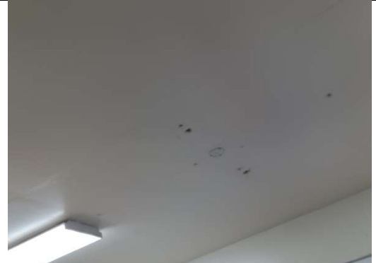
Empañetar áreas de cemento perdido en los plafones o huecos de instalaciones pasadas.
