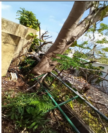
Reparar banco de área de cancha.
