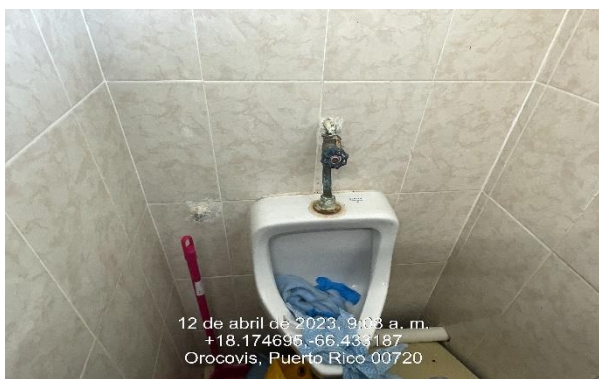
Ilustración 9. Reemplazo de urinal con válvula y "fittings".
