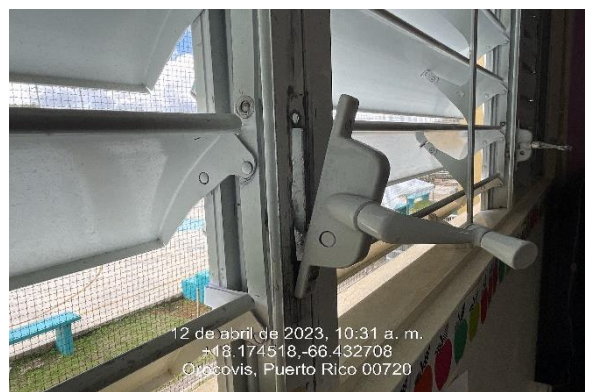
Ilustración 4624. Reemplazo de operadores de ventana.
