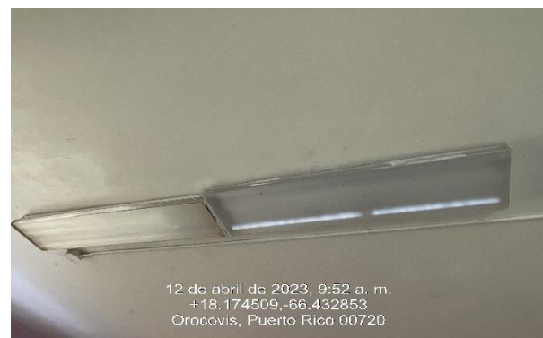
Ilustración 34. Reemplazo De Tubo Fluorescente de 4 ft.
