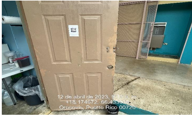
Ilustración 11. Reemplazo de puerta de madera y su cerradura.
