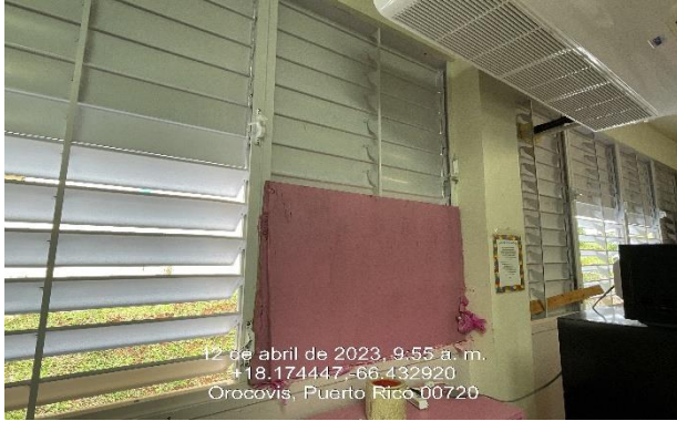
Ilustración 35. Reemplazo de ventana miami.
