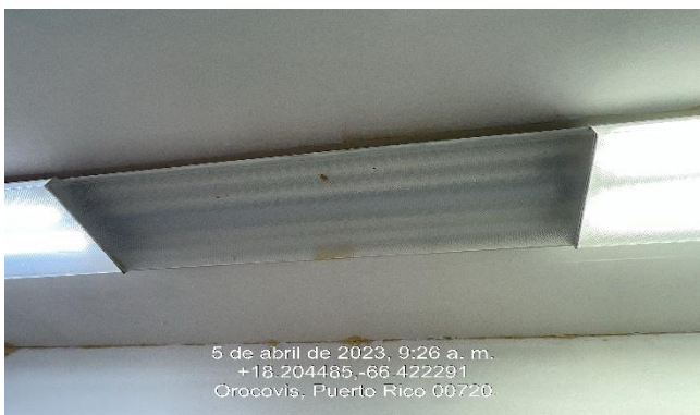
Ilustración 21: Reemplazo de tubos fluorescentes.
