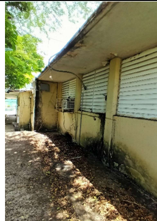
Pintura de exterior en edificio.
