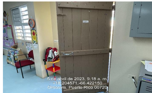
Ilustración 10: Reemplazo de puertas en madera y cerradura.
