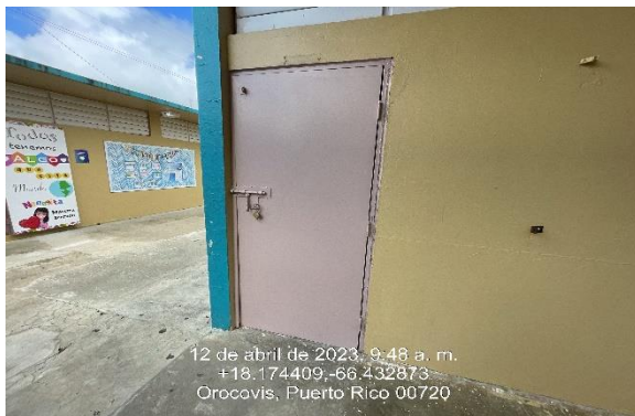
Ilustración 31. Reparación de puerta de tola.
