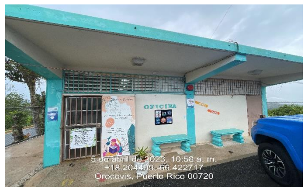
Ilustración 40: Pintura en edificio.
