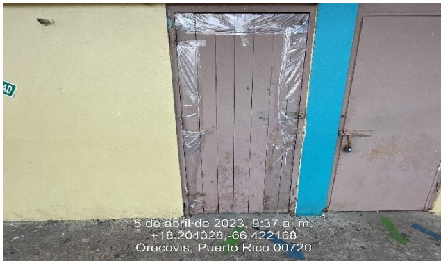
Ilustración 25: Reemplazo de puertas en madera y cerradura.
