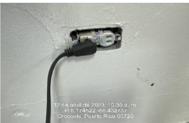
Ilustración 45. Reemplazo de receptáculo y plato de cubierta.
