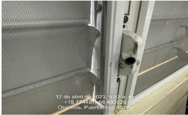
Ilustración 5. Reemplazo de operadores de ventanas.
