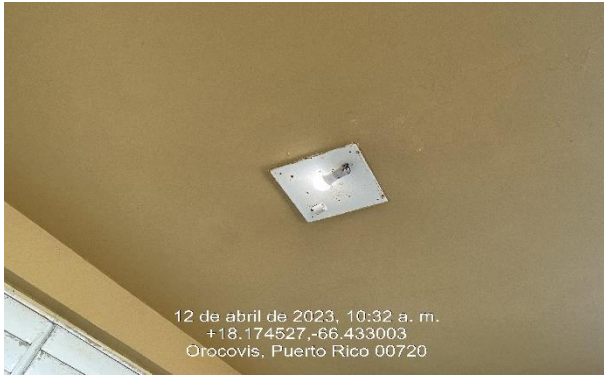
Ilustración 47. Reemplazo de luminaria exterior.
