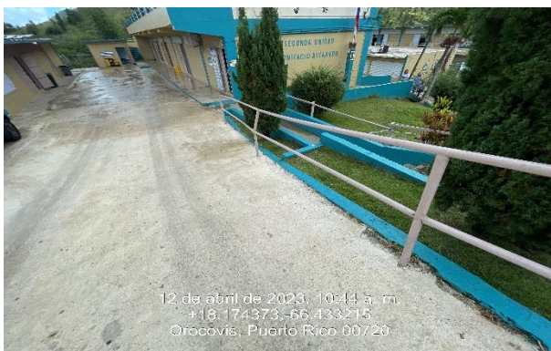
Ilustración 51. Reemplazo o reparación de pasamanos.
