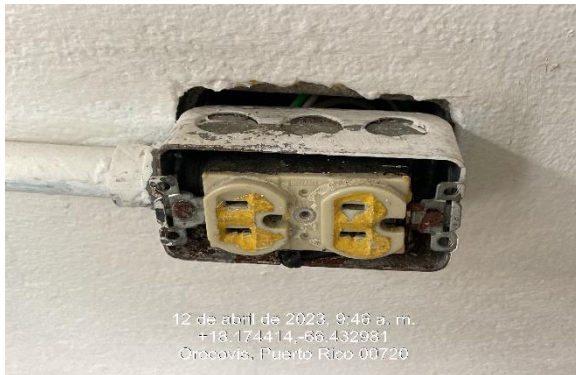
Ilustración 29. Reemplazo de receptáculo y plato de cubierta.
