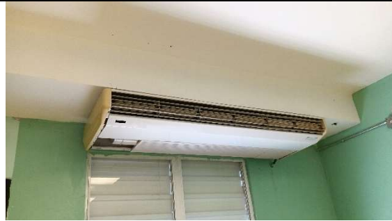
Mantenimiento a A/C.
