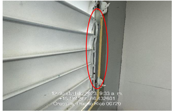
Ilustración 18. Reparación del canal de ventana miami.
