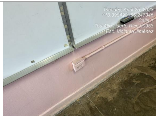
Ilustración 16. Tomacorriente dañado
