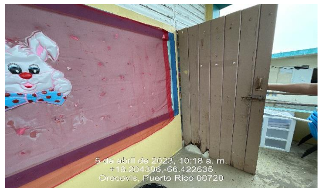
Ilustración 34: Reemplazo de puertas en madera y cerradura.
