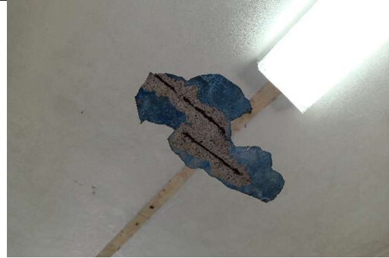
Empañetar áreas donde se desprende el cemento.
