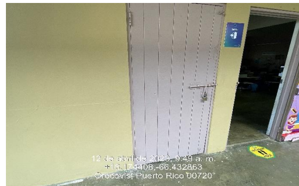
Ilustración 32. Reemplazo de puerta en madera con su cerradura.
