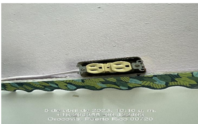
Ilustración 33: Instalación de plato de cubierta en receptores.
