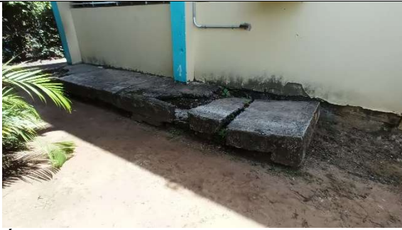
Área de acera para demoler.
