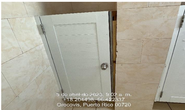
Ilustración 3: Reemplazo de puertas de partición en baños
