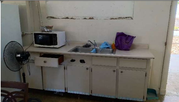
Gabinete de cocina en mal estado salón de autismo, con polilla, comején y huecos. La parte de arriba del gabinete fue removida, casi le cae encima a uno de los estudiantes.
