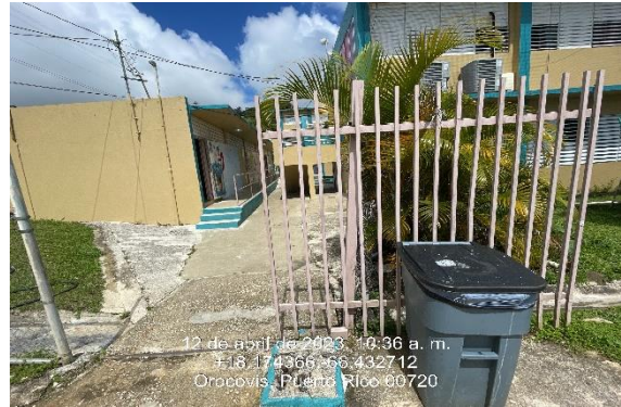
Ilustración 48. Reparación de corredera y gomas de portón peatonal.
