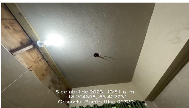
Ilustración 39: Instalación de roseta y bombilla.
