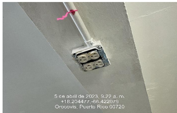
Ilustración 14: Instalación de plato de cubierta en receptores.
