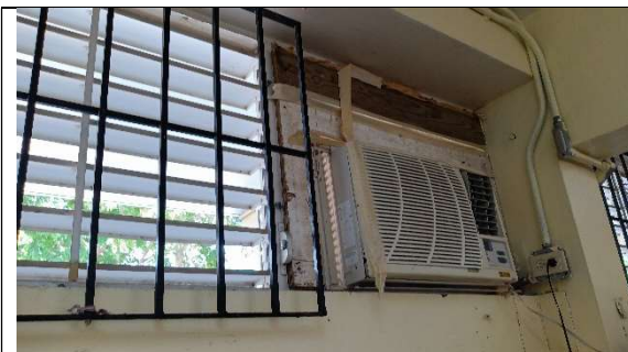
Mantenimiento a mini-split y mejorar terminación alrededor madera con polilla.
