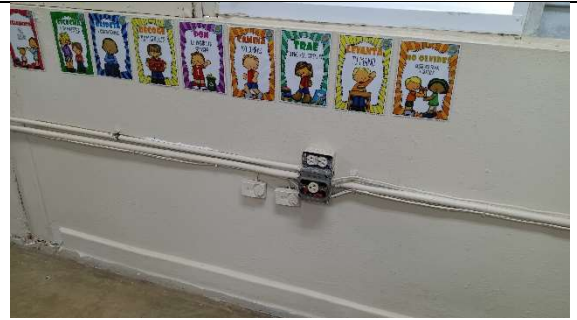
Receptáculos sin tapa de protección.
