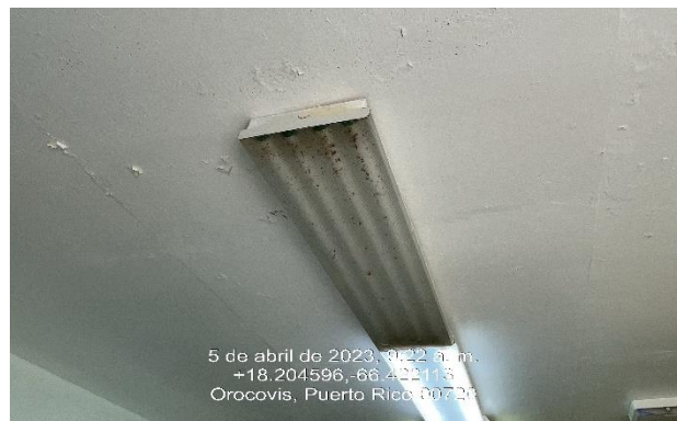
Ilustración 12: Reemplazo de luminaria.
