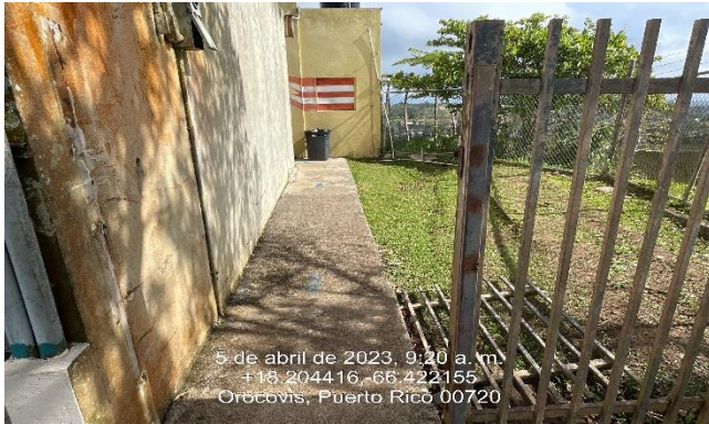
Ilustración 11: Instalar portón peatonal se encuentra en el suelo.
