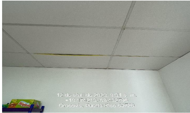
Ilustración 17. Reemplazo de 2 plafones acústicos de 2ft.x 4ft.
