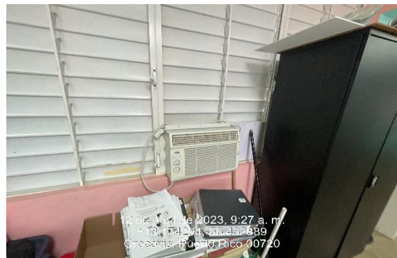
Ilustración 16. Reemplazo de ventana miami.
