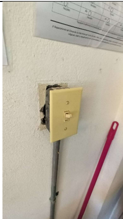
Interruptor con huecos alrededor de la caja fácil para insertar un dedo de un estudiante curioso y ya ha pasado.
