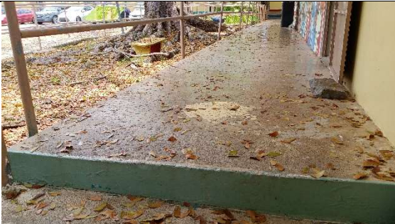
Aceras levantadas por raíces de árbol con inclinación a los salones pronunciada. Cuando llueve el agua se mete a los salones y existen puertas que no se pueden abrir por la situación.
