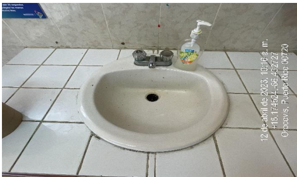
Ilustración 39. Reemplazo de lavamanos y mezcladora.
