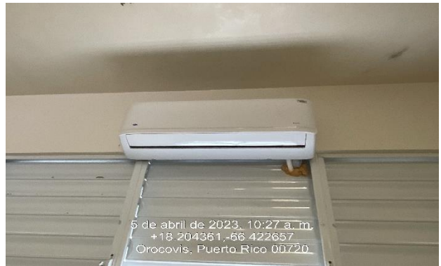
Ilustración 50: Mantenimiento en consolas de aire acondicionado.
