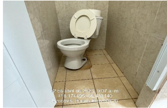
Ilustración 6. Instalar junta cera y tornillos para inodoro
