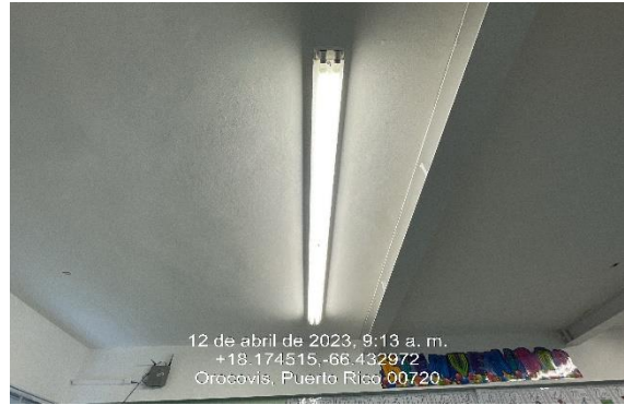
Ilustración 12. Reemplazo de luminaria de 8 ft. por luminaria leds de 4 tubos de 4 ft.
