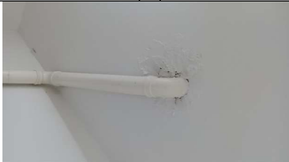
Sellar área de tubería y empañetar alrededor de tubería.
