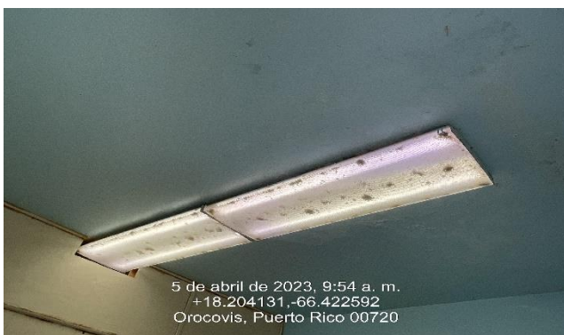
Ilustración 27: Reemplazo de luminarias.
