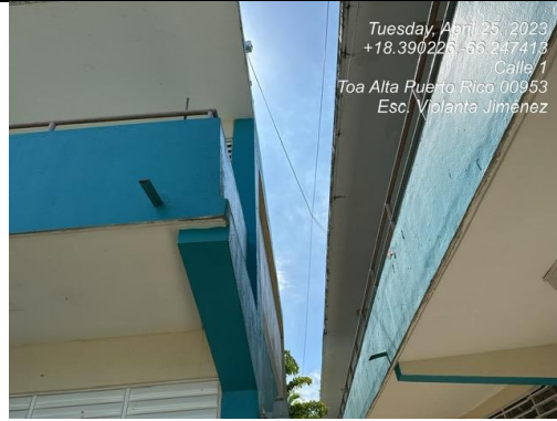
Ilustración 18. Puente entre edificios
