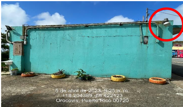
Ilustración 17: Reemplazo De Luminaria Exterior Tipo Cobra Con Fotocelda.
