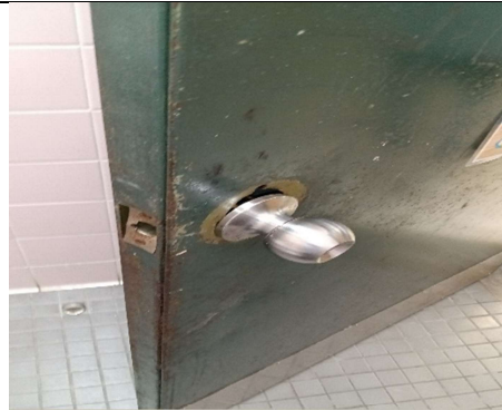
Remplazar cerradura de puerta.
