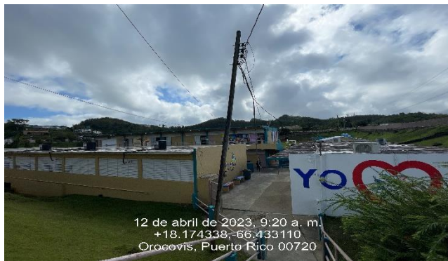
Ilustración 15. Reemplazo de poste eléctrico de madera virado dentro del plantel escolar.
