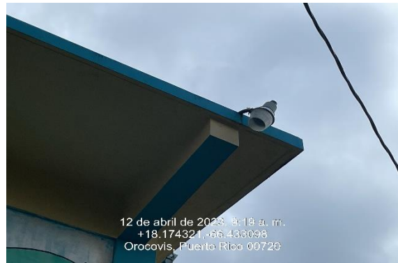
Ilustración 14. Reemplazo de luminaria exterior tipo cobra con fotocelda.
