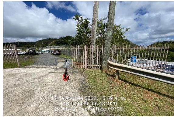
Ilustración 50. Reparación de corredera y gomas de portón vehicular.
