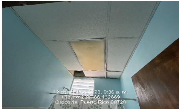
Ilustración 23. Reemplazo de luminaria e instalación de panel acústico.
