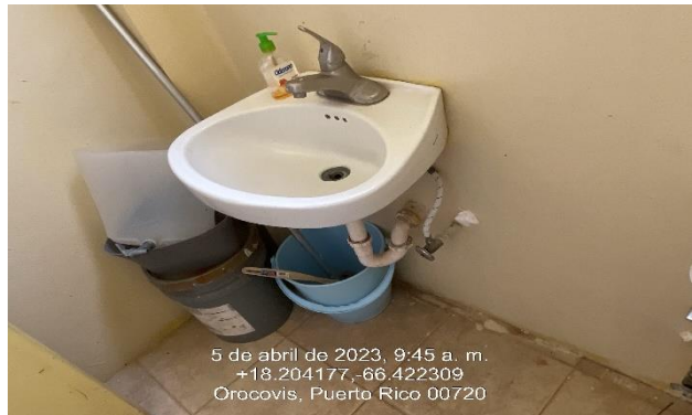
Ilustración 26: Reemplazo de lavamanos con mezcladora y "fittings"
