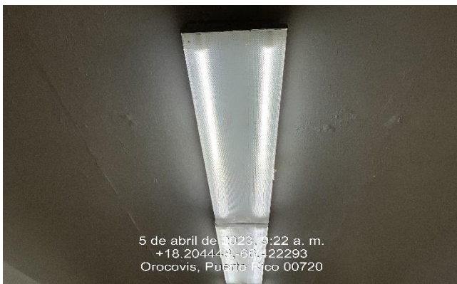
Ilustración 13: Reemplazo de tubos fluorescentes.
