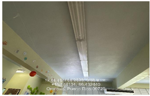
Ilustración 26. Reemplazo De Tubo Fluorescente de 4 ft.
