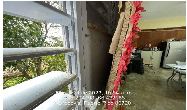
Ilustración 30: Reemplazo de ventana en metal "Miami"
