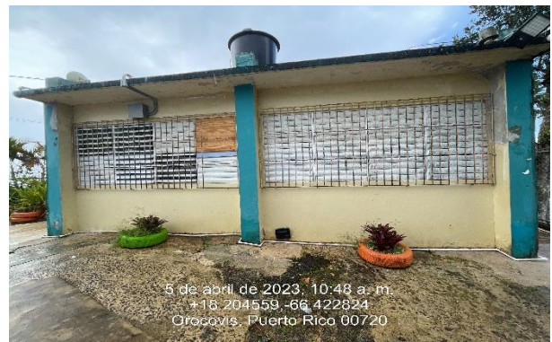
Ilustración 38: Reemplazo de ventana y reparación de rejas de seguridad.
