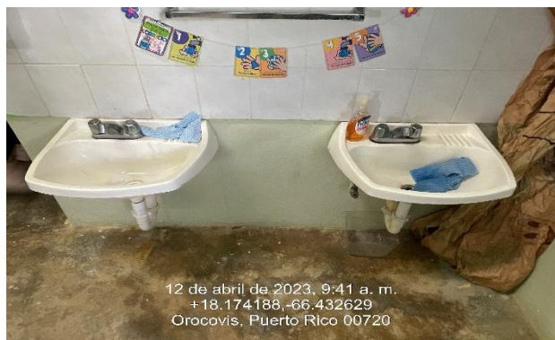
Ilustración 27. Reemplazo de lavamanos y mezcladora.
