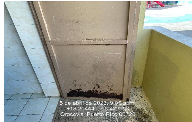
Ilustración 6: Reemplazo de puertas de tola.
