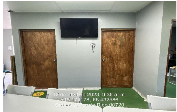
Ilustración 24. Reemplazo de puertas de baños en madera por metal.
