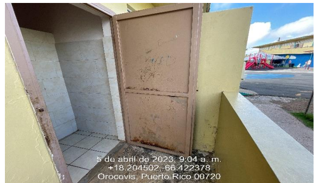
Ilustración 4: Reemplazo de puertas de tola.
