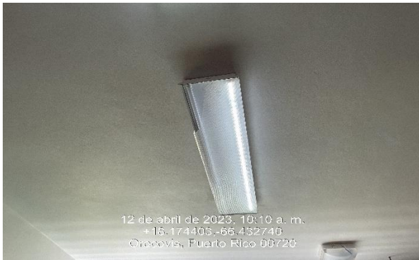
Ilustración 37. Reemplazo de luminaria.
