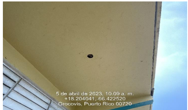
Ilustración 32: Instalación de luminaria exterior con fotocelda.
