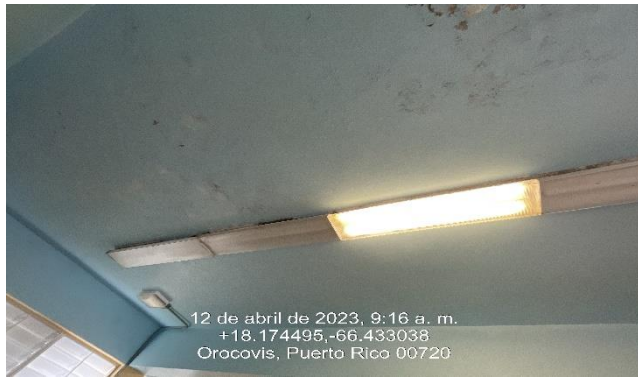
Ilustración 13. Reemplazo de tubo fluorescente.
