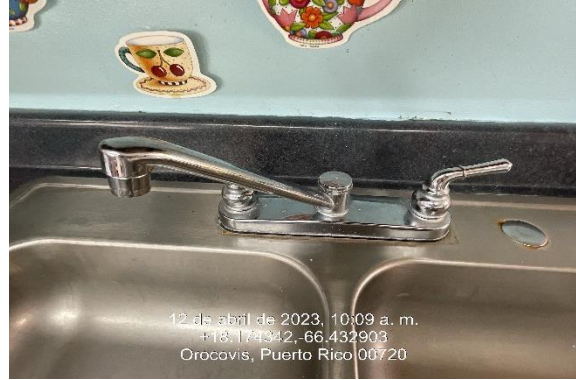
Ilustración 36. Reemplazo de mezcladora de fregadero.
