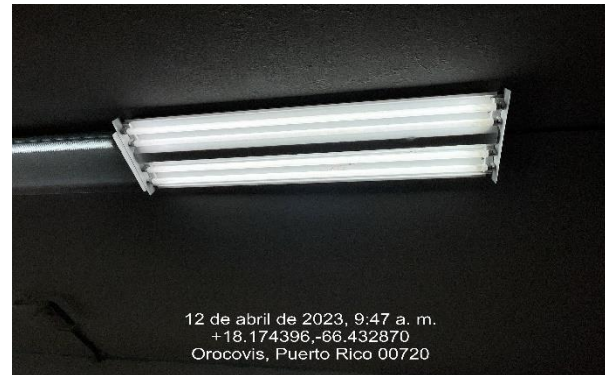
Ilustración 30. Reemplazo de luminaria.
