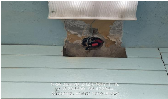
Ilustración 7: Instalar plato de cubierta.
