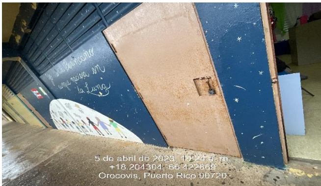
Ilustración 51: Aplicación de pintura en puertas de tola.
