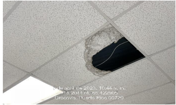
Ilustración 36: Reemplazo de Plafón Acústico.
