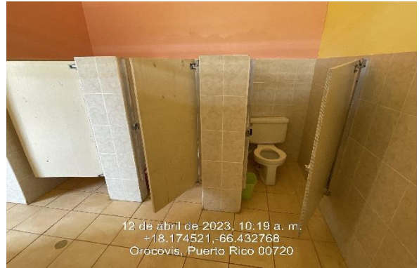
Ilustración 42. Reemplazo de puertas de particiones de madera por metal.
