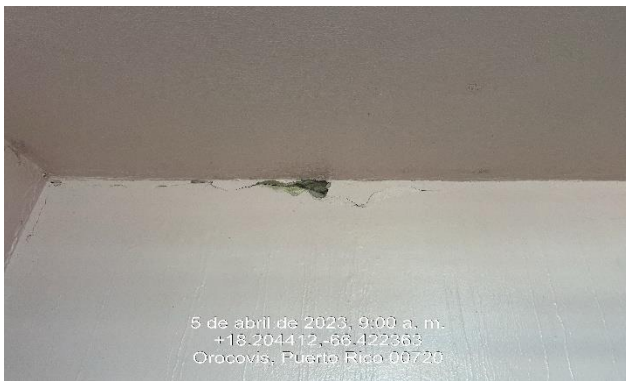
Ilustración 1: Corregir empañetado en pared.
