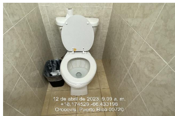
Ilustración 10. Reemplazo de válvula inodoro regular.
