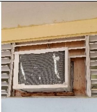
Mantenimiento de A/C y remplazar base de aire con polilla.
