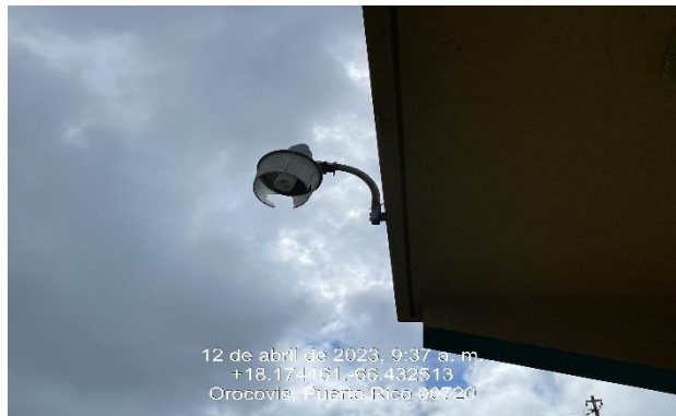
Ilustración 25. Reemplazo de luminaria exterior tipo cobra con fotocelda.
