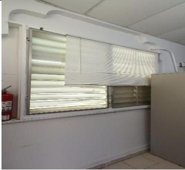
Remplazar ventas y cambiar paneles en pared con polilla y filtración.
