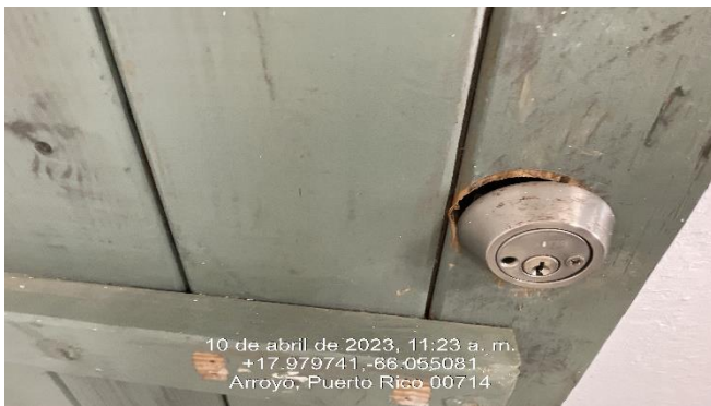
Ilustración 1. Reemplazo de cerraduras.
