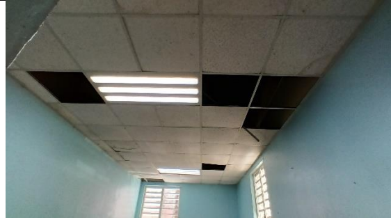
Remplazar plafones en área de baños.
