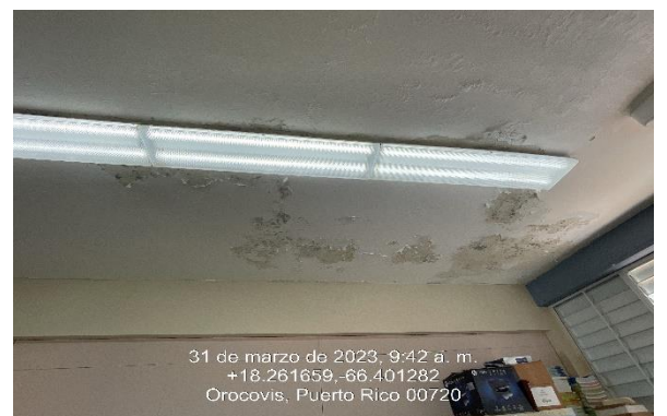
Ilustración 4: Reemplazo De Tubo Fluorescente de 4'.
