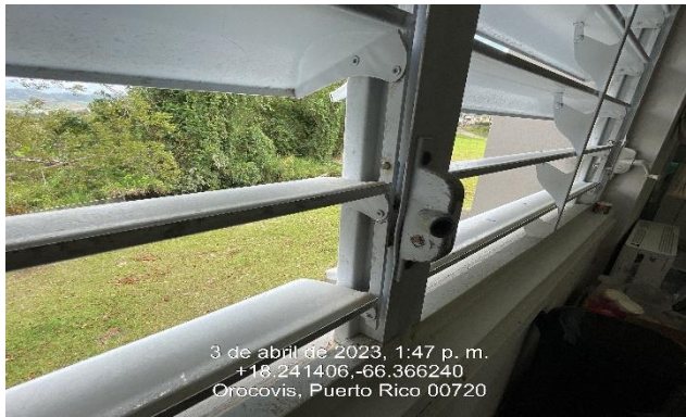
Ilustración 35: Reemplazo de operadores de ventanas.
