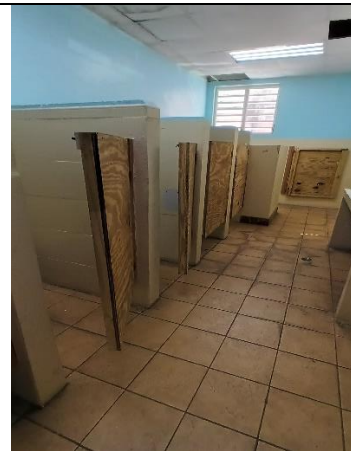
Remplazar puertas de entrada a inodoros por puertas de aluminio.
