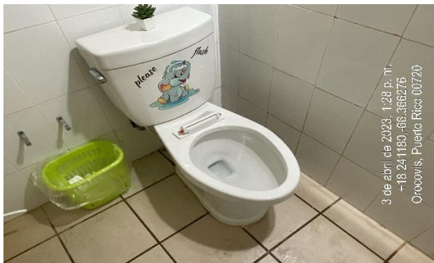
Ilustración 31: Instalar tapa De inodoro.
