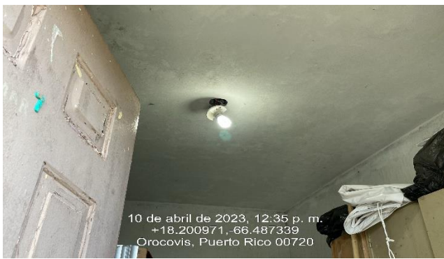
Ilustración 27. Reemplazo de roseta y bombilla.
