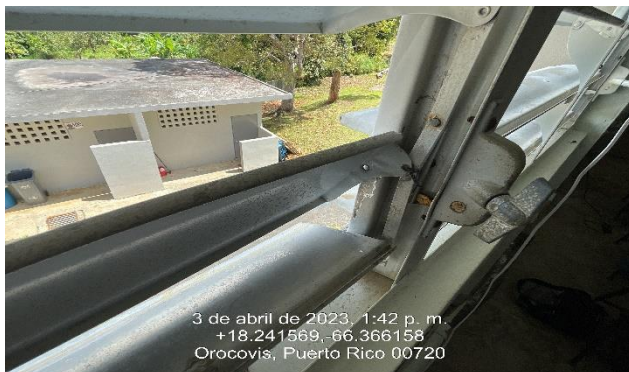
Ilustración 33: Reparación De Ventana En Metal "Miami"
