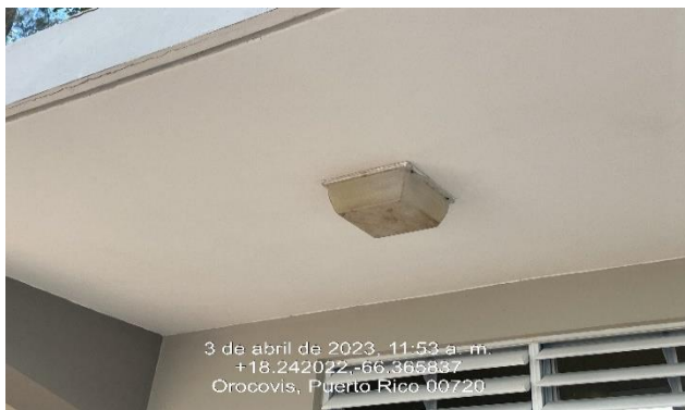
Ilustración 7: Reemplazo De Luminarias Exterior.
