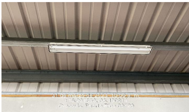
Ilustración 15: Reemplazo de luminarias en la cancha.
