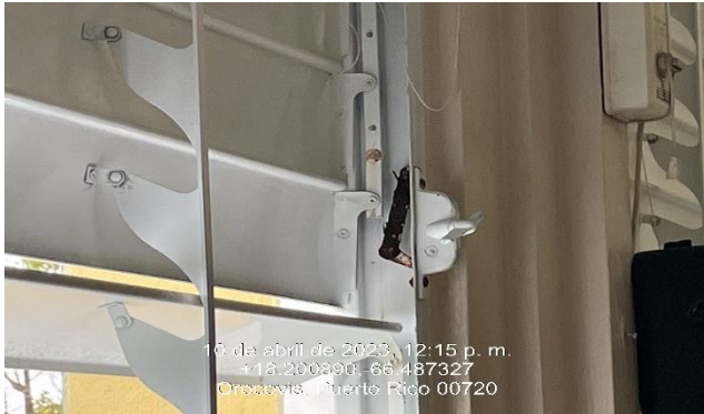
Ilustración 17. Reemplazo de operadores de ventanas.
