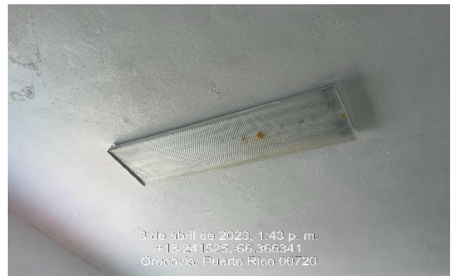
Ilustración 34: Reemplazo de luminarias.
