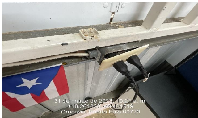
Ilustración 21: Reemplazo del Plato De Cubierta del interruptor.
