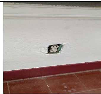
Receptáculo sin tapa de seguridad.
