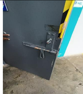
Remplazar cerradura de puerta de metal.
