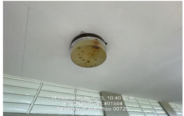
Ilustración 24: Reemplazo De Luminarias Exterior con fotoceldas.
