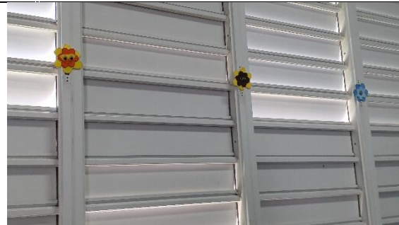
Instalar operadores de ventana.
