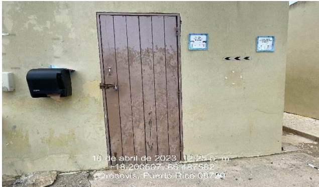
Ilustración 23. Reemplazo de puerta de madera por metal.
