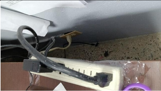
Remplazar receptáculo eléctrico.
