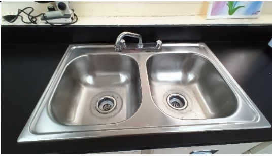
Remplazar mezcladora de fregadero.
