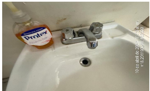
Ilustración 4. Reemplazo de mezcladora de lavamanos.
