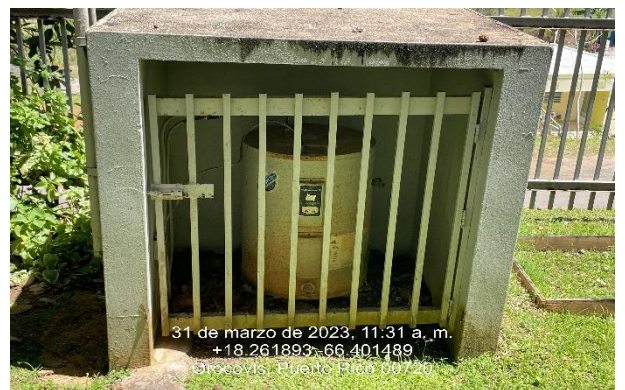
Ilustración 32: Reemplazo de calentador de agua.
