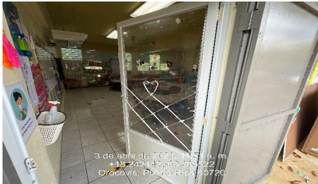
Ilustración 5: Reparación o reemplazo de puertas de Screens Plásticas.
