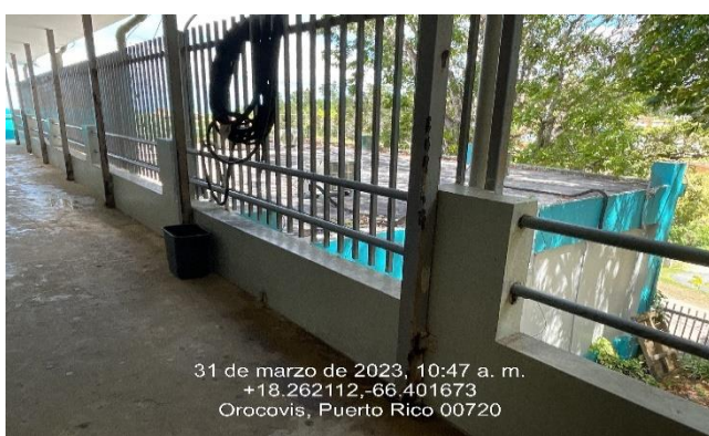
Ilustración 35: Corrección y aplicación de pintura en 6 tubos 2 x 2.
