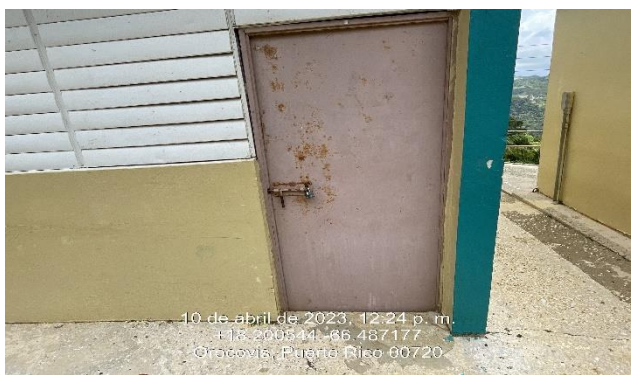
Ilustración 22. Reparación de puerta de tola (aplicar pintura).
