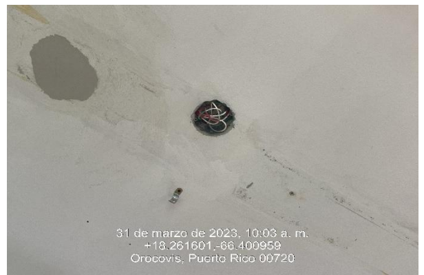
Ilustración 14: Instalar roseta eléctrica y bombilla.
