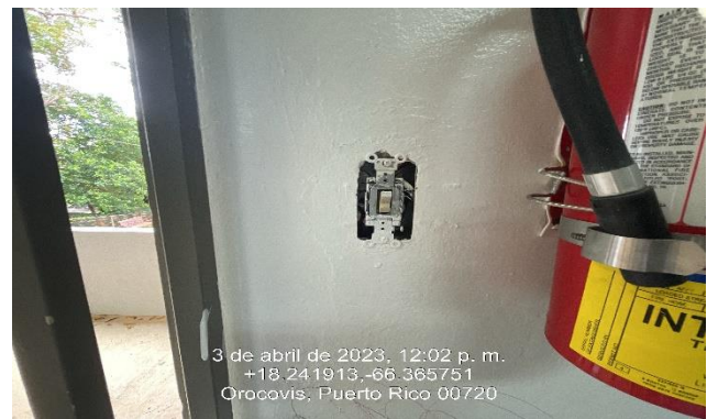
Ilustración 12: Instalar platos de cubierta en interruptores eléctricos.
