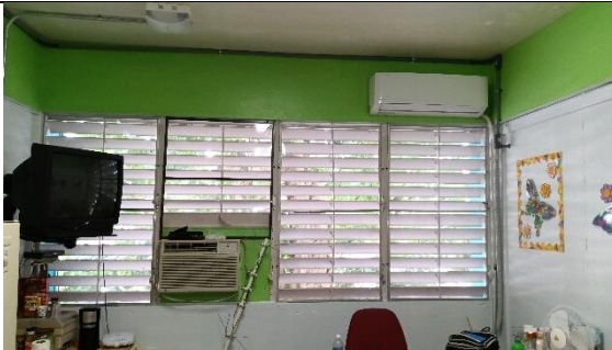
Remover A/C dañado e instalar una nueva unidad salón de facultad.
