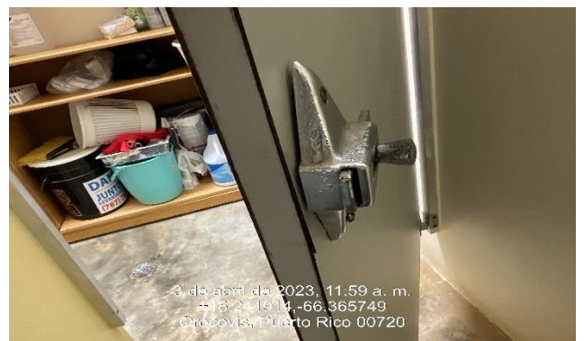
Ilustración 10: Reemplazo de cerraduras en puertas de baños.
