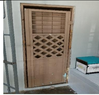
Remplazar puerta de covacha.
