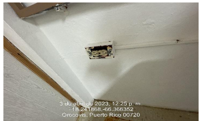
Ilustración 16: Instalar platos de cubierta de receptáculos.
