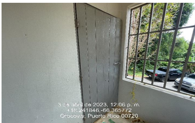
Ilustración 13: Reemplazo de puertas de madera por metal y su cerradura.
