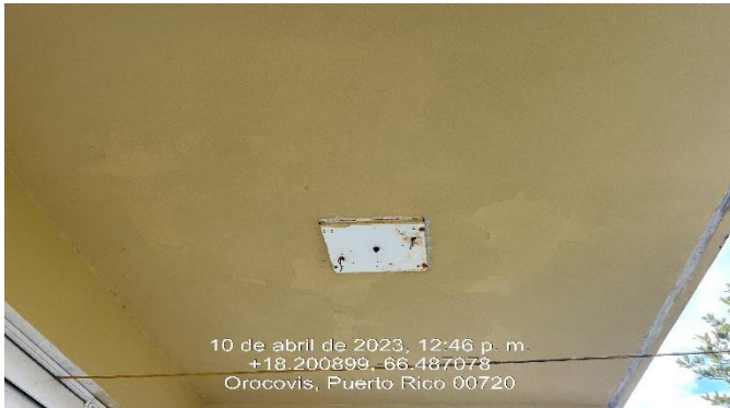
Ilustración 31. Reemplazo de luminarias exterior con su fotocelda.
