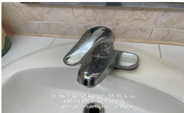
Ilustración 29: Reemplazo de mezcladora lavamanos.
