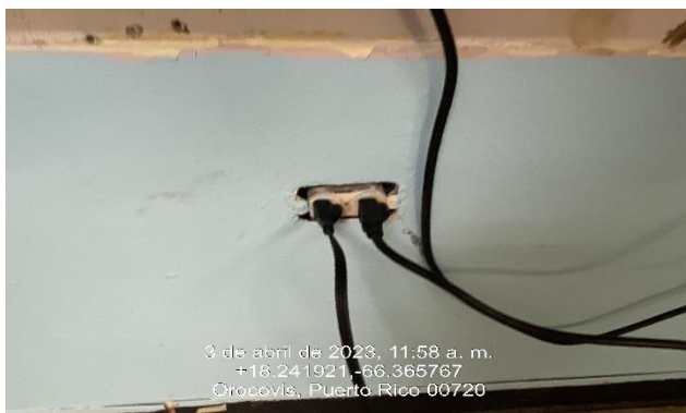
Ilustración 9: Instalar platos de cubierta de receptáculos.
