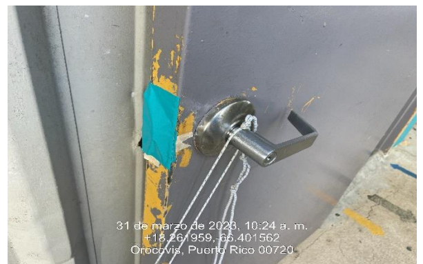
Ilustración 22: Reemplazo de cerraduras.
