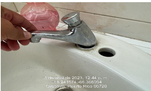
Ilustración 21: Reemplazo de mezcladora lavamanos.
