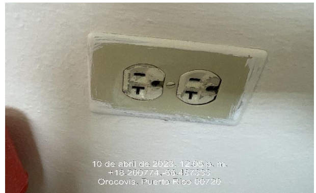
Ilustración 14. Reemplazo de receptáculo y plato de cubierta (No funcional).
