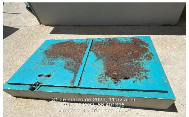
Ilustración 38: Reemplazo de puertas de trampa de grasa.
