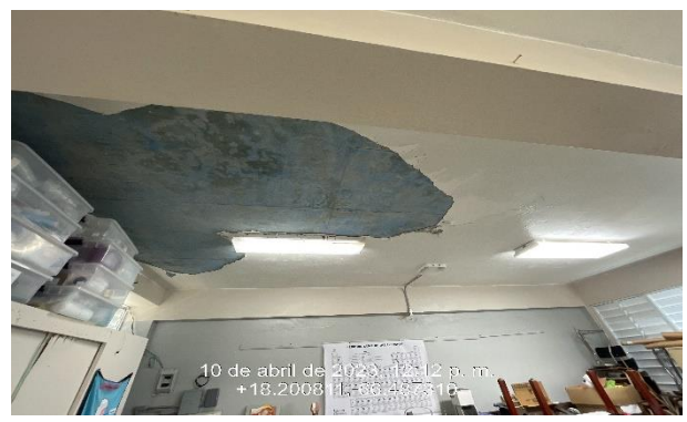
Ilustración 16. Corrección de empañetado.
