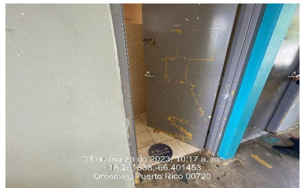
Ilustración 18: Reemplazo De Puerta En Metal Ó Tola Doble.
