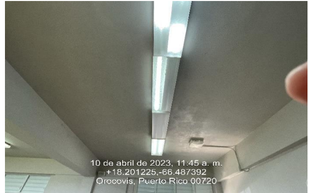
Ilustración 6. Reemplazo de tubos fluorescente.
