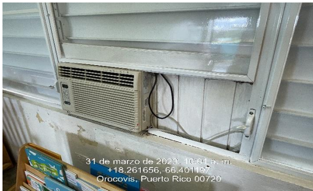
Ilustración 11: Reemplazo de ventana.
