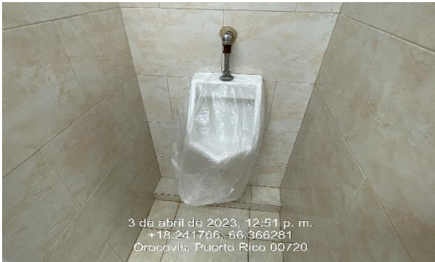
Ilustración 25: Urinales Con Válvula Y "Fittings".
