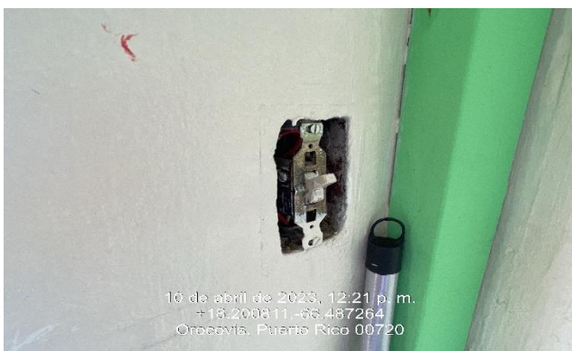
Ilustración 21. Reemplazo de interruptor de pared y plato de cubierta.
