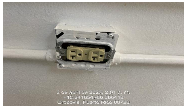
Ilustración 38: Instalar platos de cubierta de receptáculos.
