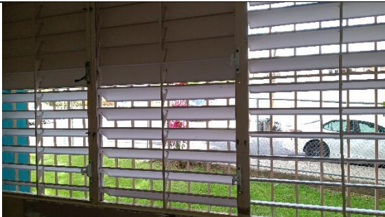
Operadores de ventana a ser remplazado.
