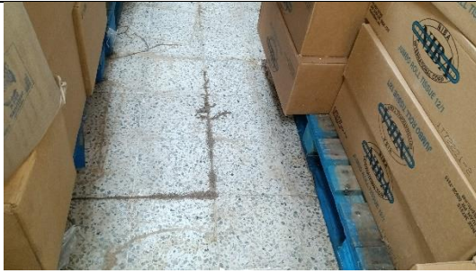
área de almacén al lado del comedor con comején en esta área es que entra el agua que inunda el comedor en el interior.
