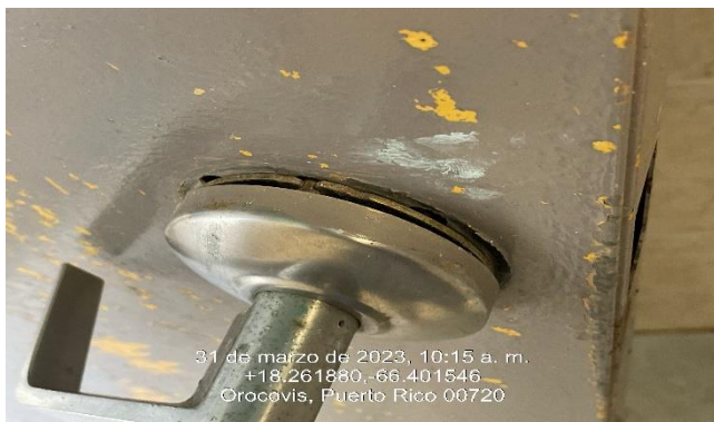
Ilustración 17: Reemplazo de cerraduras.
