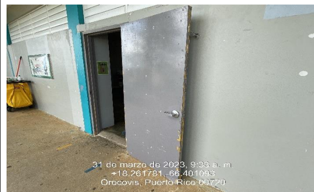
Ilustración 3: Reemplazo De Puerta En Metal Ó Tola Doble.
