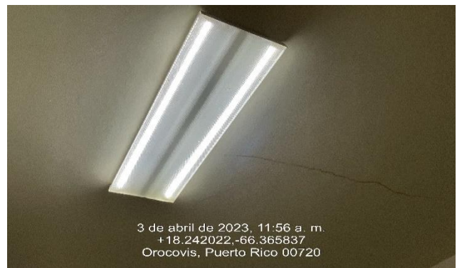
Ilustración 8: Reemplazo de tubos fluorescentes.
