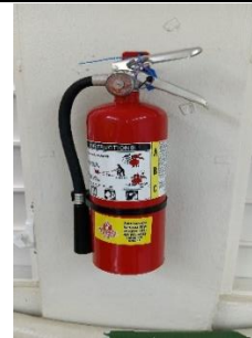
Mantenimiento de extintores.
