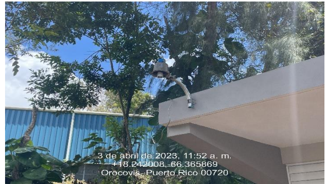
Ilustración 6. Reemplazo de luminaria exterior con fotocelda.
