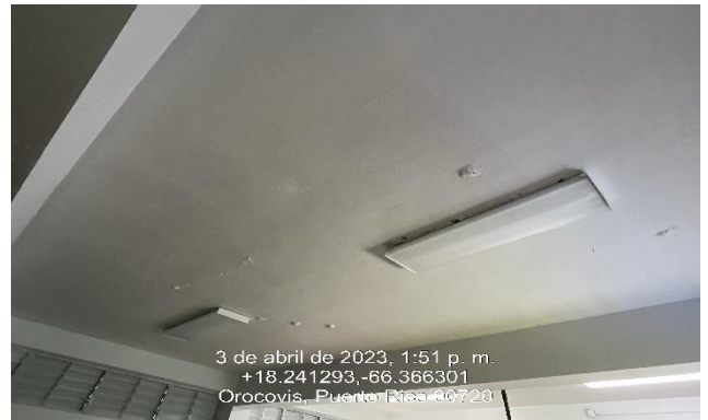
Ilustración 36: Reemplazo de tubos fluorescente.
