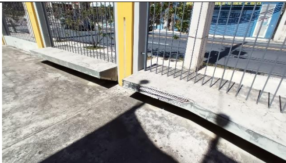
Reparar banco en fachada principal.
