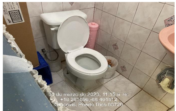
Ilustración 28: Reemplazo de inodoro de tanque en el comedor.
