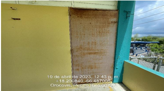
Ilustración 29. Reparación puerta de tola (Aplicar pintura).
