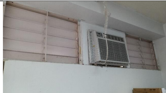
Mantenimiento A/C e instalar screen de ventana.
