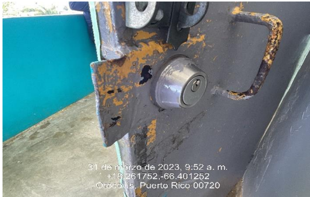
Ilustración 5: Reemplazo de cerraduras.
