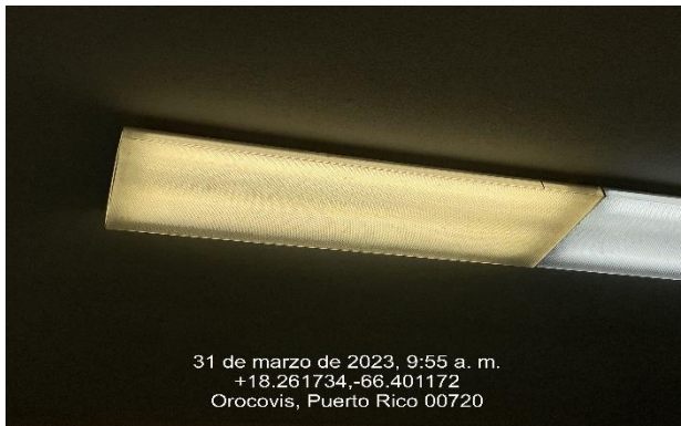
Ilustración 7: Reemplazo Luminarias por led.
