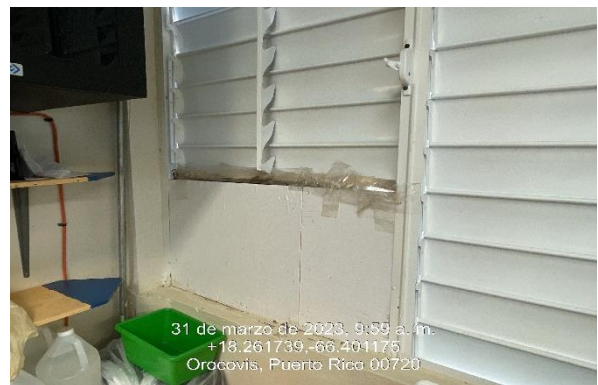
Ilustración 10: Reemplazo de ventanas.
