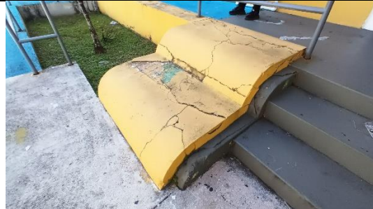
Empañetar área de fachada.
