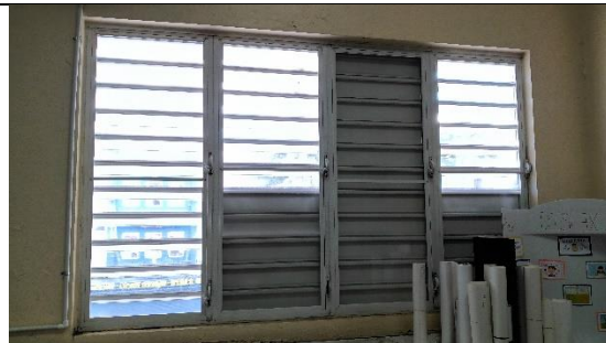
Instalar screens plástico en áreas de ventanas.
