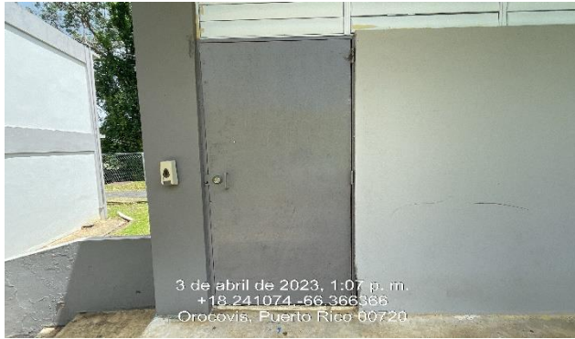
Ilustración 29: Reparación de puerta de tola.
