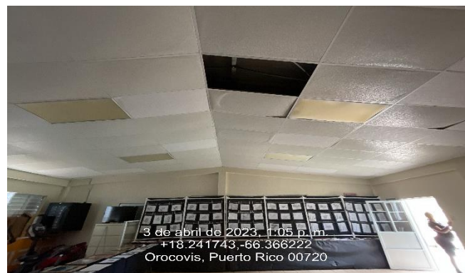
Ilustración 28: Reemplazo e instalación de plafón acústico
