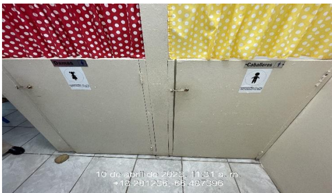
Ilustración 3. Reemplazo de puertas de particiones de baños por puertas de metal.
