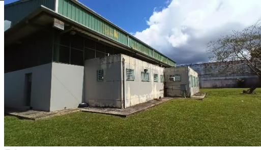
Pintura en paredes de cancha.
