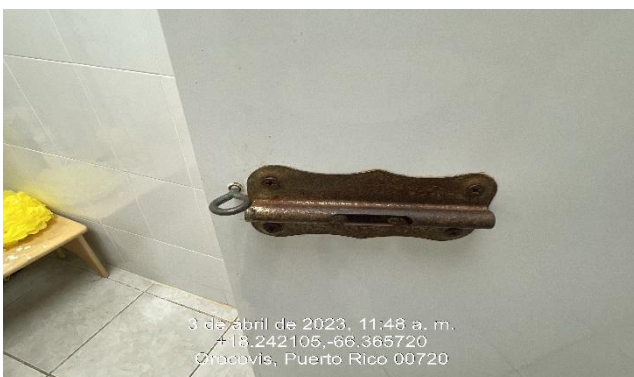
Ilustración 3. Reemplazo por cerraduras en puertas de baños.
