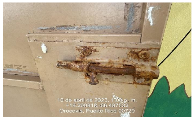
Ilustración 34. Reemplazo de cerradura.
