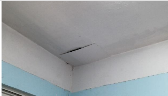
Empañetar área con tapa de panel para cubrir hueco de techo.
