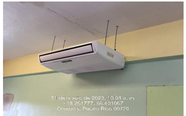
Ilustración 12: Mantenimiento de unidades de aire acondicionado.
