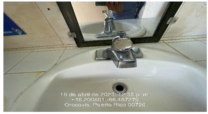
Ilustración 26. Reemplazo de mezcladora.
