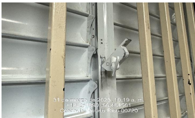
Ilustración 19: Reemplazo de operadores de ventanas.
