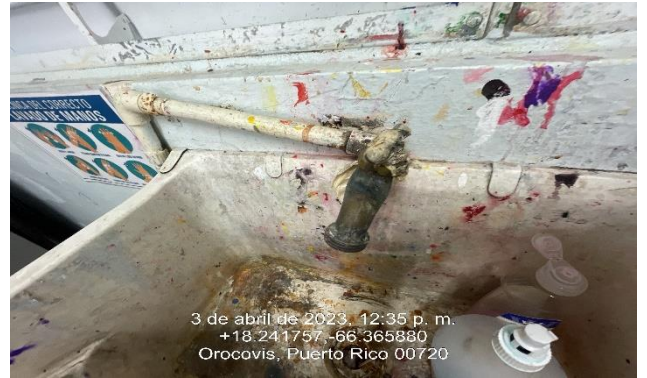
Ilustración 18: Reemplazo de llave Para Manguera.
