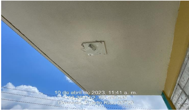
Ilustración 5. Reemplazo de luminarias exterior con su fotocelda.
