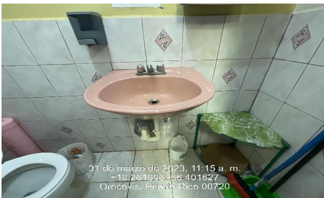
Ilustración 27: Reemplazo de Lavamanos Con Mezcladora Y "Fittings"
