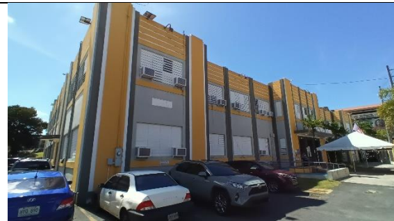
Pintura en fachada.
