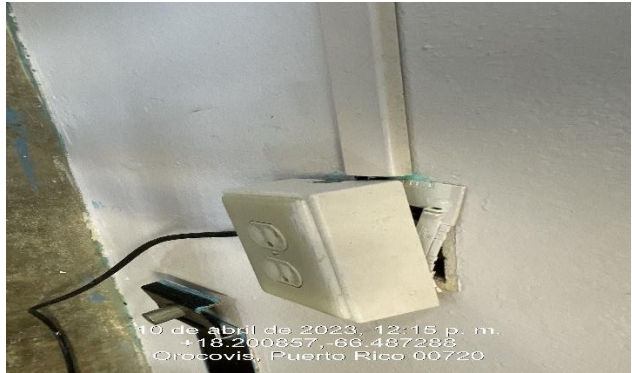
Ilustración 18. Reemplazo de receptáculo y plato de cubierta.
