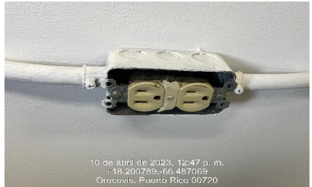
Ilustración 32. Reemplazo de receptáculo y plato de cubierta (No funcional).
