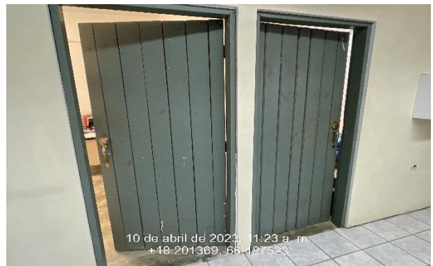
Ilustración 2. Reemplazo de puertas de madera y su cerradura.
