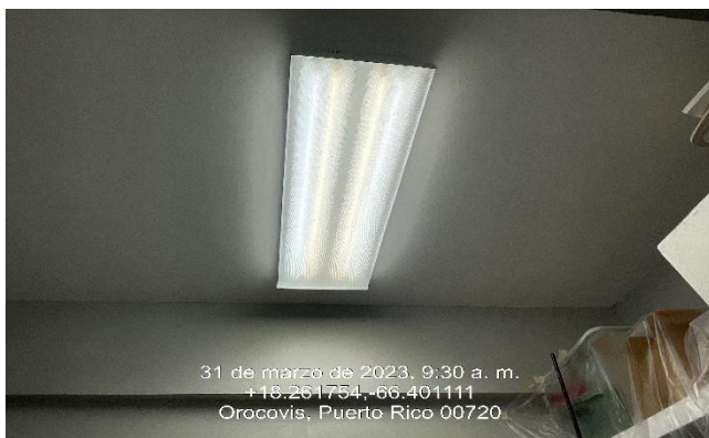
Ilustración 37: Reemplazo De Tubo Fluorescente.
