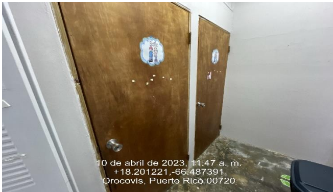
Ilustración 7. Reemplazo de puertas de particiones de baños por puertas de metal y su cerradura.
