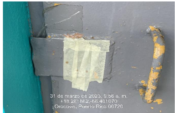
Ilustración 8: Reemplazo e instalación de cerraduras.
