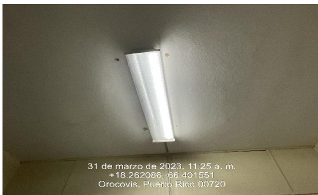
Ilustración 31: Reemplazo De Tubo Fluorescente 4'.
