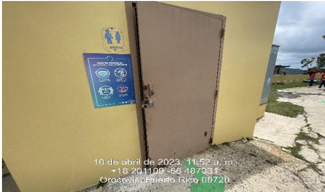
Ilustración 11. Reparación de puerta de tola (Aplicar pintura).
