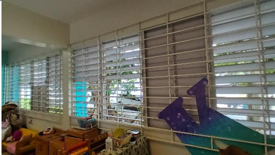
Operadores de ventana a remplazar.
