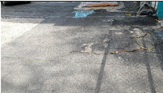
Area de estacionamiento para asfaltar.
