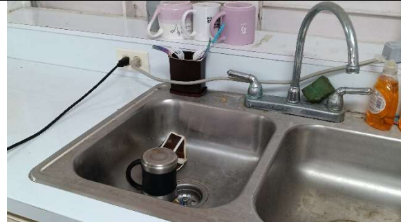
receptáculos cerca del agua, proveer ground fault en esta situación.
