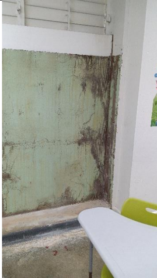
Comejen en áreas de muebles de madera.
