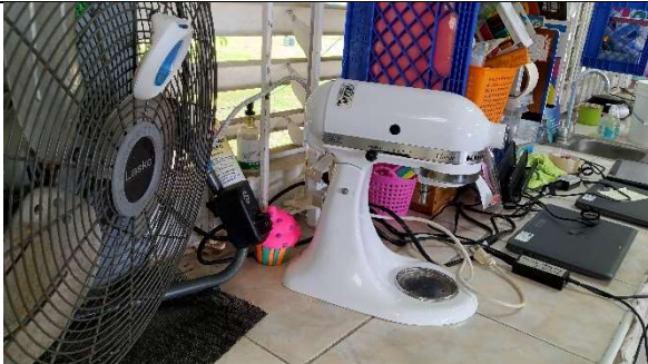
Falta de receptáculos en área de cocina.
