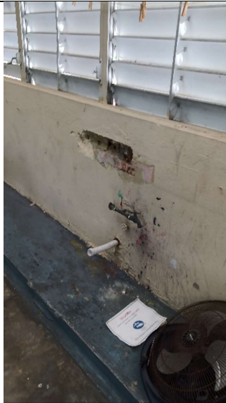
Tapar hueco en pared y eliminar tubería.
