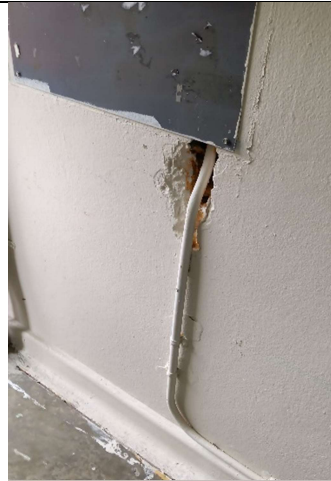
Tapar hueco en la pared.
