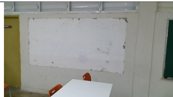
Reparar área pared e instalar pizarra blanca.
