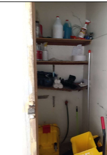
Tablillas con polilla y bombilla dañada en todos los cuartos de conserjes.
