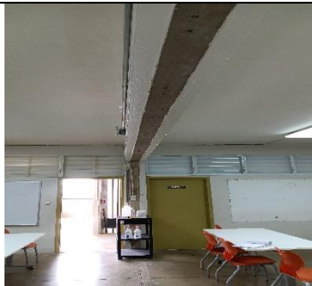
Empañetar área de columna y viga.
