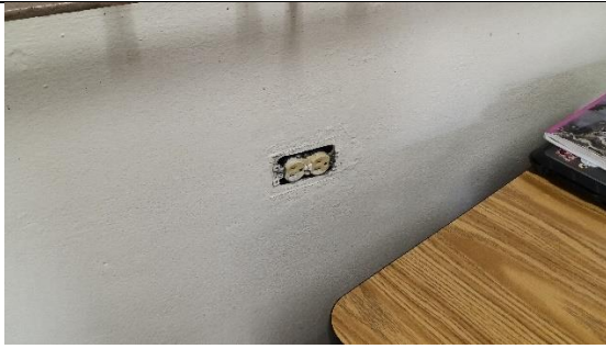
Reemplazar receptáculo eléctrico sin tapa.
