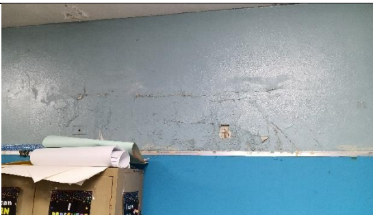
Empañetar área de pared y filtración.
