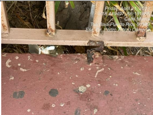
Ilustración 17. Reparación a portones
