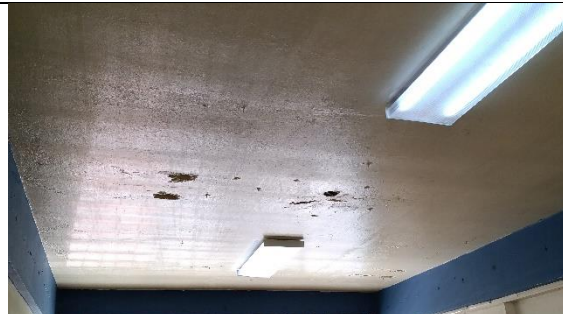
Area del techo a ser empañetado.
