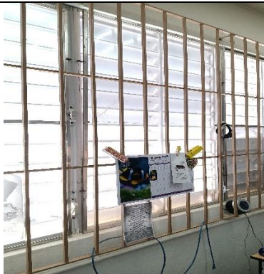
Reemplazo de operadores de ventanas.
