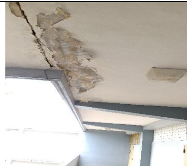
Reparar área de junta de expansión.
