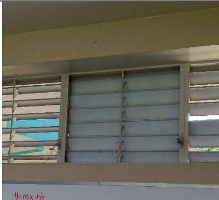
Reemplazar operadores dañados.
