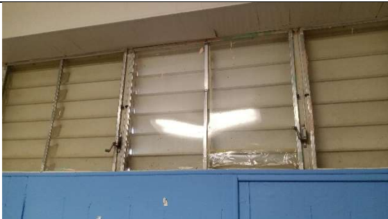
Remplazar screen plástico roto.
