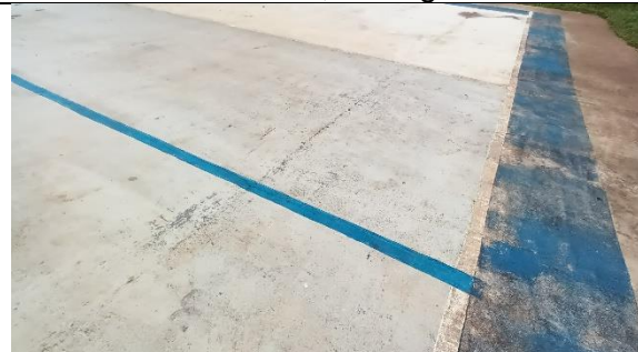
Piso de la cancha con grietas, huecos y desnivelado en áreas, no seguro.
