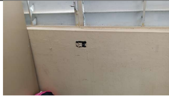
Reemplazar receptáculo sin tapa.
