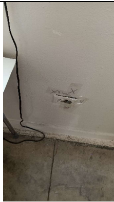
Rceptucllo para ser reemplazado, explota cuando es usado.
