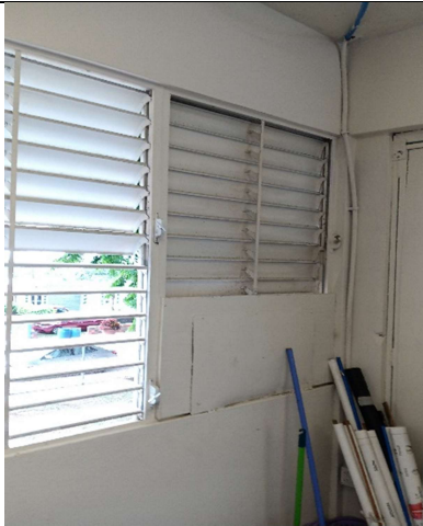
Reemplazar ventana con hueco de A/C.
