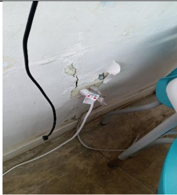
Reparar área de receptáculo.
