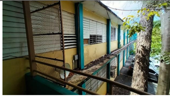
Pintura exterior en edificio.
