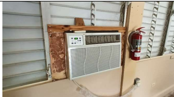
Aire para darle mantenimiento y marco para fijar el aire con comején, utilizar panel de pvc.
