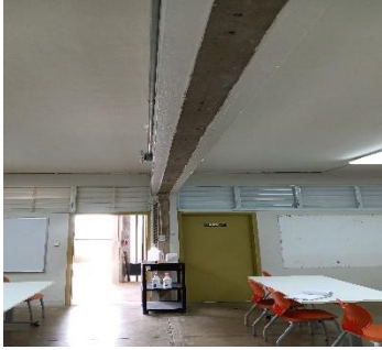
Empañetar área de columna y viga.
