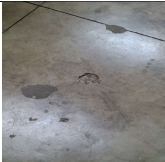
Rellenar hueco en el piso.
