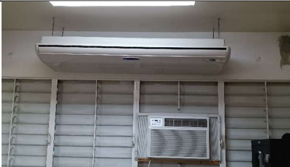
Remover A/C dañado y mantenimiento de A/C.
