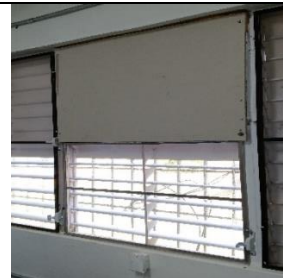
Reemplazar screen, operadores de ventana en oficina de principal.
