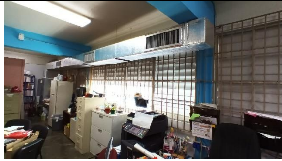
Equipo de A/C que no está en función para ser removido en dos salones.
