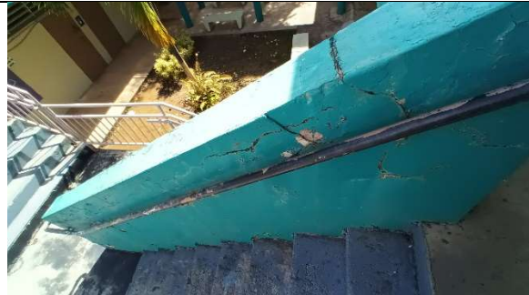
Pintura en área de escaleras.
