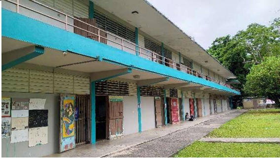
Pintura en exterior.
