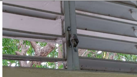
Reemplazar operadores de ventana.
