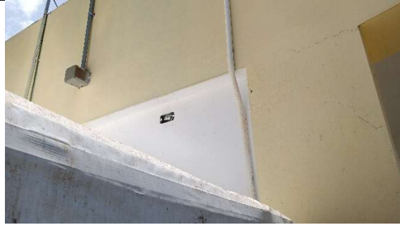
Proveer tapa impermeable para proteger el receptaculo.
