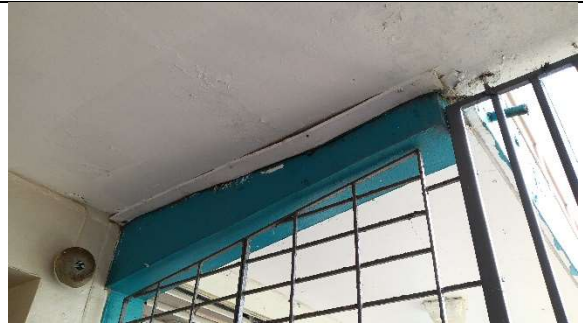
Proveer junta de expansión en pasillo.
