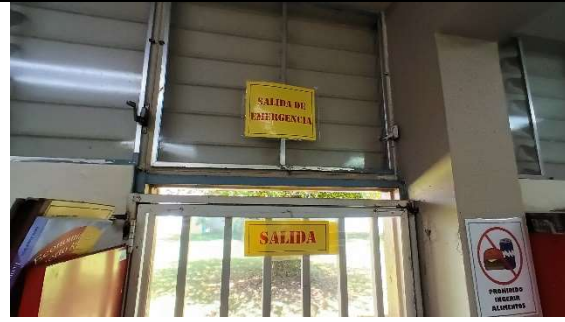
Rellenar hueco en parte superior de la puerta.
