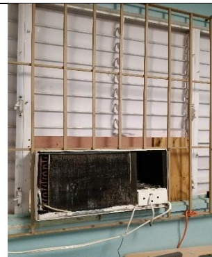
A/C para remover e instalar ventana nueva.
