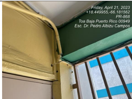
Ilustración 16. Tubería eléctrica
