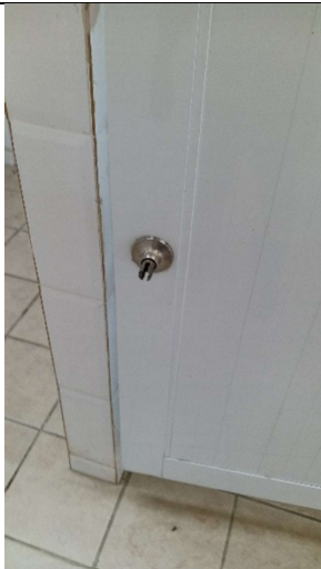
Remplazar cerradura rota en particiones de baño.
