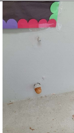
Eliminar tubería de la pared y empañetar área.
