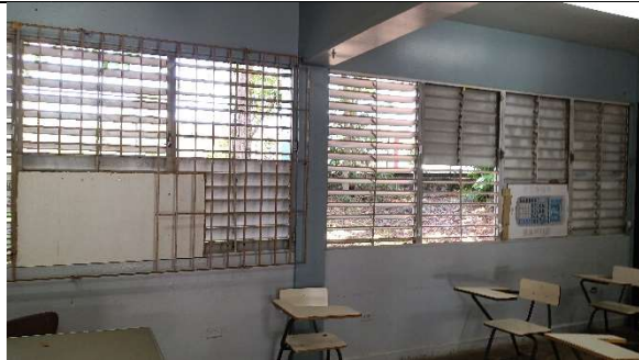
Cambiar ventana con hueco de A/C removido.
