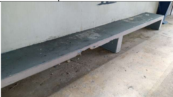
Reparar banco de área de cancha.
