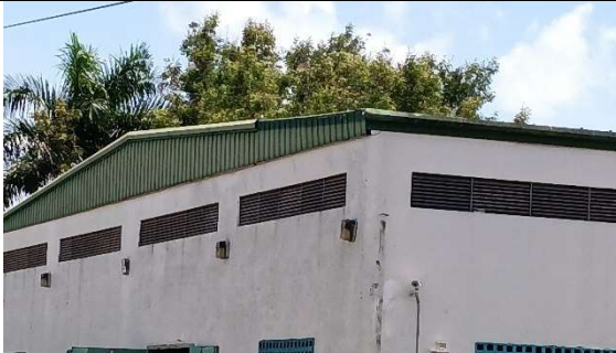
Protección y cuneta de cancha perdida para dar mantenimiento.
