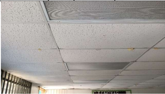
Plafon para remover y ajustar la altura para facilitar abrir la puerta porque ahora rosa con los plafones.
