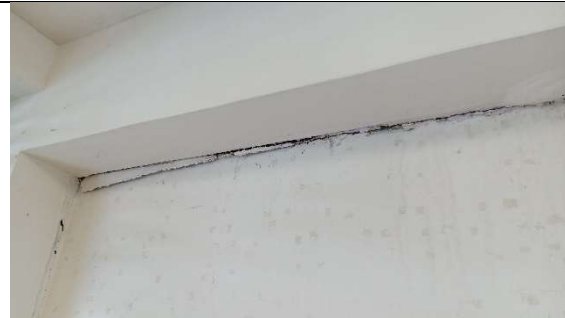
Empañetar área con grieta.
