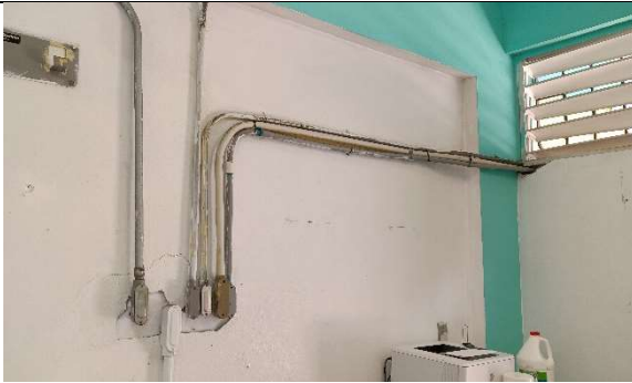
Empañetar pared en área de tubería.
