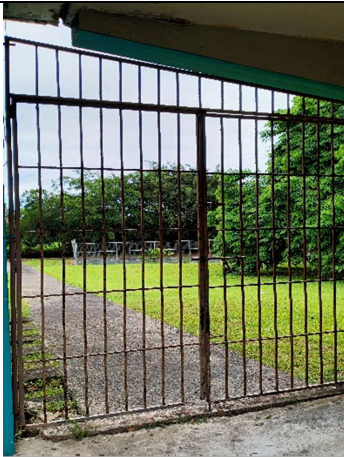
Reparar portón de reja.
