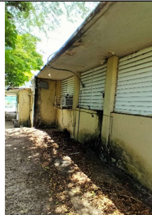
Pintura de exterior en edificio.
