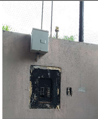
Falta tapa de panel de breaker, el panel tiene huecos vacios en los breaker y el interruptor no tiene tapa.
