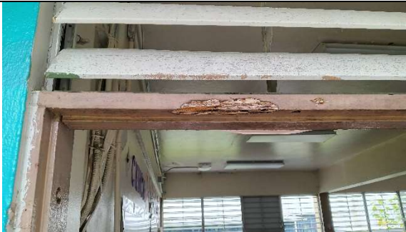
Marco de puerta en madera con polilla a reemplazar.
