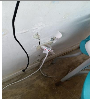
Reparar área de receptáculo.
