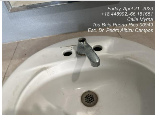
Ilustración 10. Mezcladora rota
