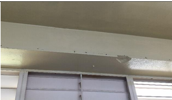
Empañetar área de viga.
