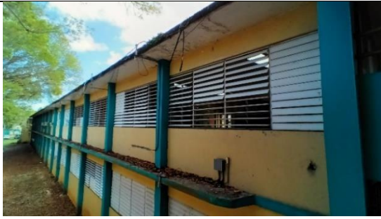
Pintura exterior en edificio.
