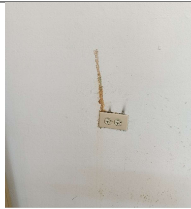
Reemplazar receptáculo con comején adentro.
