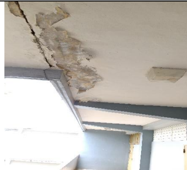
Reparar área de junta de expansión.
