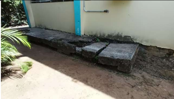
Área de acera para demoler.
