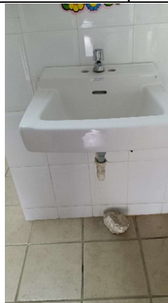
Remplazar sifón con liqueo.
