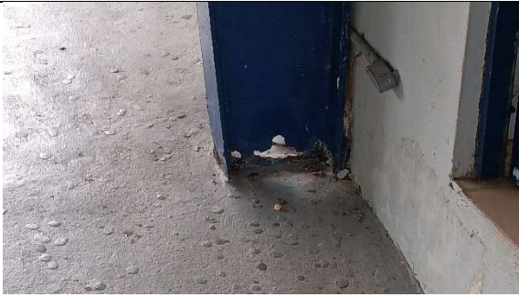
Reparación de bases de columnas de acero.
