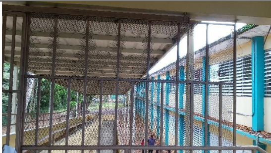
empaquetar área del techo.
