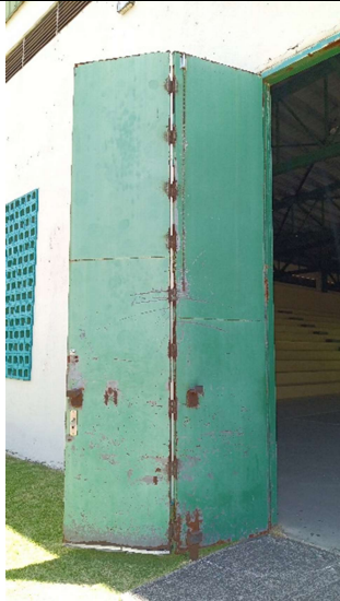
Reparar puertas de entrada a la cancha.
