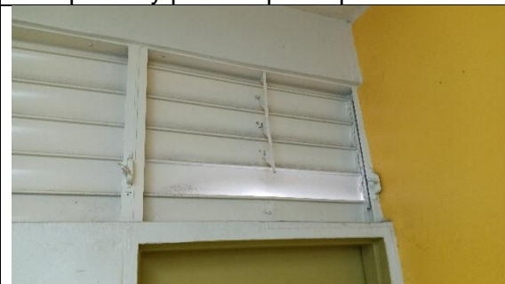
Remplazo de ventana en mal estado.
