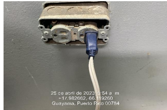
Ilustración 8. Reemplazo de receptáculo y plato de cubierta.
