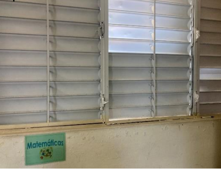
operadores de ventanas dañados
