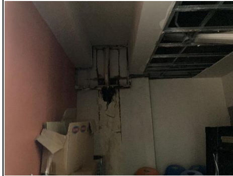
Gypsum board dañado
