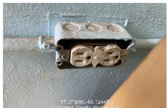
Ilustración 4. Reemplazo de receptáculo y plato de cubierta.
