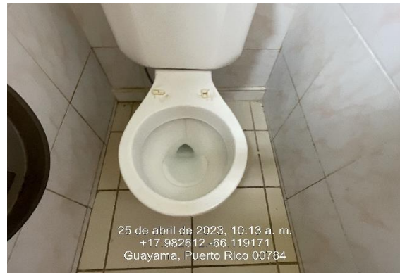
Ilustración 18. Instalación de tapa de inodoro.
