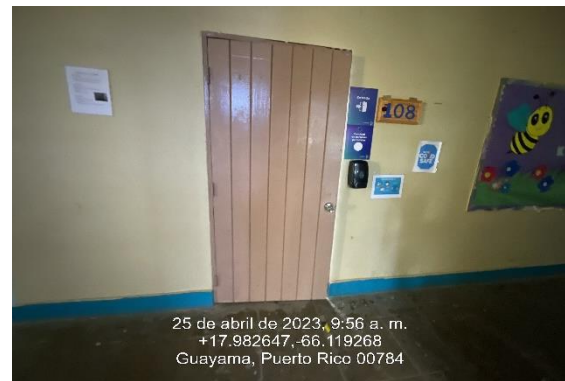
Ilustración 10. Reemplazo de puertas en madera por puertas en metal.
