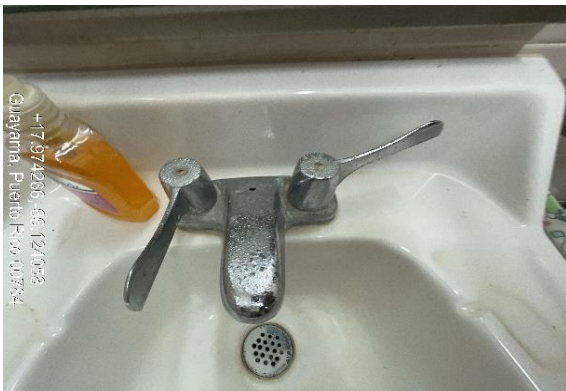
Ilustración 31. Reemplazo de mezcladora.
