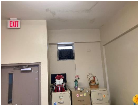
Gypsum board dañado
