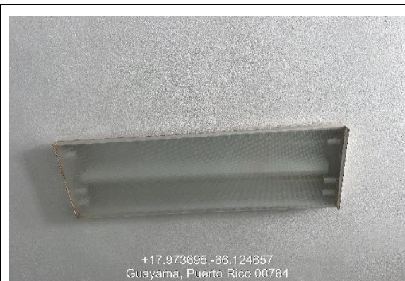
Ilustración 1. Reemplazo de tubo fluorescente.
