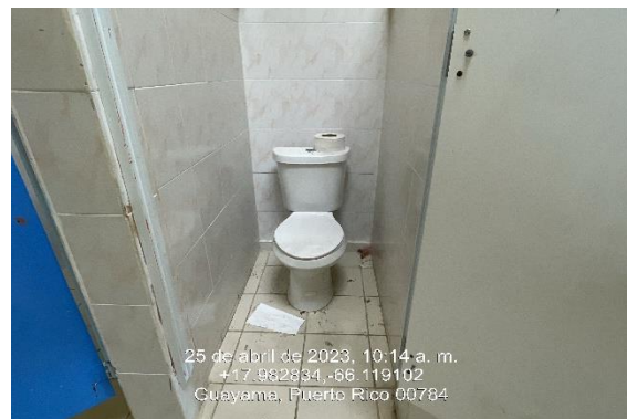
Ilustración 20. Reemplazo de inodoro de tanque.
