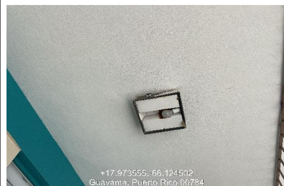
Ilustración 3. Reemplazo de luminaria exterior.
