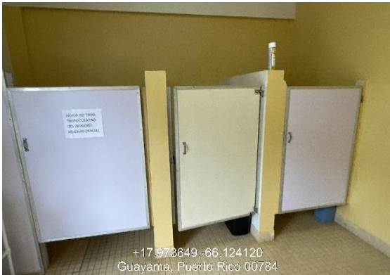
Ilustración 5. Reemplazo de puertas de particiones en metal y cerraduras.
