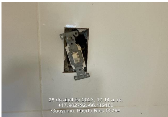
Ilustración 19. Reemplazo de interruptor de pared y plato de cubierta.
