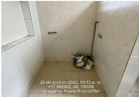
Ilustración 17. Instalación de urinales con válvula y "fittings".
