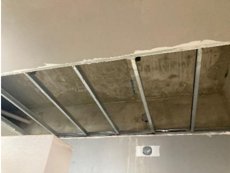
Gypsum board dañado
