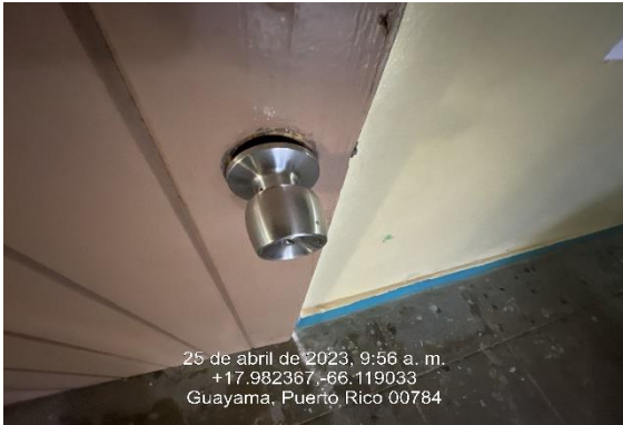
Ilustración 11. Reemplazo de cerraduras de puertas.
