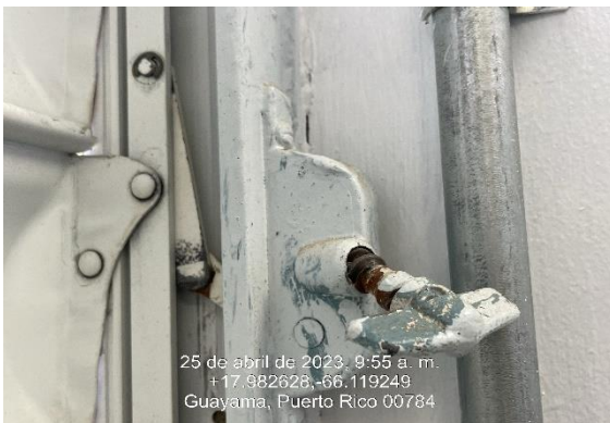
Ilustración 9. Reemplazo de operadores de ventanas.
