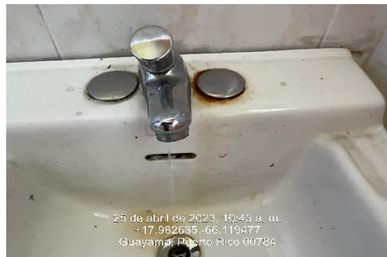
Ilustración 26. Reemplazo de mezcladoras.
