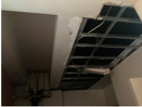
Gypsum board dañado
