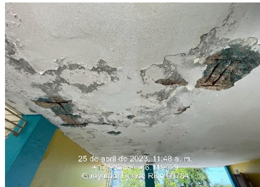
Ilustración 32. Empañetado de techo.
