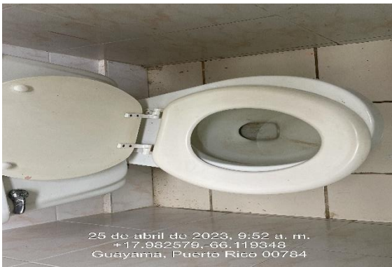
Ilustración 7. Reemplazo de tapa de inodoro.
