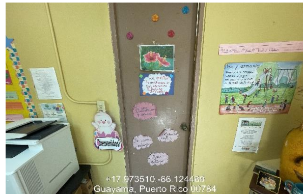
Ilustración 20. Reemplazo de puertas en maderas por puertas de metal.
