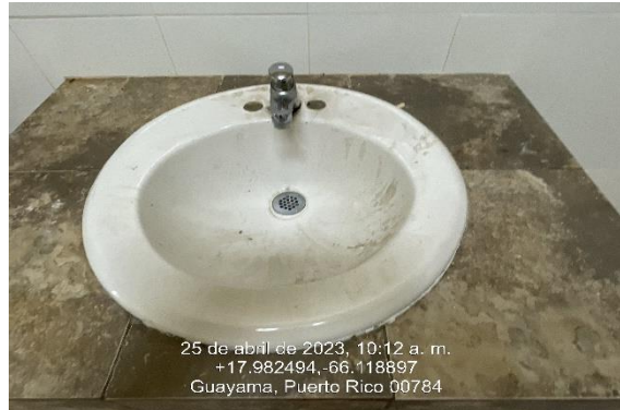
Ilustración 14. Reemplazo de lavamanos.
