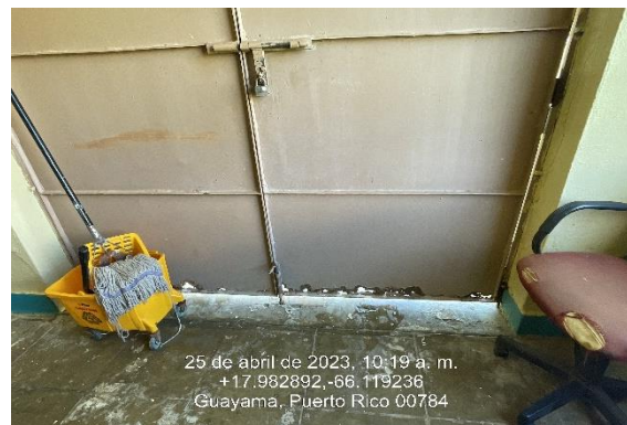
Ilustración 22. Reparación de puerta de tola.
