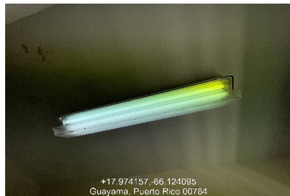
Ilustración 258. Reemplazo de luminarias.
