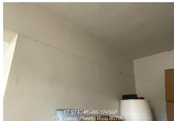
Ilustración 34. Grieta en pared del comedor.
