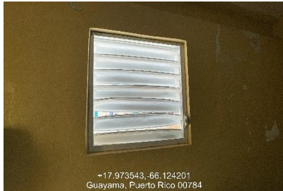
Ilustración 14. Reemplazo de ventana "miami".
