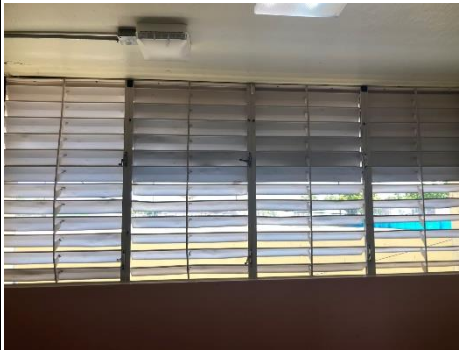
operadores de ventanas dañados
