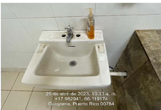
Ilustración 15. Reemplazo de lavamanos.
