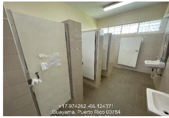
Ilustración 32. Reemplazo de puertas de particiones a metal y cerraduras.
