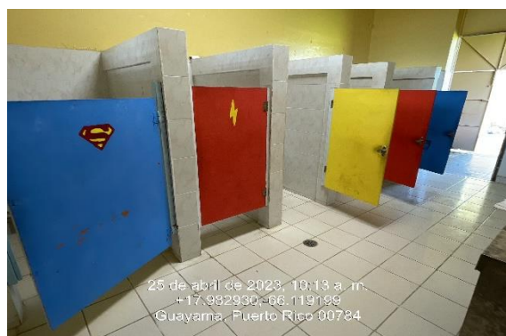
Ilustración 16. Reemplazo de puerta de particiones en Baños.
