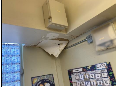
Gypsum board dañado
