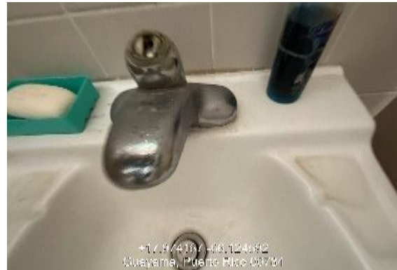
Ilustración 36. Reemplazo de mezcladora.
