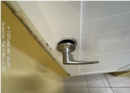
Ilustración 17. Reemplazo de cerraduras.
