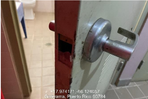
Ilustración 29. Reemplazo de cerraduras.
