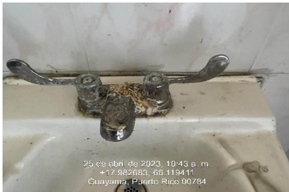
Ilustración 27. Reemplazo de mezcladora.
