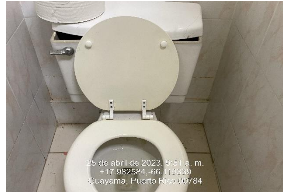
Ilustración 6. Reemplazo de inodoro de tanque.
