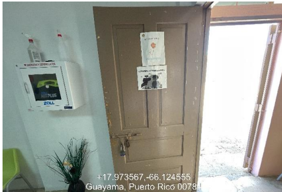
Ilustración 23. Reemplazo de puerta de madera por puerta de metal.
