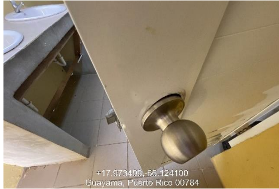
Ilustración 12. Reemplazo de cerraduras.
