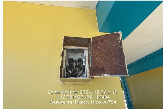
Ilustración 36. Reemplazo de caja eléctrica.
