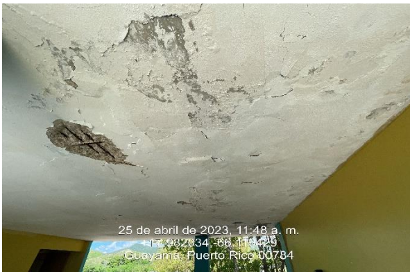
Ilustración 31. Empañetado de techo.
