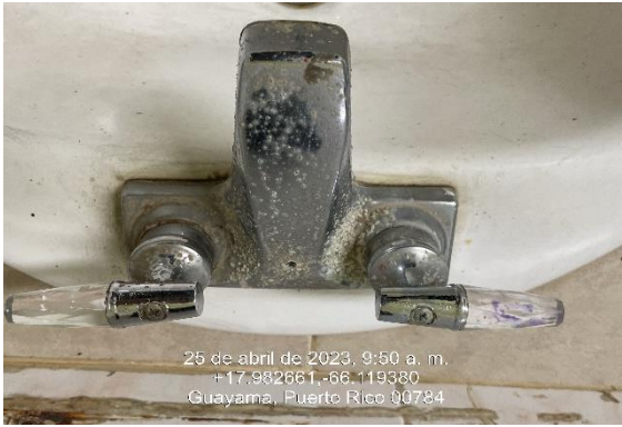
Ilustración 5. Reemplazo de mezcladoras.
