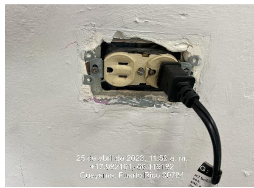
Ilustración 34. Reemplazo de receptáculo y plato de cubierta.
