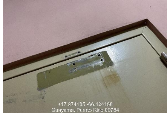
Ilustración 30. Reemplazo de hidráulico de puerta.
