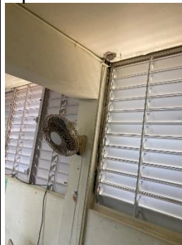
operadores de ventanas dañados
