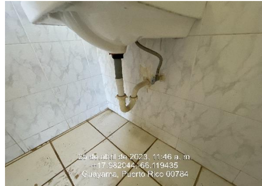
Ilustración 30. Reemplazo de sifón Y/O fittings lavamanos.
