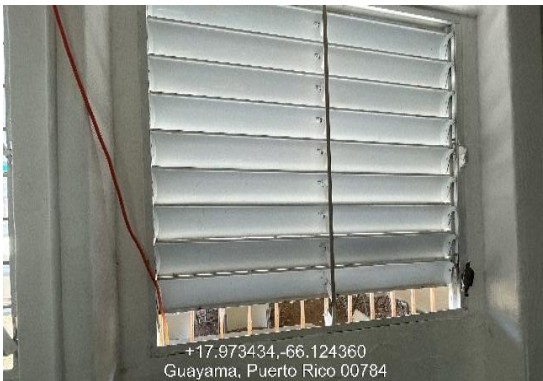
Ilustración 19. Reemplazo de ventana "miami".
