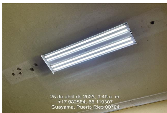
Ilustración 3. Reemplazo de luminarias.
