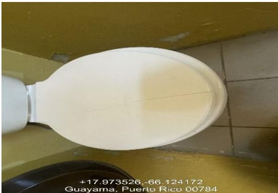
Ilustración 13. Reemplazo de tapa de inodoro.
