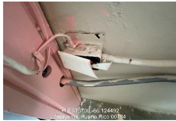
Ilustración 3826. Reemplazo de receptáculo y plato de cubierta.
