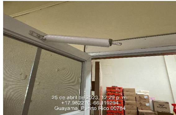
Ilustración 38. Reemplazo de hidráulico de puerta de screen.
