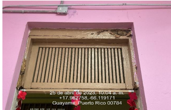
Ilustración 12. Cambiar estructuras de la parte superior de las puertas.
