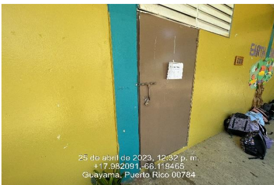
Ilustración 39. Reparación de puerta de tola.
