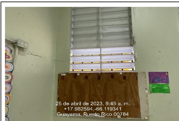
Ilustración 1. Reemplazo de ventanas en metal "Miami".
