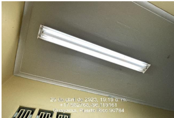
Ilustración 23. Reemplazo de luminaria.
