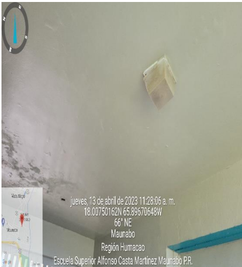
Falta de iluminación exterior
