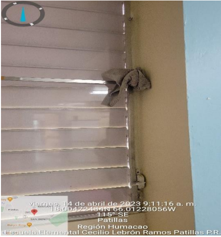
Ausencia de operadores
