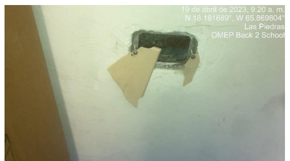
Ilustración 9. Instalación de una Tapa Ciega
