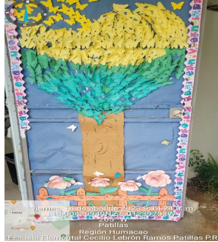
Puerta corroída para reemplazo
