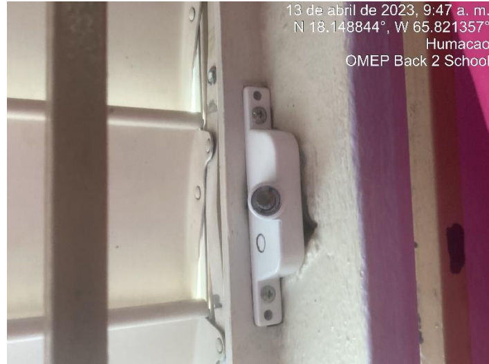
Instalación de operadores
