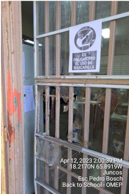
Reemplazo de screen en portón
