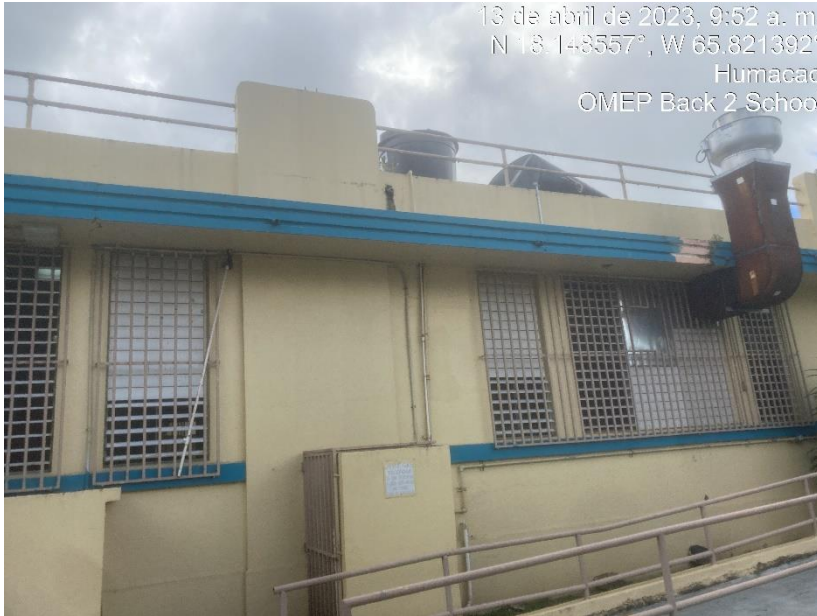
Removido de cisterna.
