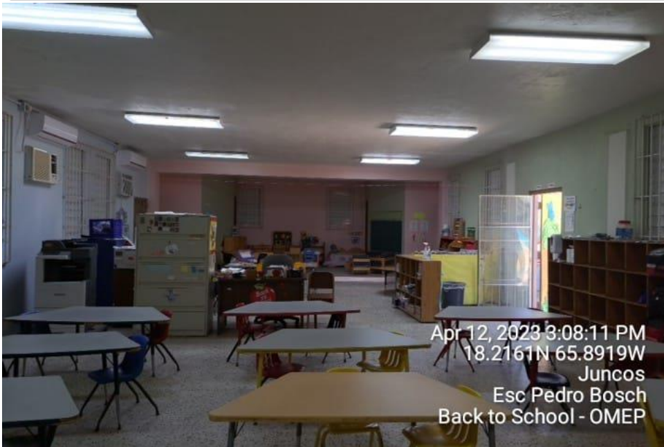
Salón de kínder ninguna ventana funciona
