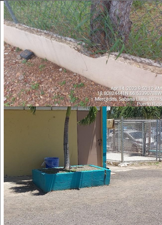
Reparacion de empanetado
