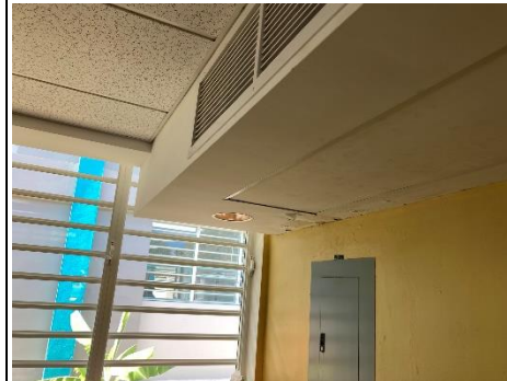
filtración A/C
