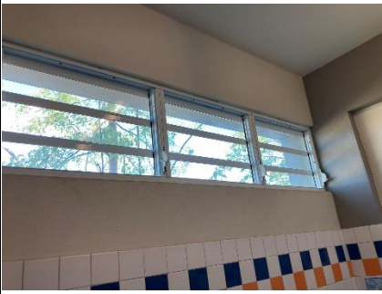
Operadores de ventanas dañado
