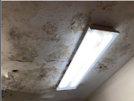
Pintura techo / filtración
