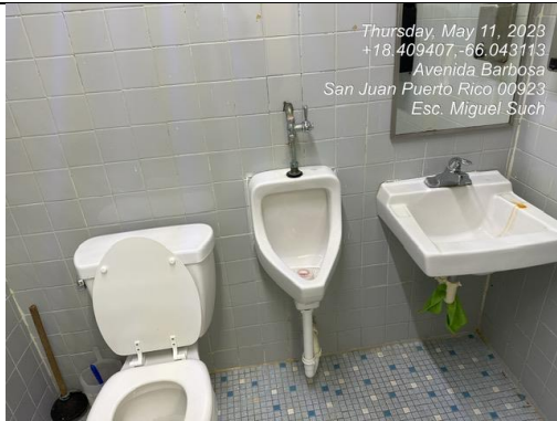
Ilustración 11. Eliminar urinal de baño de damas y colocar en otro lugar
