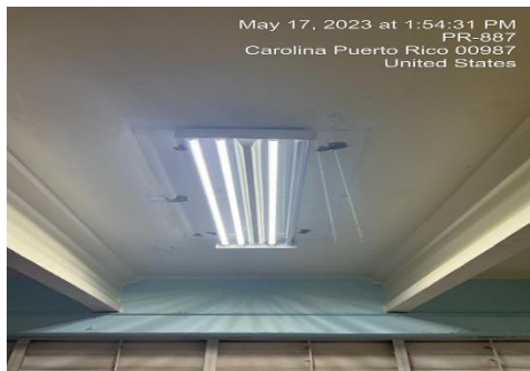
Ilustración 3. Reemplazar lámparas 2x4
