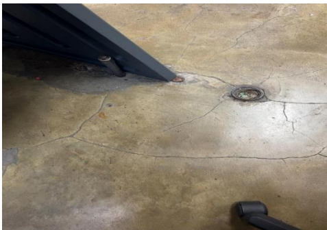
Ilustración 27. Resanar piso y pulirlo con resina epoxica
