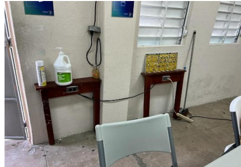
Ilustración 10. Instalar receptáculos nuevos en algunos salones
