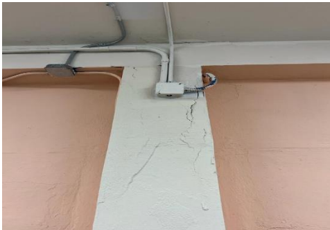
Ilustración 9. Resanar columna con FRP
