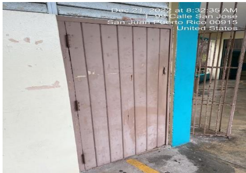
Ilustración 1. Reemplazar puertas de maderas por tolas
