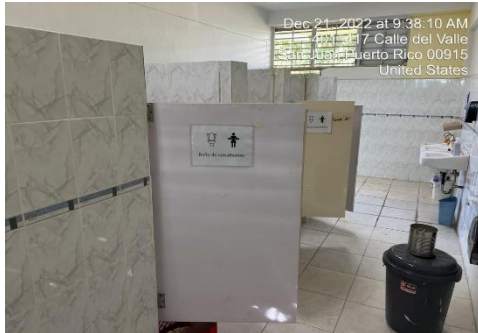
Ilustración 11. Reemplazar puertas de particiones por puertas de aluminio
