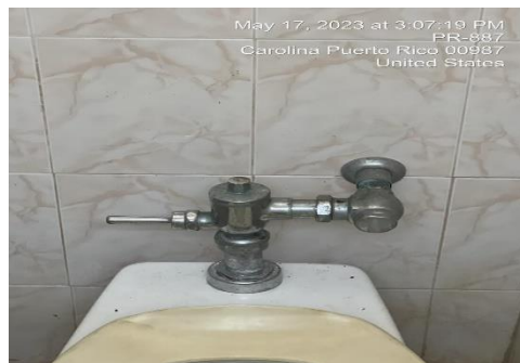
Ilustración 20. Reemplazar válvula de presión
