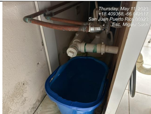
Ilustración 20. Sifón dañado
