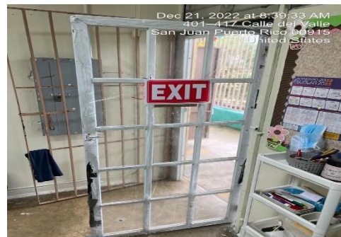
Ilustración 4. Reemplazar puertas de screens
