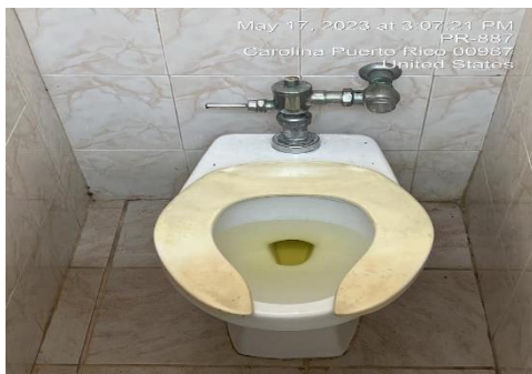
Ilustración 21. Reemplazar tapa de inodoros
