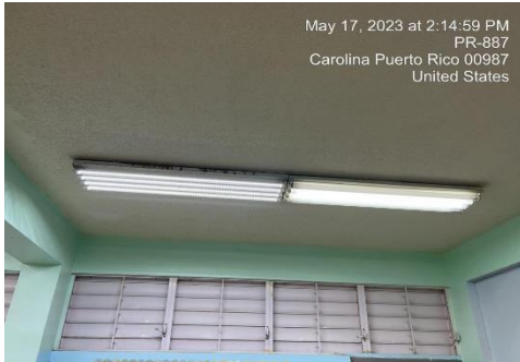
Ilustración 11. Reemplazo de lámparas
