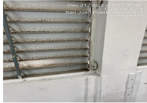
Ilustración 8. Reemplazar operadores de ventanas
