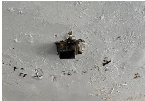
Ilustración 24. Reemplazar focos exteriores 12x12
