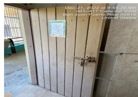
Ilustración 16. Reemplazar puertas de madera por tolas
