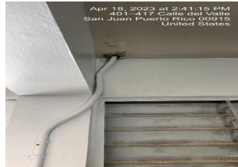
Ilustración 20. Rellenar y tapar orificio en el techo en el salón de Ciencias de miss. Fuentes
