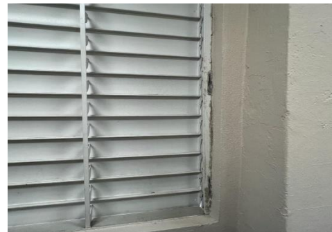
Ilustración 8. Reemplazo de operadores de ventanas
