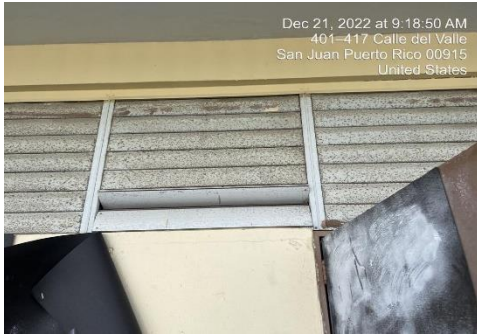
Ilustración 7. Reemplazar ventanas rotas
