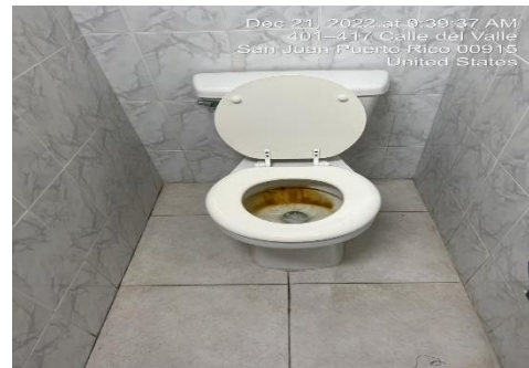
Ilustración 12. Reemplazo de inodoros de tanque
