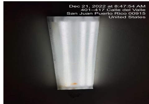
Ilustración 6. Reemplazar lámparas 2x4
