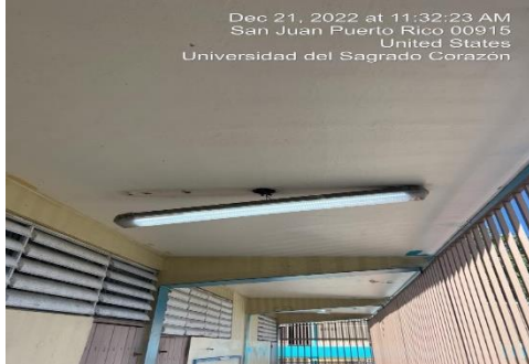
Ilustración 17. Reemplazar por focos exteriores 12x12
