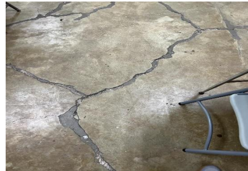
Ilustración 16. Resanar piso y pulirlo con resina epoxica
