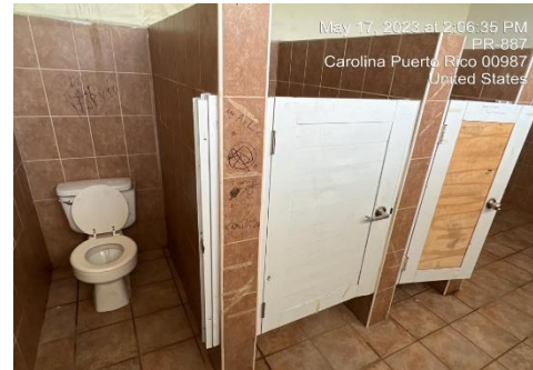
Ilustración 8. Reemplazar puertas de aluminio
