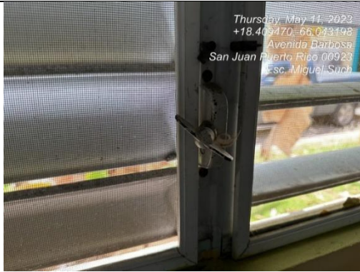
Ilustración 13. Operador roto
