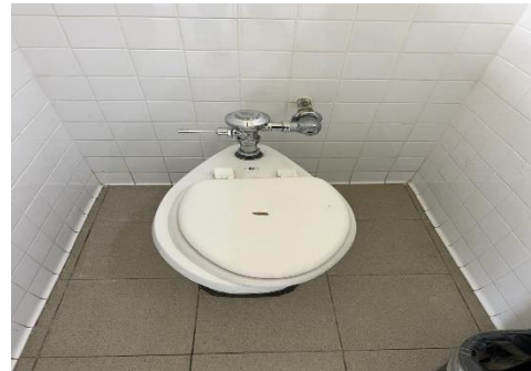
Ilustración 26. Reemplazo de tapas de inodoros
