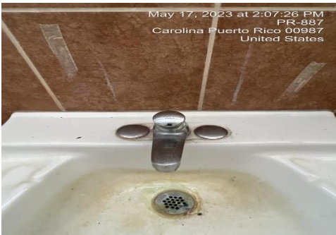
Ilustración 9. Reemplazar mezcladoras
