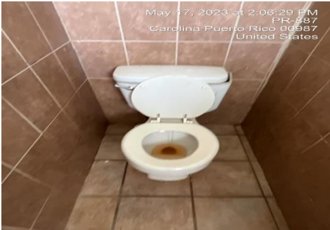
Ilustración 7. Reemplazar inodoro de tanque
