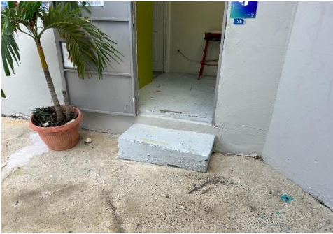
Ilustración 7. Salón que hay que construir 3 escalones con pasamanos. salón #35
