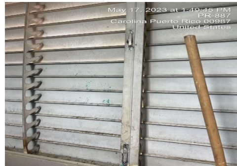
Ilustración 2. Reemplazar operadores de ventanas
