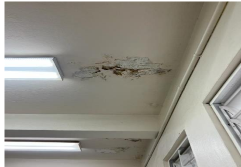
Ilustración 14. Resanar grietas y filtración
