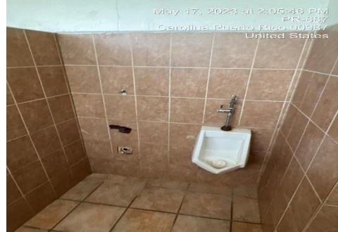
Ilustración 6. Reemplazar uriniales
