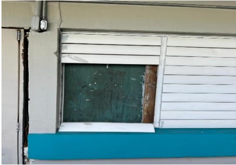
Ilustración 29. Reemplazar ventanas rotas
