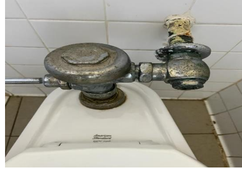
Ilustración 28. Reemplazo de válvulas de presión
