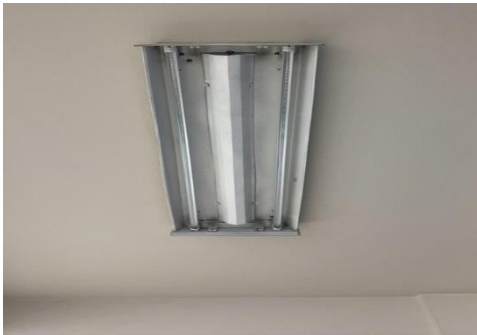
Ilustración 13. Reemplazar lámparas 2x4
