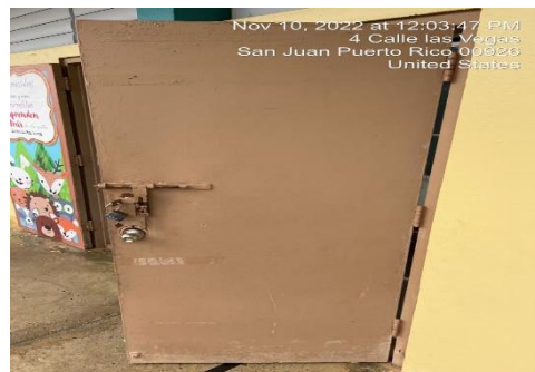
Ilustración 22. Reemplazar puerta de tolas
