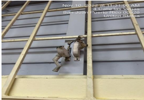
Ilustración 17. Reemplazar operadores de ventanas
