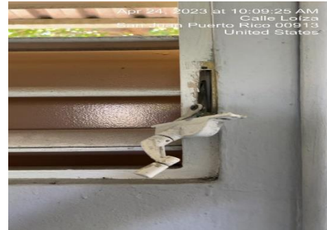
Ilustración 14. Reemplazar operados de ventanas
