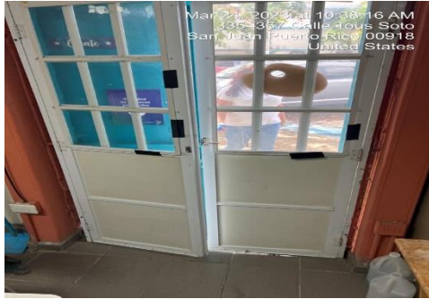
Ilustración 5. Reemplazar puertas de screens
