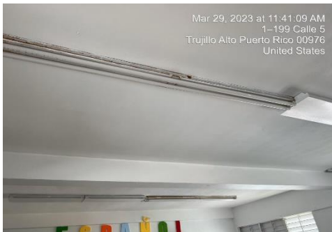
Ilustración 15. Reemplazar lámparas 2x4 con luces LED
