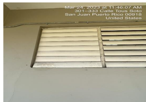
Ilustración 14. Reemplazo de ventanas
