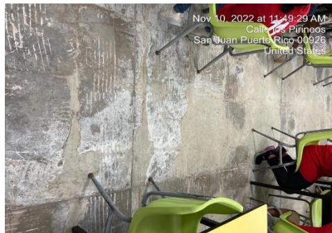
Ilustración 19. Instalación de losas en el comedor
