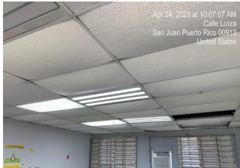
Ilustración 13. Instalación de plafón acústico y reemplazo de lámparas 2x4
