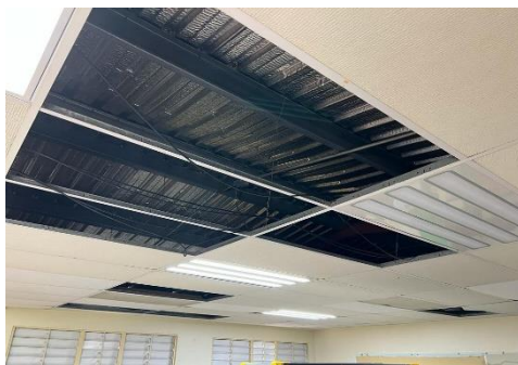
Ilustración 15. Instalar plafones acústicos
