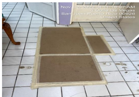
Ilustración 15. Demolición e instalación de losas en la oficina
