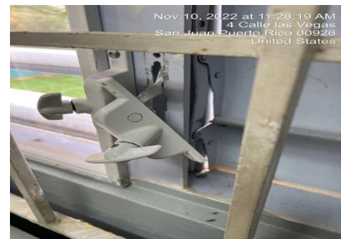
Ilustración 16. Reemplazar los operadores de ventanas
