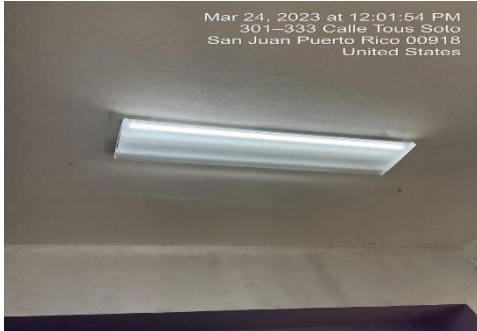
Ilustración 17. Instalar tubos de luce LED restante
