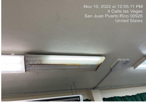
Ilustración 23. Reemplazar lámparas 2x4
