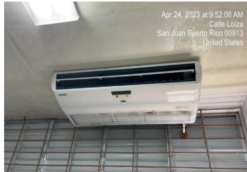
Ilustración 10. Mantenimiento de A/C
