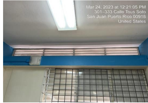
Ilustración 24. Sellar con bloques y hormigón las rejillas fijas de madera pagada al techo y la pared. En todos los salones del segundo nivel que conta con 7 salones
