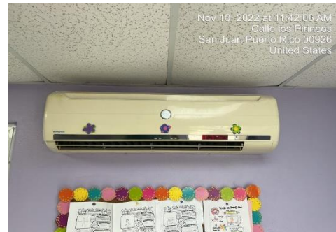
Ilustración 18. Mantenimiento de A/C
