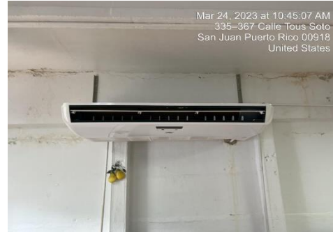
Ilustración 8. Mantenimiento de A/C
