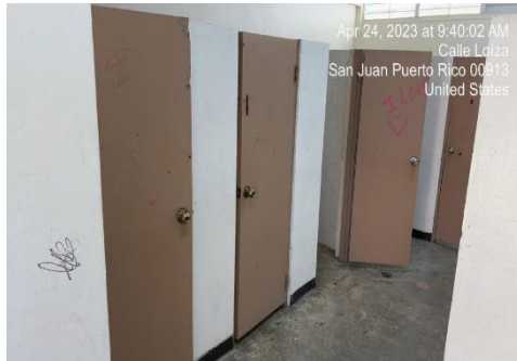
Ilustración 7. Reemplazar puertas de partición por puertas de aluminio con su cerradura
