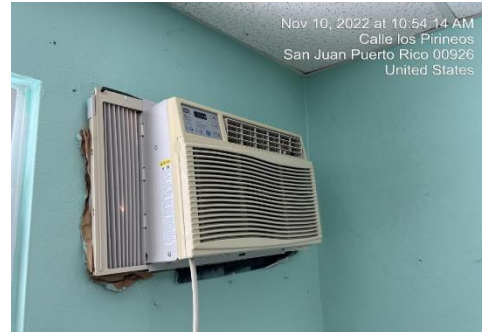
Ilustración 6. Mantenimiento de A/C
