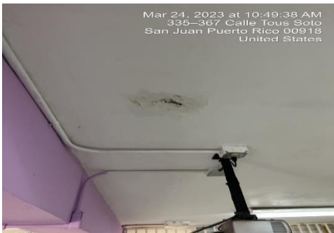
Ilustración 9. Tratamiento de varillas expuestas
