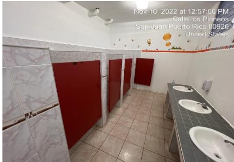
Ilustración 35. Reemplazar puertas de división de los baños por puertas de aluminio
