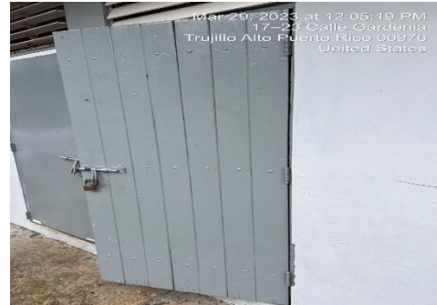
Ilustración 18. Reemplazar por puertas de tolas
