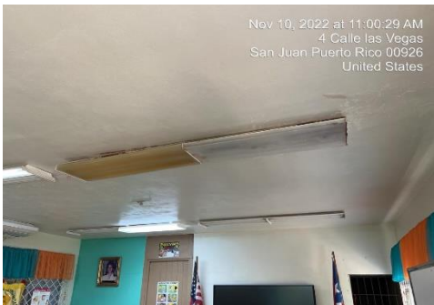
Ilustración 7. Reemplazar lámparas 2x4
