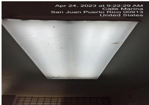
Ilustración 1. Reemplazar lámparas 2x4 en LED
