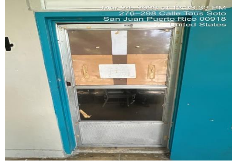
Ilustración 26. Reemplazar puertas de screen
