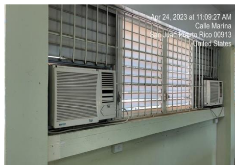
Ilustración 22. Mantenimiento de A/C
