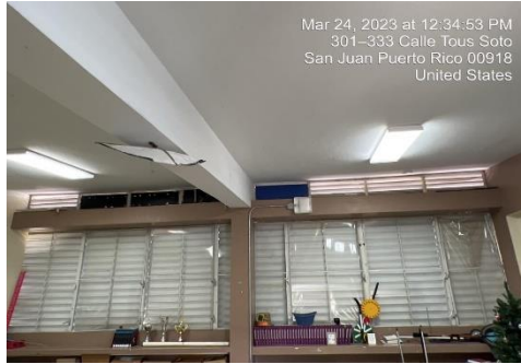
Ilustración 25. Sellar con bloques y hormigón las rejillas fijas de madera pagada al techo y la pared. En todos los salones del segundo nivel que conta con 7 salones
