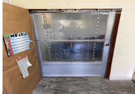
Ilustración 12. Reemplazar puertas de screens
