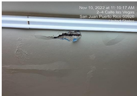
Ilustración 13. Tratamiento de varilla expuesta
