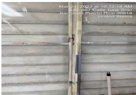
Ilustración 3. Reemplazo o instalación de operadores de ventanas
