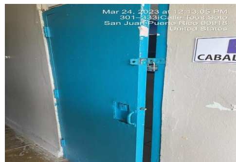
Ilustración 22. Reemplazar puerta de tola
