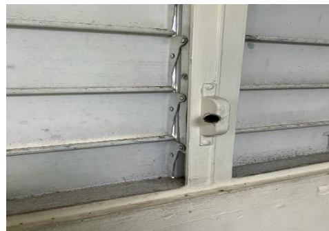
Ilustración 16. Reemplazar operadores de ventanas
