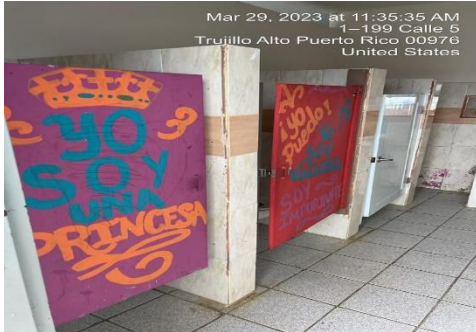
Ilustración 11. Reemplazar puertas de partición por puertas de aluminio
