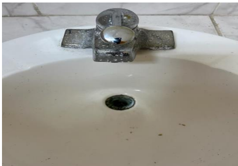
Ilustración 19. Reemplazar mezcladoras
