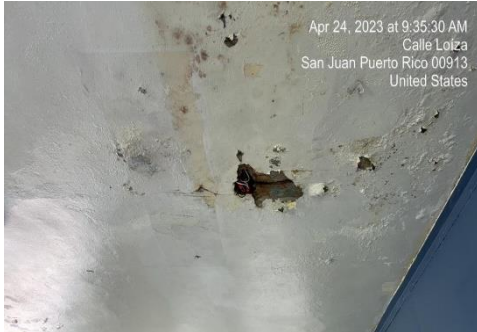
Ilustración 5. Resanar y administrar tratamiento de varillas expuestas
