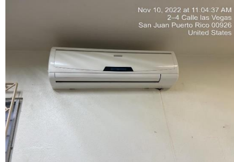
Ilustración 12. Mantenimiento de A/C
