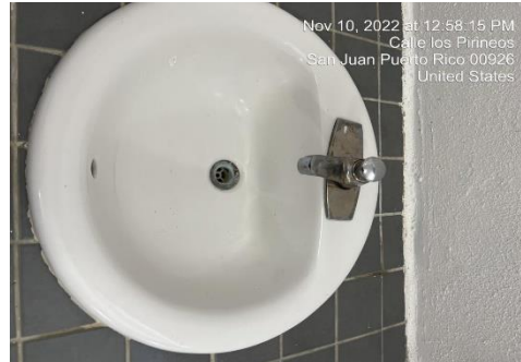
Ilustración 36. Reemplazar mezcladoras de los baños
