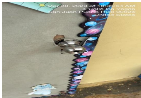
Ilustración 37. Reemplazar cerraduras del tercer grado
