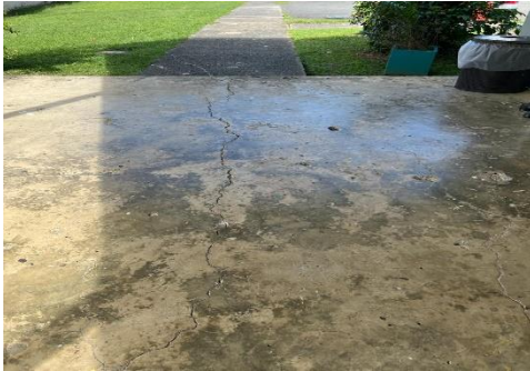
Ilustración 23. Resanar y pulir piso del lobby
