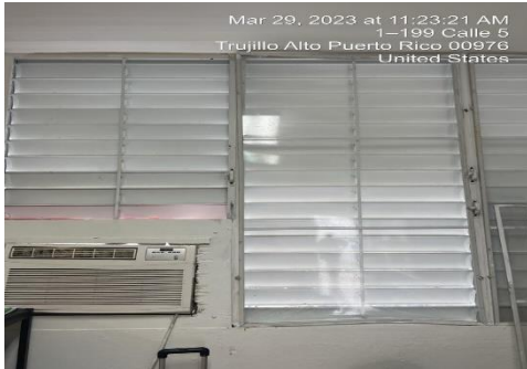
Ilustración 5. Reemplazo de screens y mantenimiento de A/C
