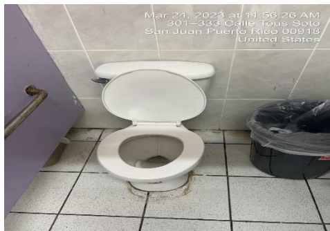
Ilustración 15. Reemplazo de inodoros
