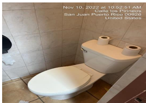
Ilustración 3. Reemplazar inodoros de kínder por unos inodoros pequeños
