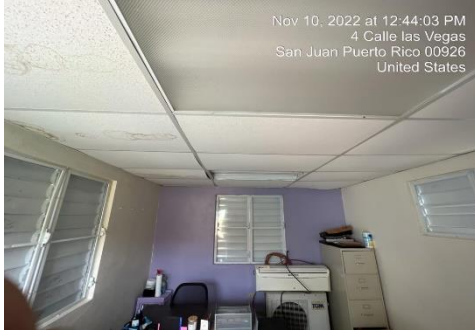
Ilustración 29. Reemplazar plafón acústico
