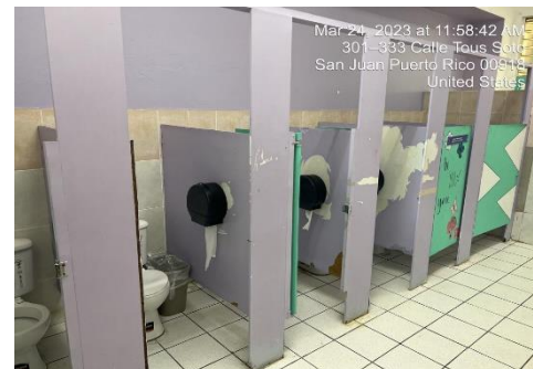
Ilustración 16. Remplazo de los cubículos de división de baños y eliminar uno para agrandar el cubículo de Ley ADA actual ambos baños de niños y niñas
