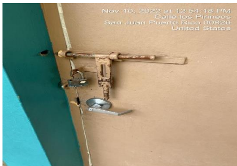
Ilustración 33. Reemplazar puerta de tolas
