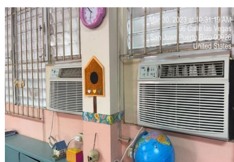
Ilustración 34. Mantenimiento de A/C
