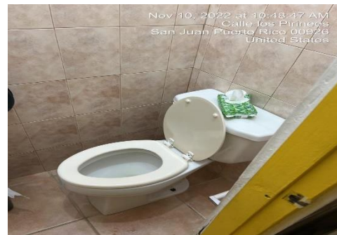
Ilustración 2. Reemplazar inodoros de kínder por unos inodoros pequeños
