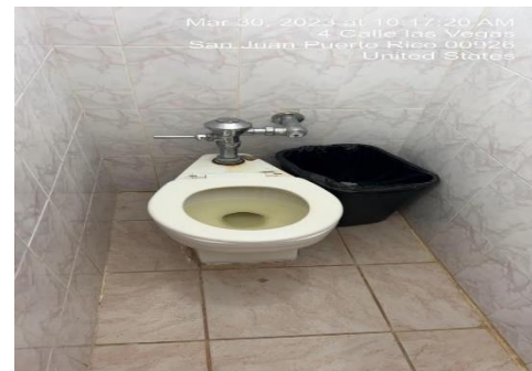
Ilustración 28. Reemplazar de inodoros Top Spud
