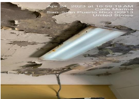
Ilustración 21. Reemplazar lámparas 2x4 en LED
