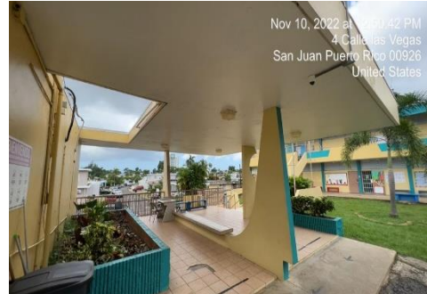
Ilustración 30. Reemplazar losas y foco exteriores
