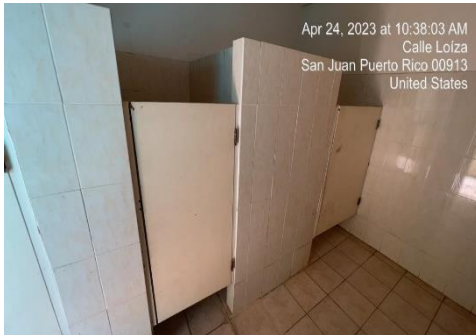
Ilustración 17. Reemplazar puertas de tolas por puertas de aluminio
