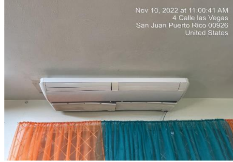
Ilustración 10. Mantenimiento de A/C
