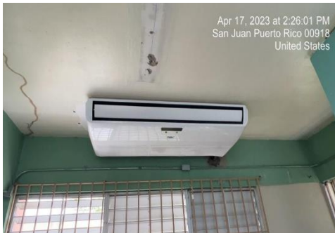
Ilustración 9. Mantenimiento de A/C
