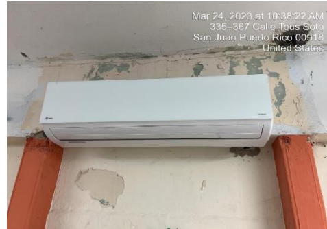
Ilustración 6. Mantenimiento de A/C
