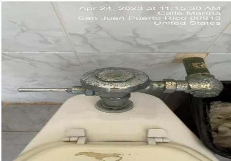
Ilustración 25. Reemplazar válvula de presión
