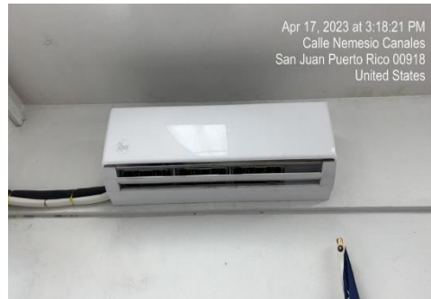
Ilustración 20. Mantenimiento de A/C
