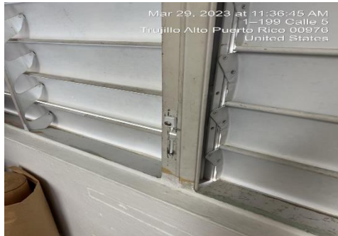
Ilustración 13. Reemplazar operadores
