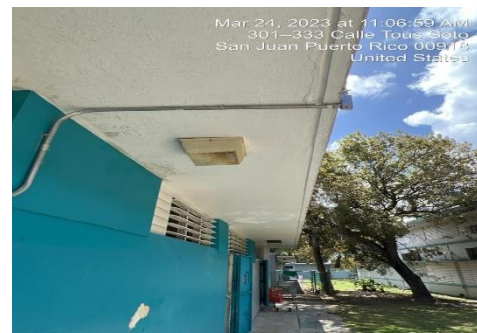
Ilustración 10. Reemplazo de focos
