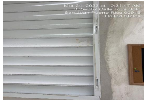
Ilustración 2. Reemplazo o instalación de operadores de ventanas
