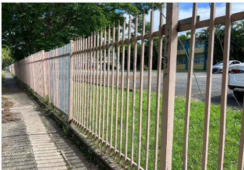
Ilustración 21. Reparación de rejas en el estacionamiento
