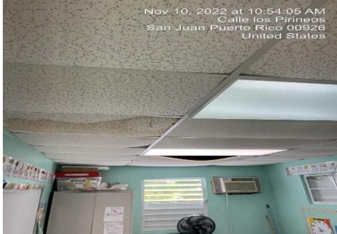
Ilustración 5. Reemplazar plafones acústicos
