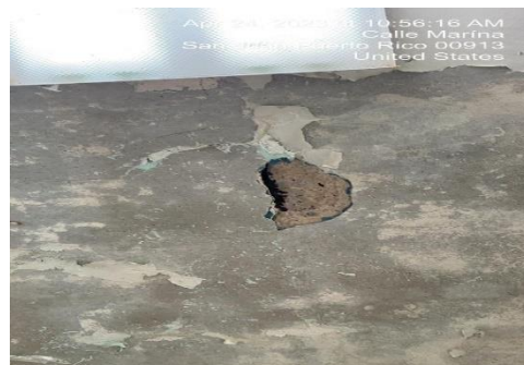
Ilustración 20. Tratamiento de varillas expuestas
