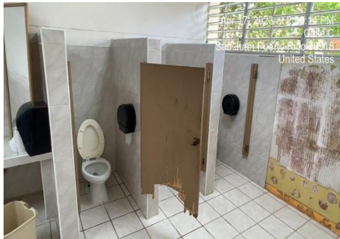
Ilustración 13. Reemplazar puerta de partición por puestas de aluminio y reemplazar tapas de inodoros
