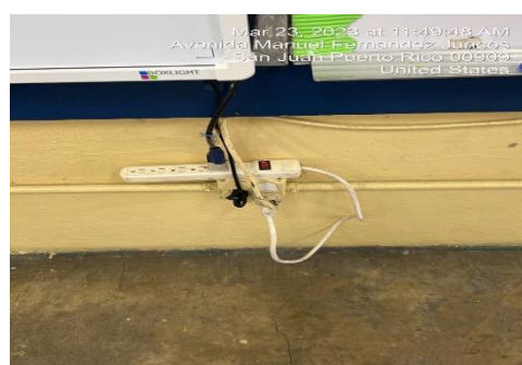
Ilustración 10. Instalar y alambrear para receptáculos nuevos 2 por salones
