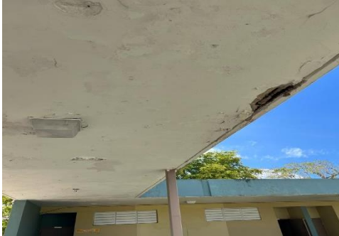
Ilustración 11. Tratamiento de varillas expuestas
