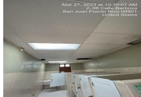
Ilustración 12. Reemplazos de plafón acústicos
