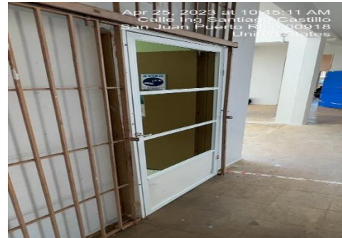
Apr 25, 2023 at 10:45:11 AM Calle Ing Santiago Castillo San Juan Puerto Rico 00918 United States Ilustración 24. Reemplazar puertas de screen
