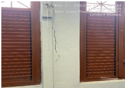
Ilustración 21. Repicar y resanar las paredes
