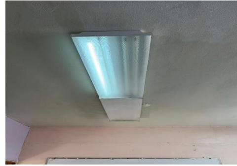
Ilustración 2. Instalar luces LED restante
