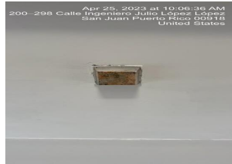
Ilustración 16. Reemplazar focos exteriores 12x12
