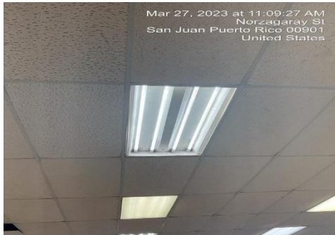
Ilustración 19. Reemplazo de lámparas 2x4 con tubos LED
