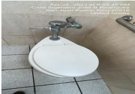
Ilustración 13. Reemplazar tapas de inodoros
