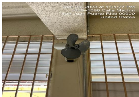
Ilustración 22. Reemplazo de abanicos
