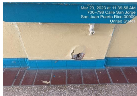
Ilustración 8. Varillas expuestas
