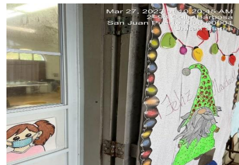
Ilustración 4. Reemplazo de puertas de tolas
