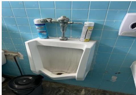
Ilustración 21. Reemplazar urinal con válvula
