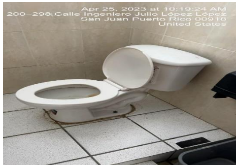
Ilustración 19. Reemplazar inodoro dentro de un salón
