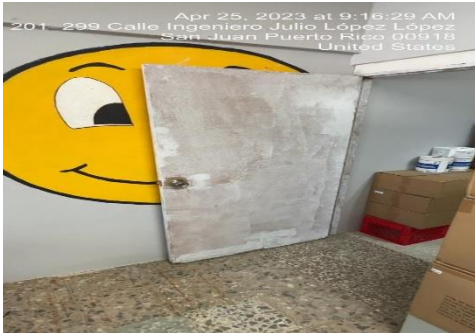
Ilustración 5. Reemplazar puerta de madera por puerta de tola
