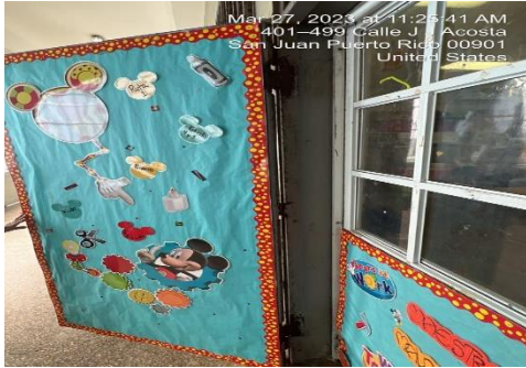
Ilustración 23. Reemplazar puerta de tola
