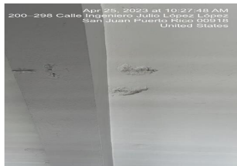
Ilustración 22. Tratamiento de varillas expuestas
