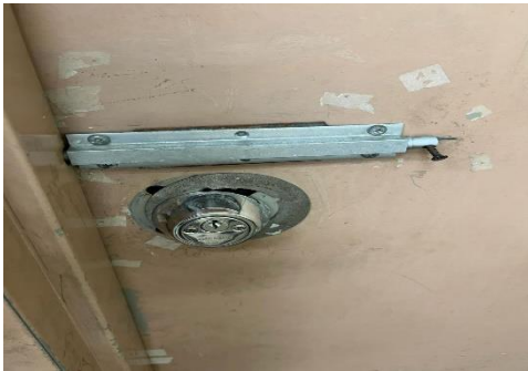
Ilustración 7. Reemplazar cerraduras
