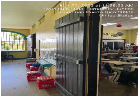
Ilustración 13. Reemplazo de puerta por tola
