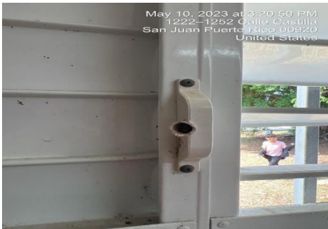
Ilustración 9. Reemplazar operadores de ventanas
