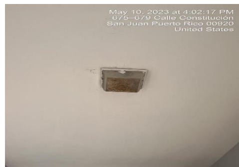
Ilustración 16. Reemplazar focos externos 12x12
