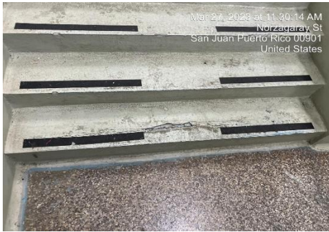
Ilustración 25. Resanar escalones de las escaleras
