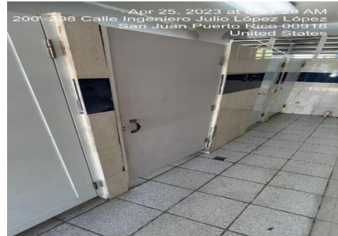
Ilustración 14. Reemplazar puertas de partición por puertas de aluminio
