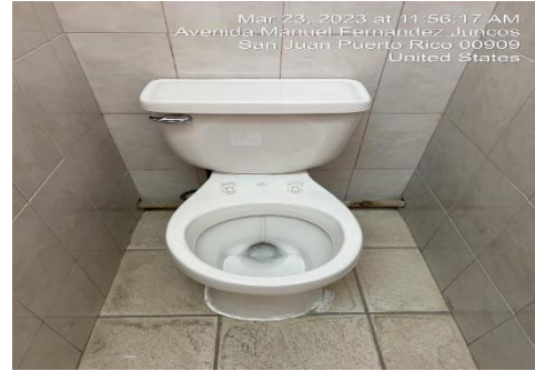
Ilustración 12. Reemplazar las tapas de los inodoros
