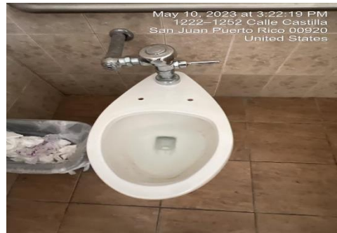
Ilustración 10. Reemplazar tapa de inodoros
