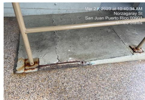
Ilustración 14. Resanar y aplicar tratamiento de varilla expuesta
