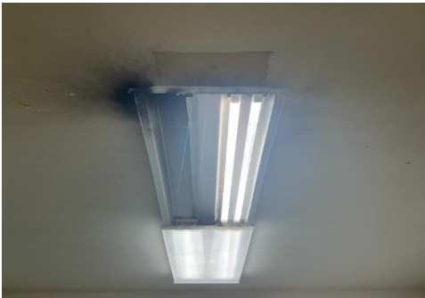
Ilustración 13. Reemplazar lámparas 2x4 LED
