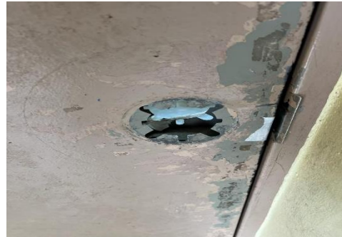
Ilustración 12. Reemplazar cerraduras
