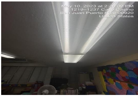
Ilustración 1. Instalar tubos de luces LED restante
