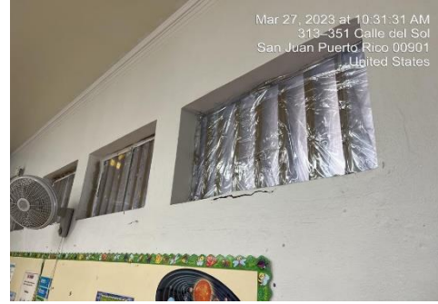
Ilustración 8. Reemplazar los screens
