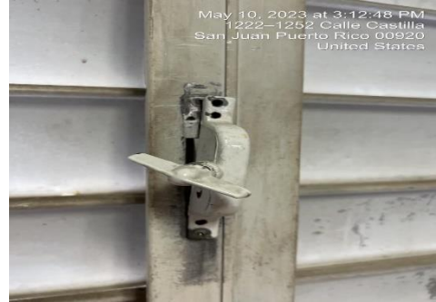
Ilustración 6. Reemplazar operadores de ventanas
