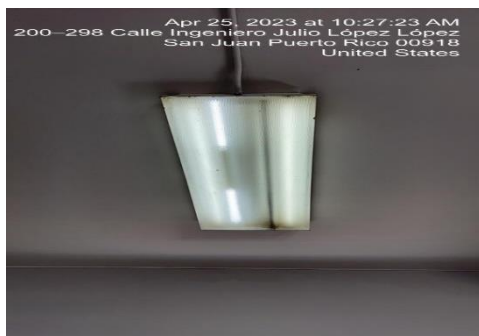
Ilustración 21. Reemplazar lámparas 2x4 con tubos LED
