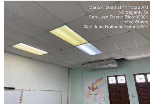
Ilustración 20. Reemplazo de lámparas 2x4 con tubos LED
