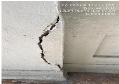
Ilustración 13. Repicar, resanar y tratamiento a varillas expuestas
