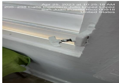
Ilustración 20. Reemplazar operadores de ventas
