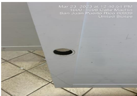
Ilustración 21. Reemplazos de cerraduras
