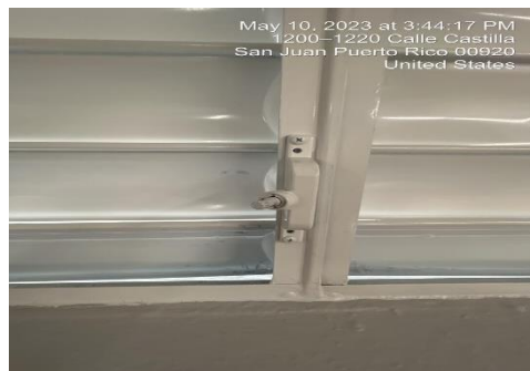
Ilustración 14. Reemplazar operadores de ventanas
