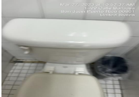
Ilustración 17. Reemplazar válvulas de inodoros de tanques
