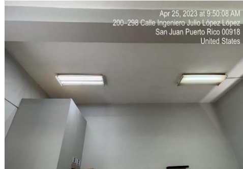
Ilustración 12. Reemplazar lámparas 2x4 con tubos LED
