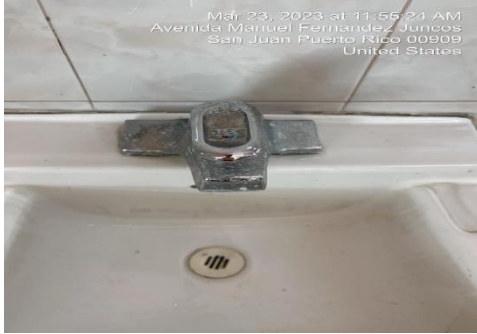
Ilustración 11. Reemplazo de mezcladoras
