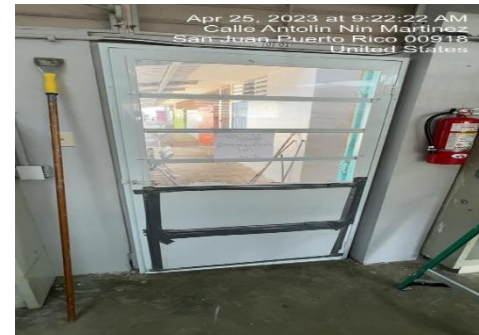
Ilustración 8. Reemplazar puertas de screen
