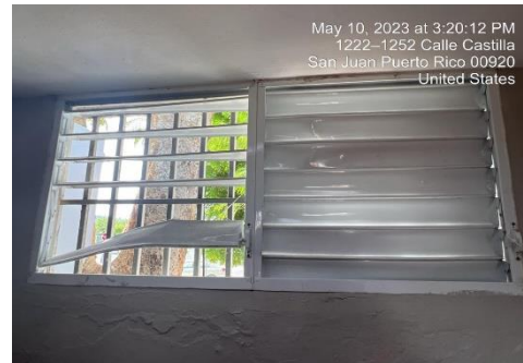
Ilustración 8. Reemplazar ventanas del baño
