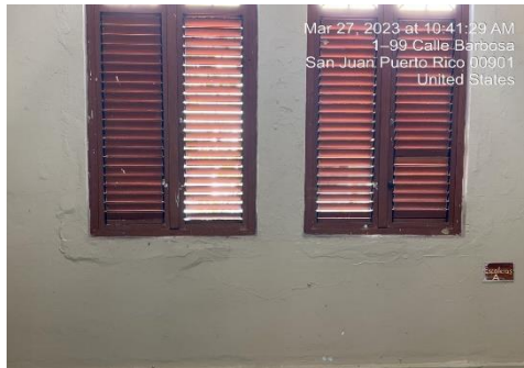
Ilustración 15. Repicar y resanar mochetas de las ventanas
