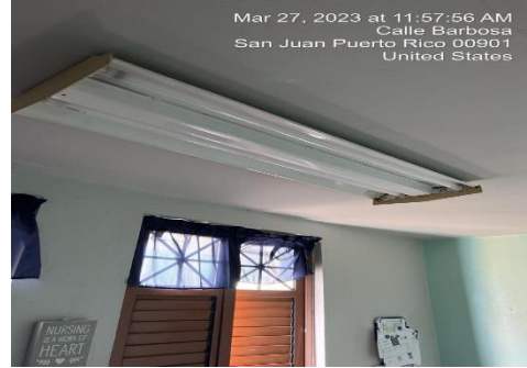
Ilustración 28. Reemplazar lámparas 2x4 con tubos LED
