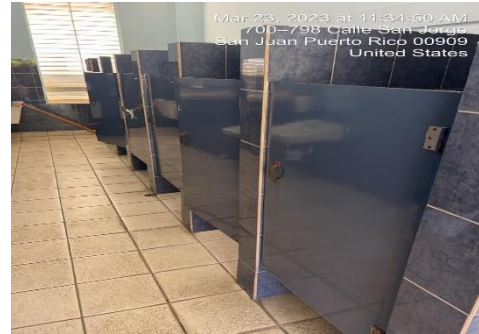
Ilustración 6. Reemplazo de puertas de particiones por puertas de aluminio con su cerradura
