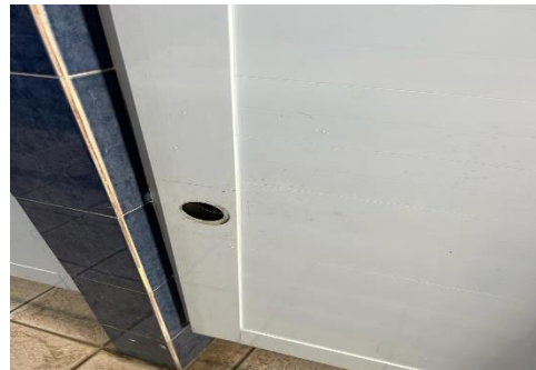
Ilustración 16. Reemplazo de cerraduras
