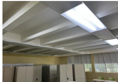
Ilustración 10. Instalar luces LED restantes
