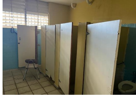
Ilustración 20. Reemplazar puertas de partición por puertas de aluminio
