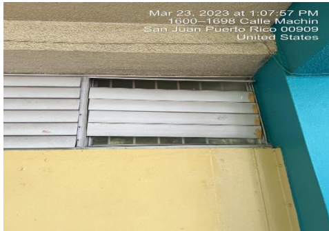
Ilustración 23. Reemplazar ventanas
