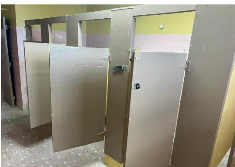
Ilustración 15. Reemplazar puertas de particiones por puertas de aluminio
