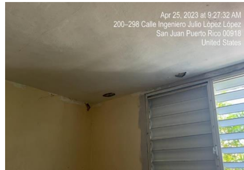
Ilustración 10. Tratamiento de varillas expuestas
