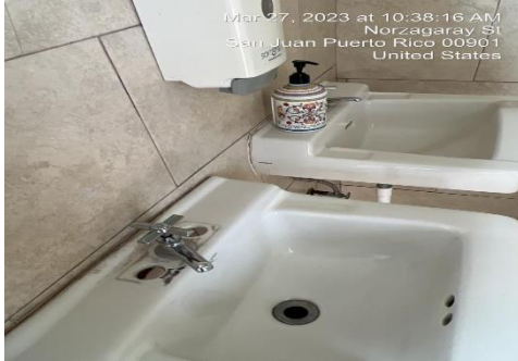
Ilustración 11. Reemplazo de mezcladoras
