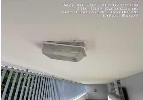
May 10, 2023 at 4:07:09 PM 1219-1237 Calle Casino San Juan Puerto Rico 00920 United States Ilustración 17. Reemplazar focos externos 12x12
