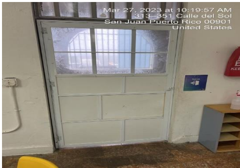
Ilustración 1. Reemplazo de puertas de screens
