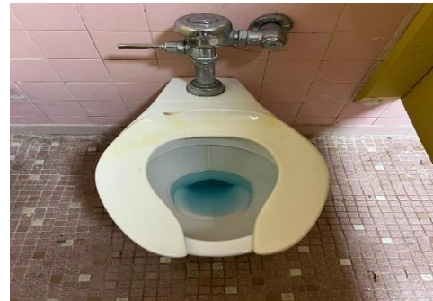
Ilustración 14. Reemplazar tapas de inodoros
