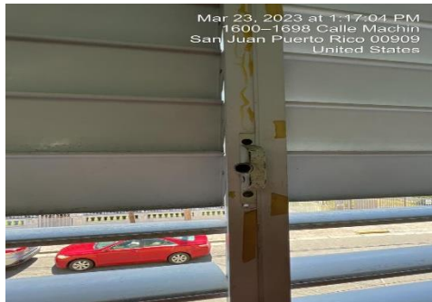
Ilustración 25. Reemplazo de operadores
