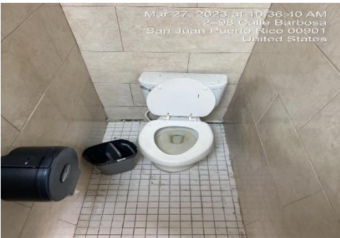
Ilustración 9. Reemplazo de inodoros
