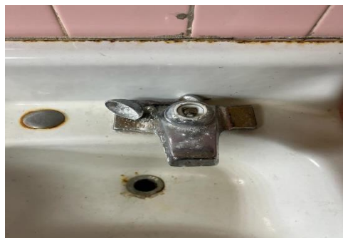
Ilustración 16. Reemplazar mezcladoras
