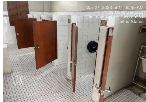
Ilustración 18. Reemplazo de puertas de partición por puertas de aluminio con sus cerraduras
