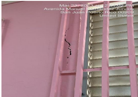
Ilustración 19. Repicar, resanar y tratamiento de varillas expuestas
