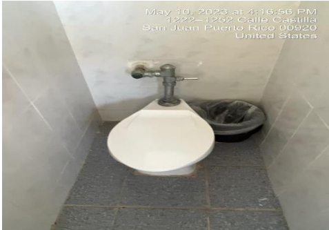
May 10, 2023 at 4:16:56 PM 1222-1252 Calle Castilla San Juan Puerto Rico 00920 United States Ilustración 19. Reemplazar tapa de inodoros
