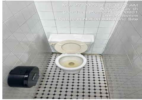
Ilustración 26. Reemplazo de inodoros
